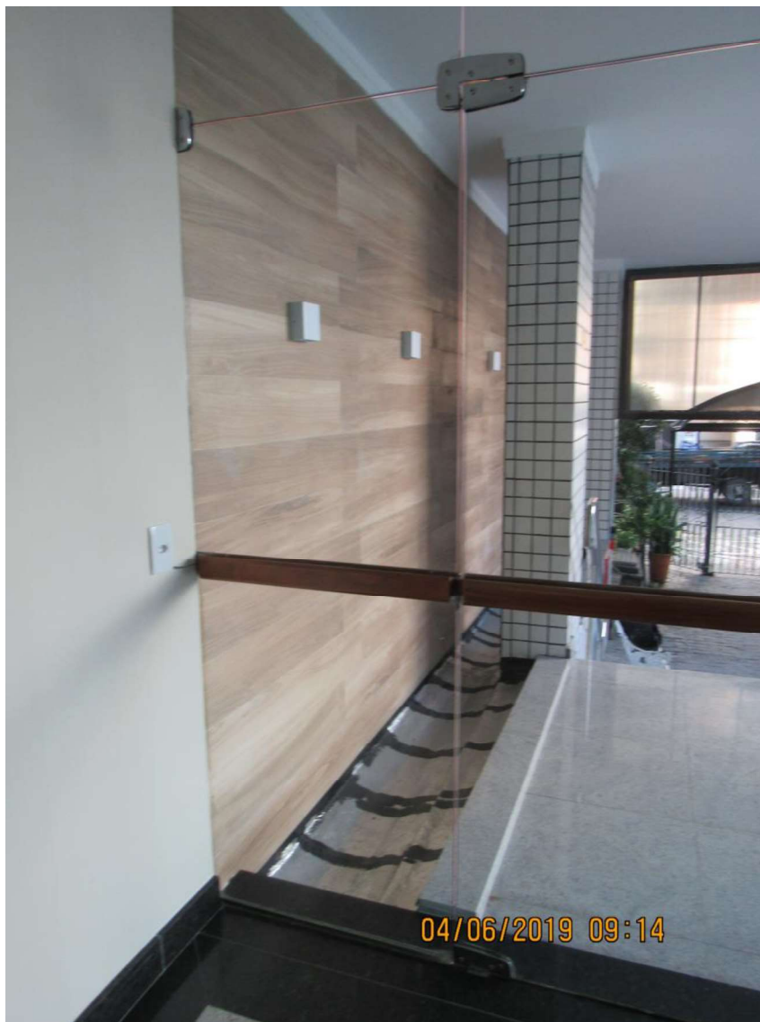
Imagem 18: hall social – detalhe impermeabilização de jardim
