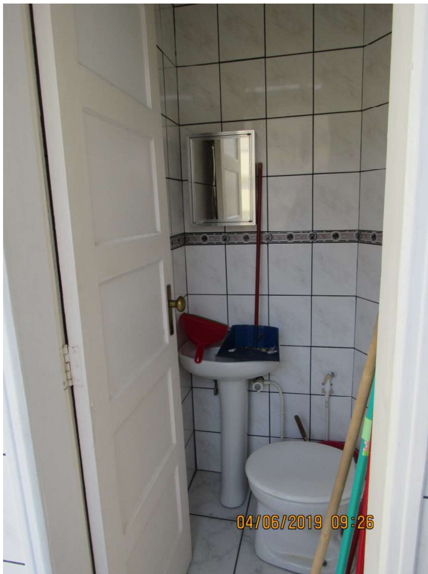
Imagem 28: meio banheiro – área de serviço
