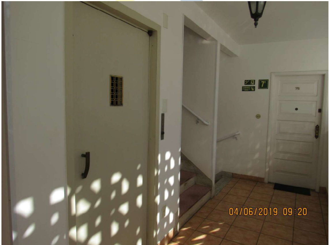
Imagem 22: elevador de serviço - 7º andar
