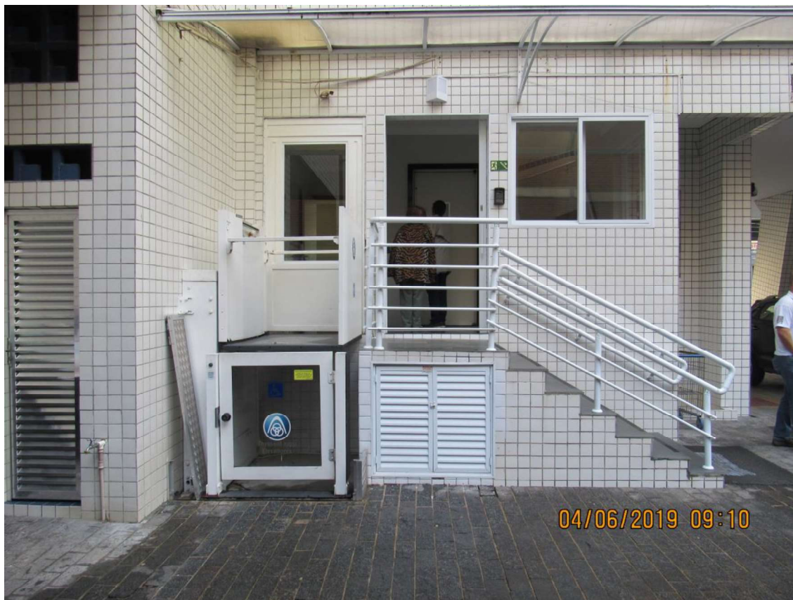
Imagem 12: acessibilidade (elevador) para hall
