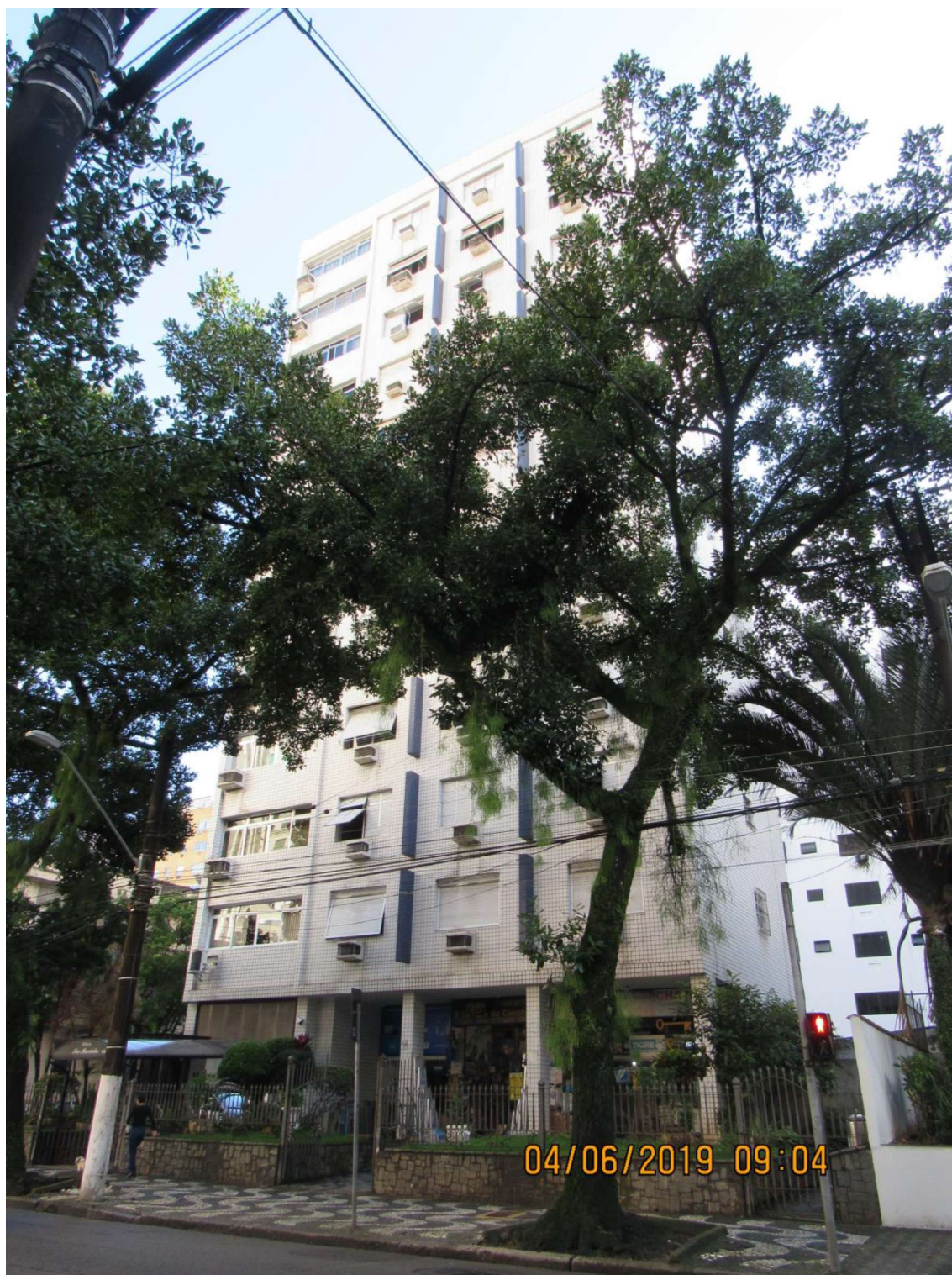
Imagem 3: Vista frontal ao imóvel periciado – Rua Galeão Carvalhal
