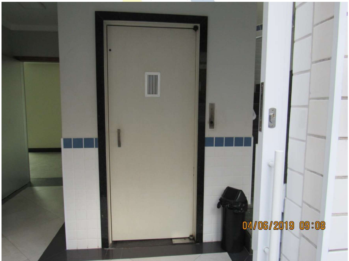
Imagem 11: elevador de serviço
