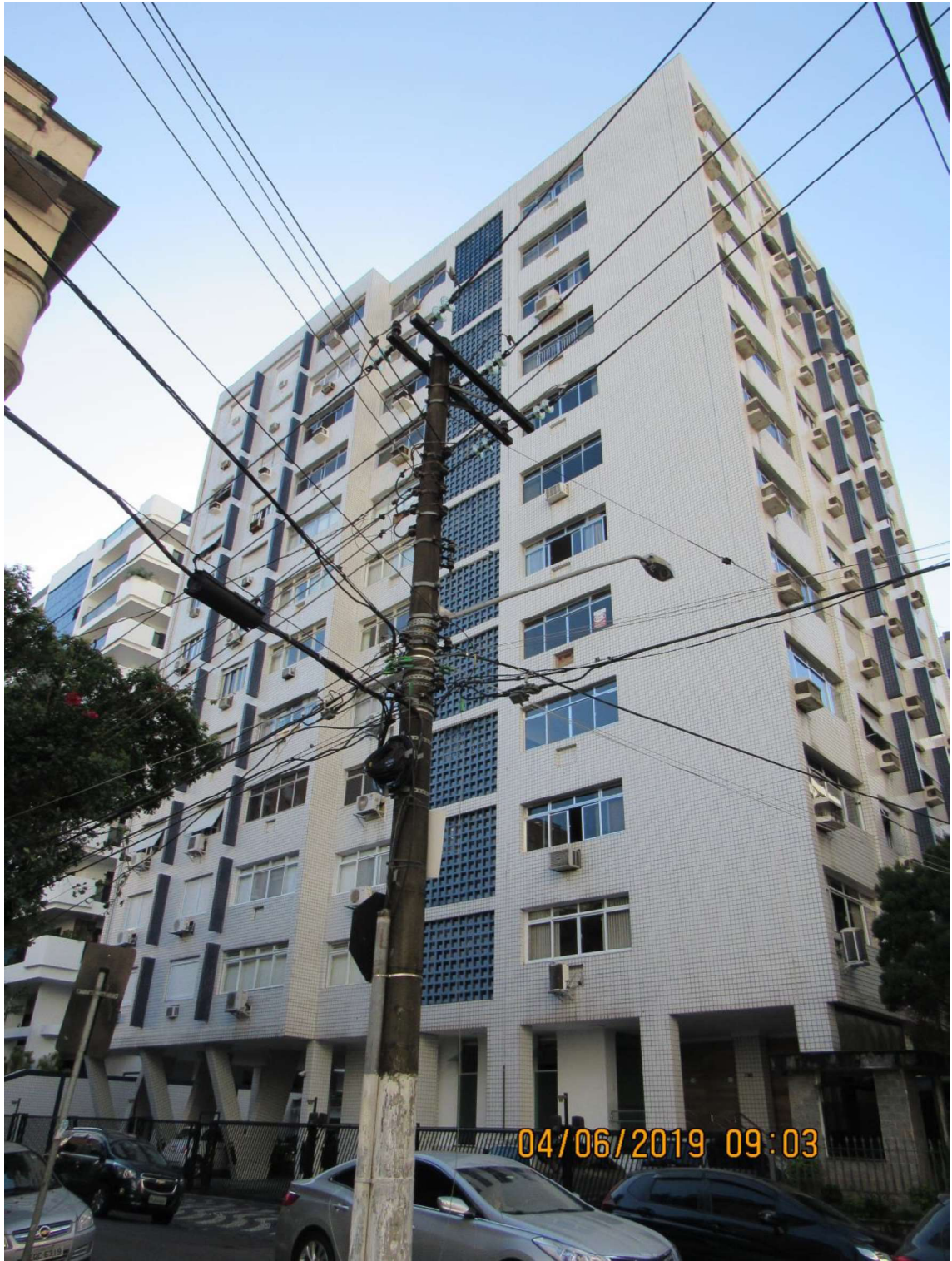
Imagem 2: Vista lateral ao imóvel periciado – Rua Djalma Dutra
