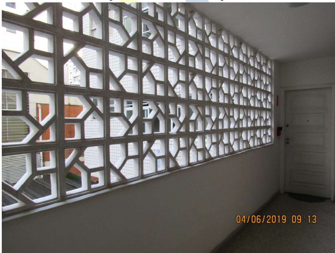
Imagem 17: corredor para acesso a entrada de serviço da unidade
