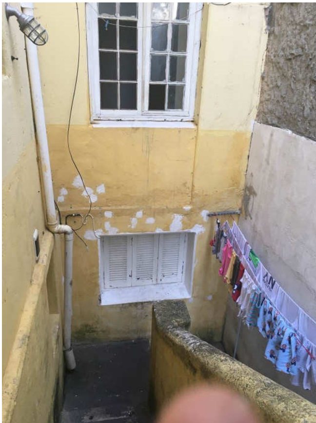
Acesso ao 2º subsolo.
