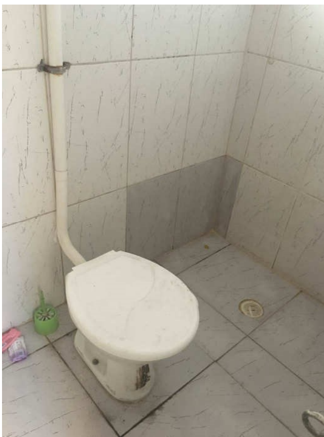
Banheiro 1º subsolo.
