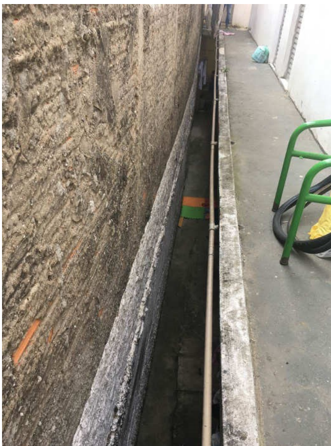
Corredor do 1º subsolo – fundos.
