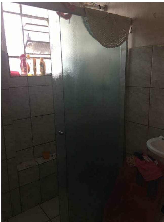
Banheiro 1º subsolo.
