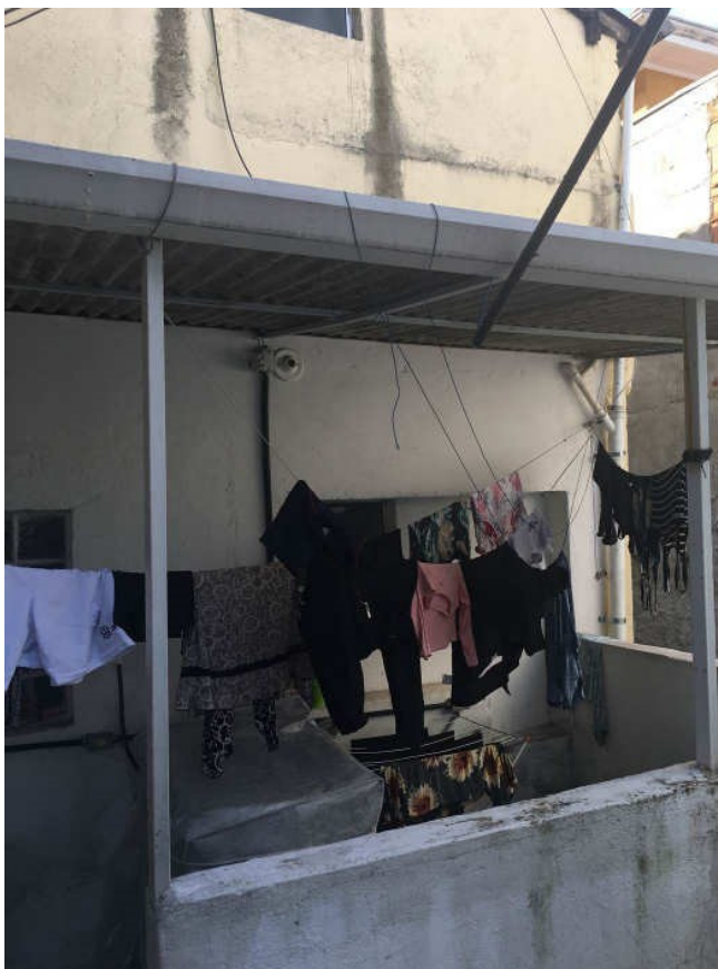
Lavanderia – 1º subsolo.
