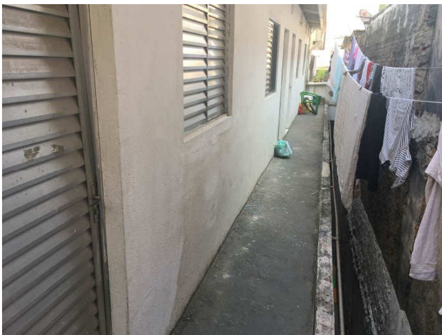
Corredor do 1º subsolo – fundos.
