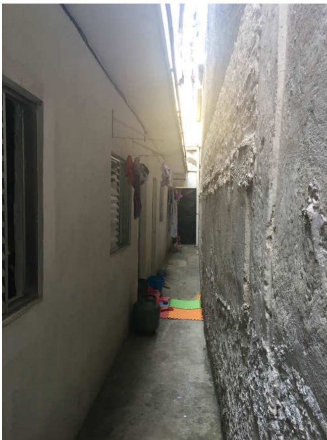
Corredor do 2º subsolo – fundos.
