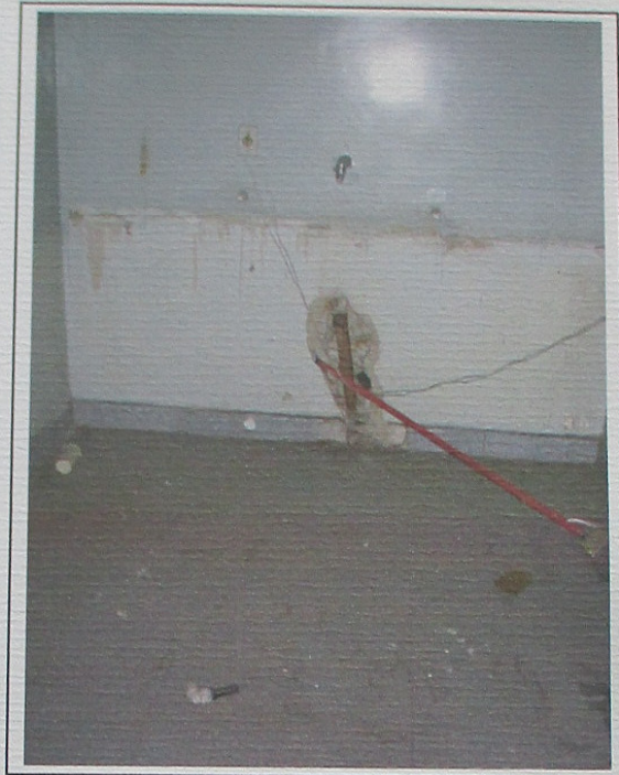
Foto 10: Rua Águas de Xapecó nº 330. Vista da cozinha.
