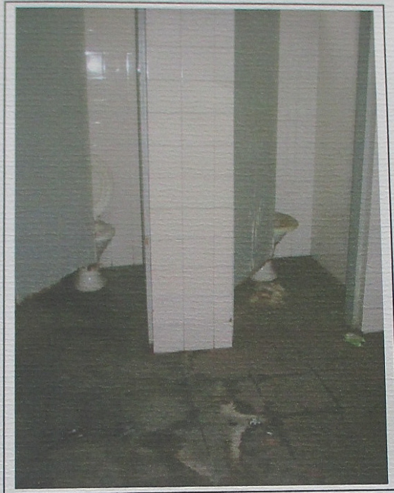
Foto 14: Rua Águas de Xapecó nº 330. Vista do banheiro masculino no piso inferior .
