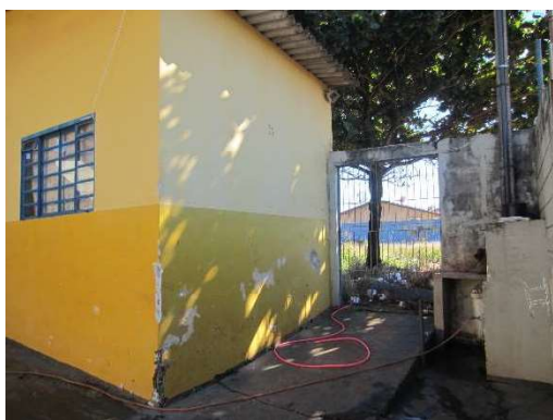
6. VISTA LATERAL INTERNA DO IMÓVEL.
