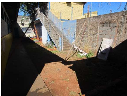
8. VISTA DOS FUNDOS DO IMÓVEL.
