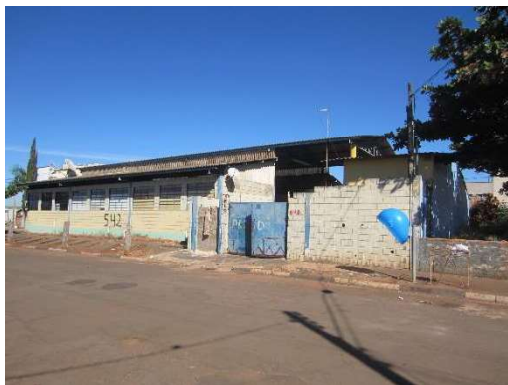
4. ENTRADA PARA A RUA JOSÉ GAZOTTO SOBRINHO.
