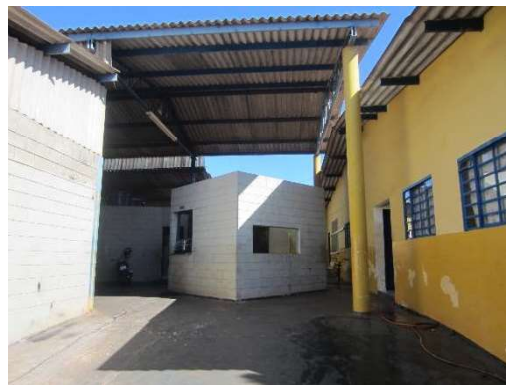
5. VISTA DA COZINHA E PATÍO.
