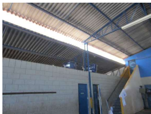
25. ESCADA DE ACESSO PARA O PAVIMENTO SUPERIOR
