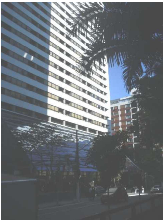
Foto 51 – Fachada do imóvel avaliando: Alameda Santos nº 85
