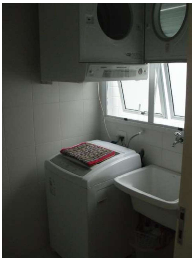
Foto 92 – Área de serviços
