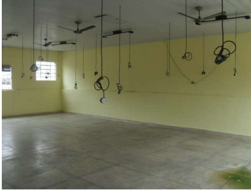
Foto 80 – Salão de trabalho no pavimento superior
