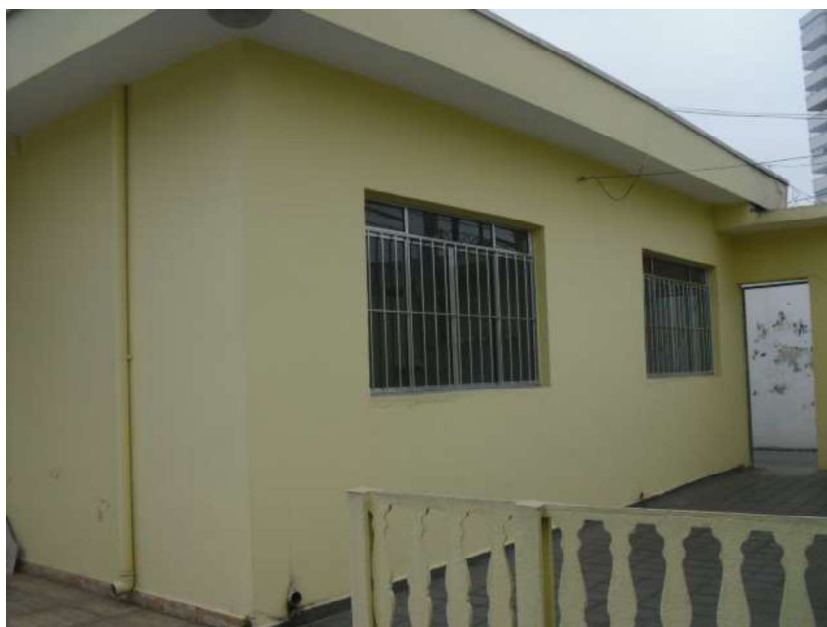
Foto 59 – Fachada principal da casa
