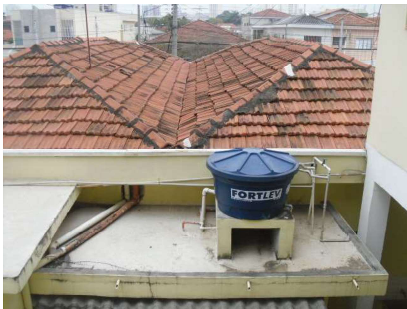
Foto 76 – Telhado da casa
