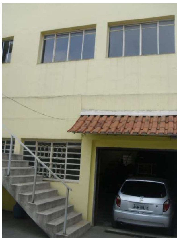
Foto 77 – Fachada do galpão
