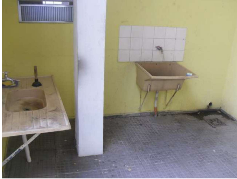
Foto 66 – Área de serviços
