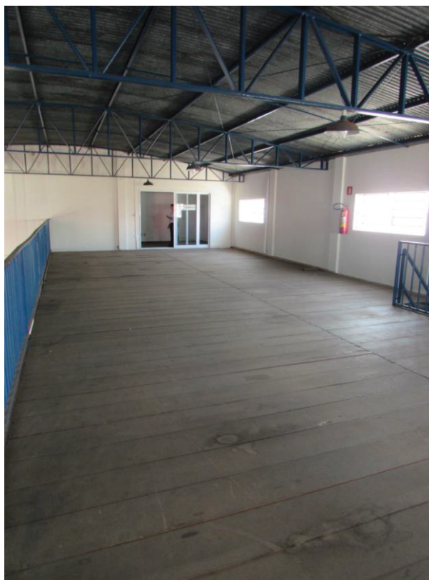
FOTO 4 – Foto tirada sobre o mezanino podendo-se observar o piso de madeira existente no mesmo.
