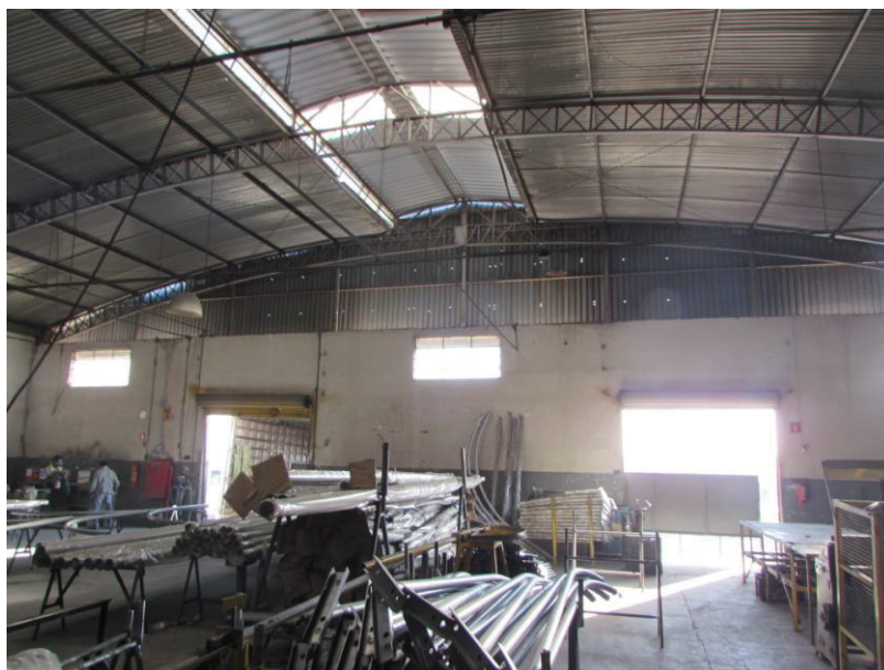
FOTO 4 – Novamente outra foto mostrando o interior do referido galpão industrial.
