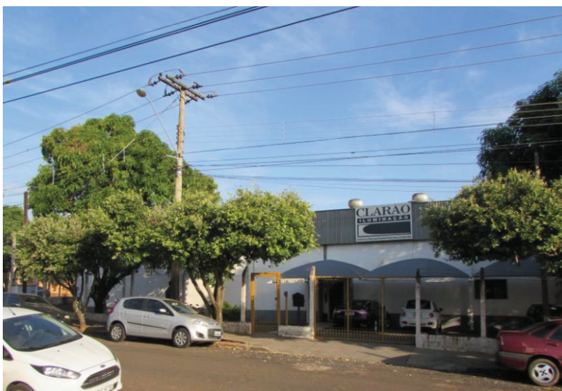
FOTO 1 – Anexo fotográfico destinado a mostrar a fachada do imóvel 2.
