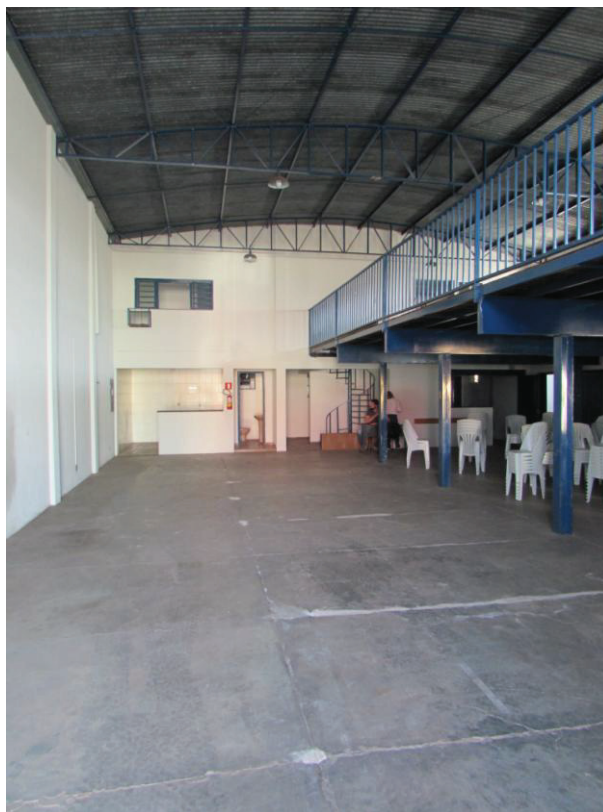
FOTO 2 – Foto tirada do interior do referido galpão, podendo-se observar o piso em concreto e a cobertura com estrutura metálica e telhas metálicas
