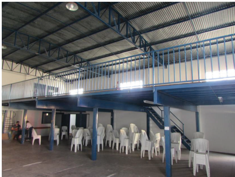
FOTO 3 – Outra foto do interior do galpão mostrando o mezanino em estrutura metálica existente no mesmo.
