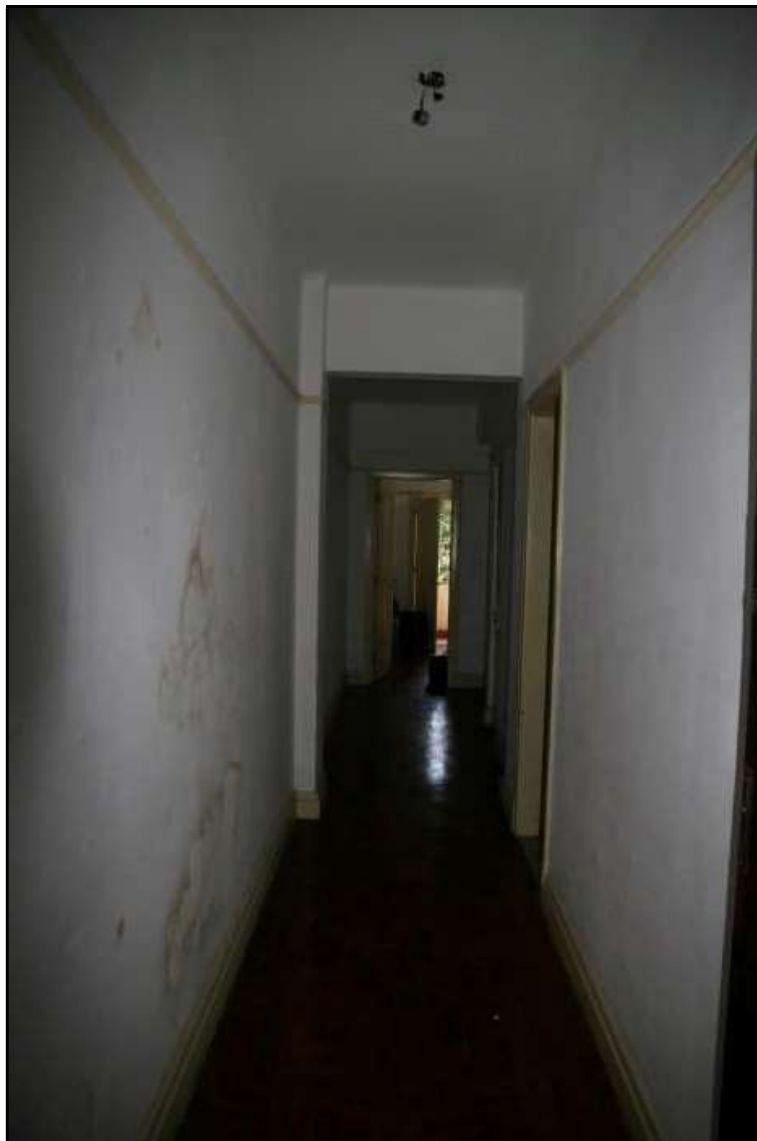
FOTO 19 - Apartamento localizado no primeiro andar (Apartamento 2). Esse apartamento confronta com a fachada posterior do edifício; e é composto de cozinha, banheiro e dormitório.
