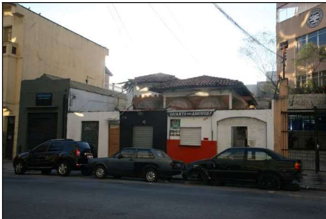
FOTO 45 - Vista do imóvel (Rua Helvétia nº 696).
