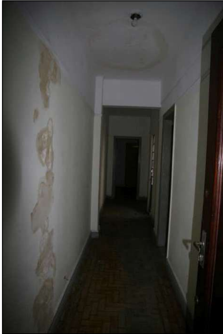
FOTO 28 - Apartamento localizado no segundo andar (Apartamento 4). Esse apartamento confronta com a fachada posterior do edifício; e é composto de cozinha, banheiro e dormitório.
