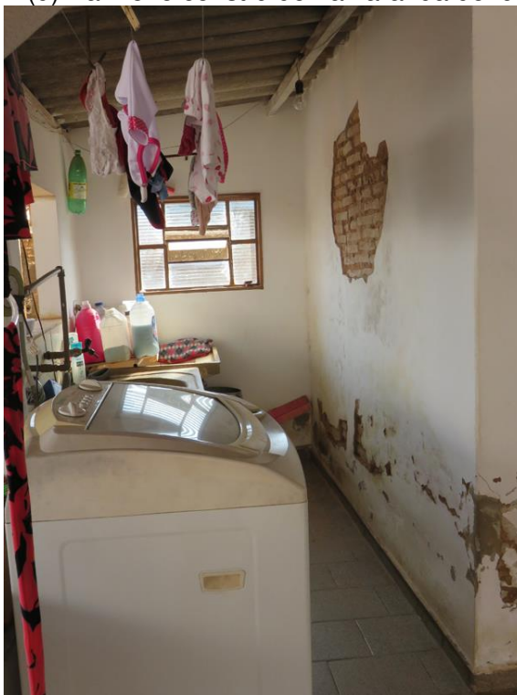
(f) Parade externa do banheiro da varanda
