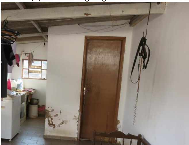
(d) Banheiro construído na varanda do fundo
