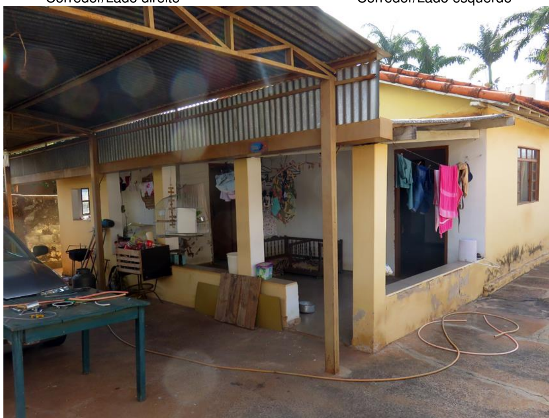
Parte dos fundos
