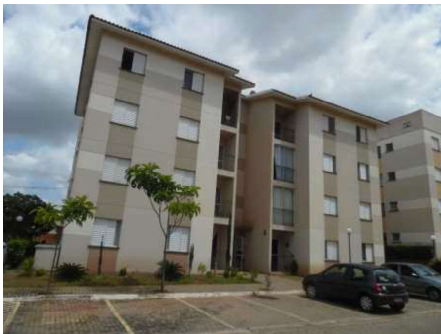
Fachada do Bloco 8.
