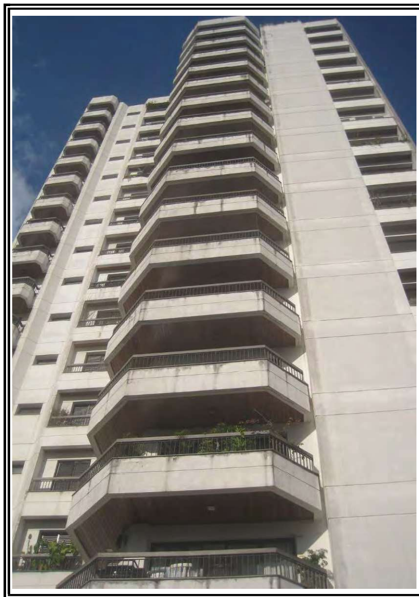
Foto nº 01: Vista geral do Condomínio Edifício Tupanuyara
