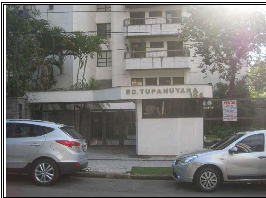
Foto nº 04: Vista da entrada do Condomínio Edifício Tupanuyara
