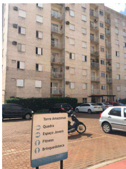
Foto 5 – Vista interna do Cj. Res. “ Vitória Parque Campos Eliseos I “
