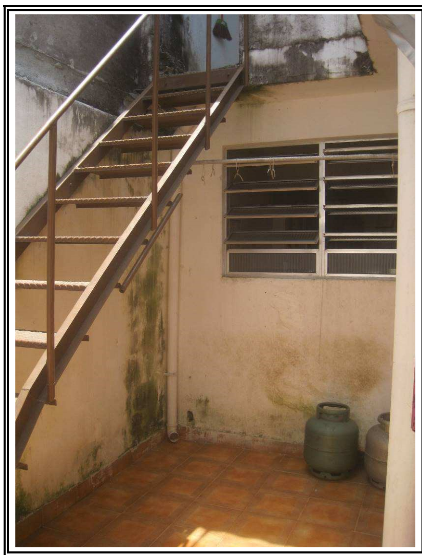
Foto nº 18: Vista do quintal (externa – fundos), com detalhe da escada de acesso ao pavimento superior
