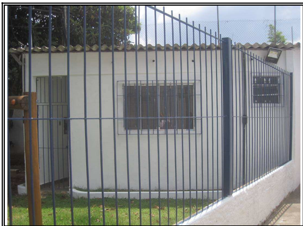
Foto nº 25: Vista da administração do Condomínio Residencial Village Del Rei
