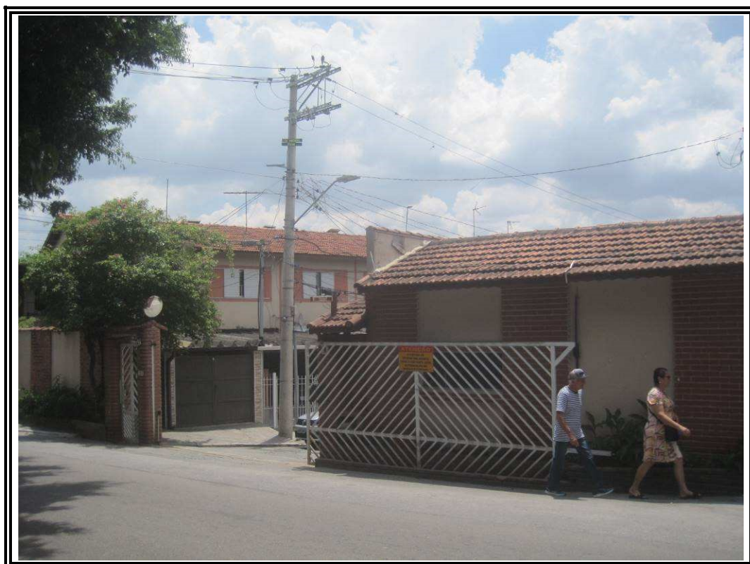
Foto nº 02: Outra vista da fachada do Condomínio Residencial Village Del Rei
