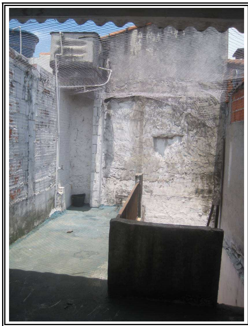
Foto nº 22: Vista do terraço
