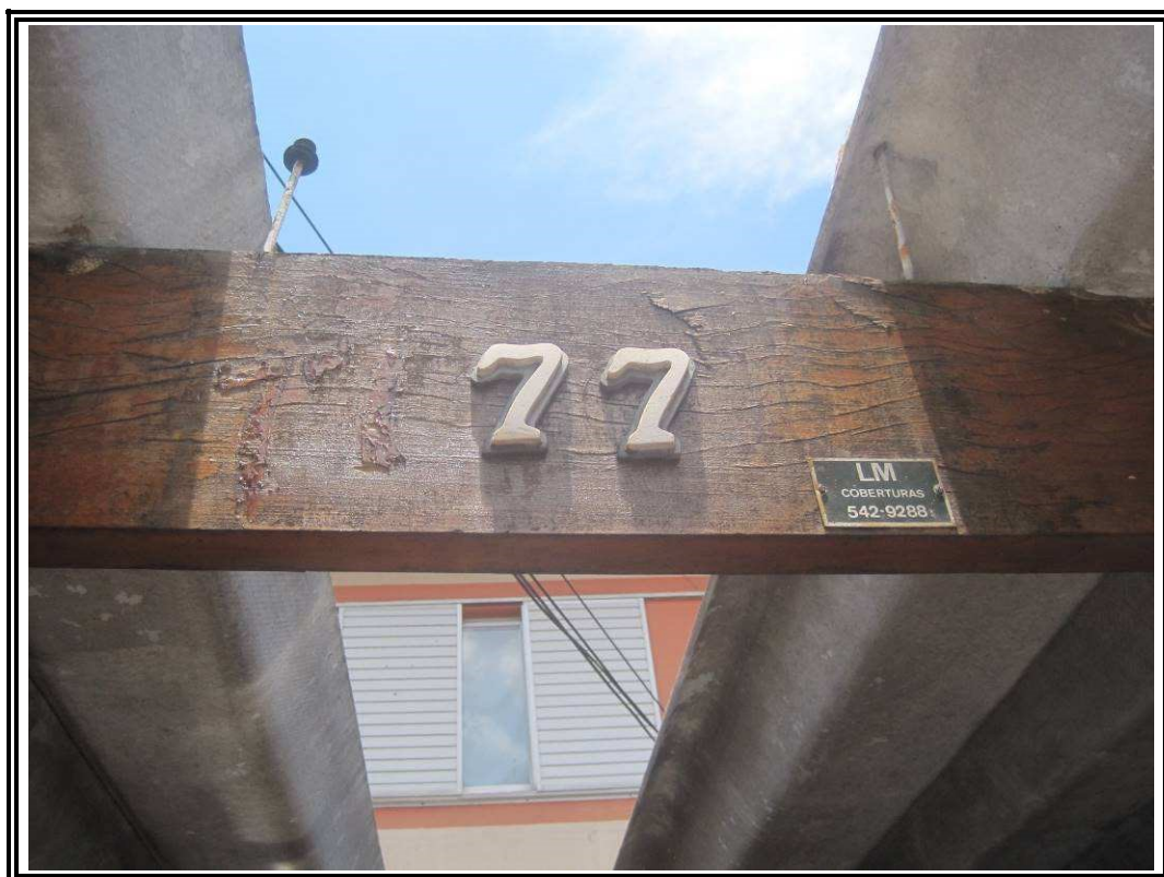
Foto nº 07: Detalhe da identificação predial do imóvel
