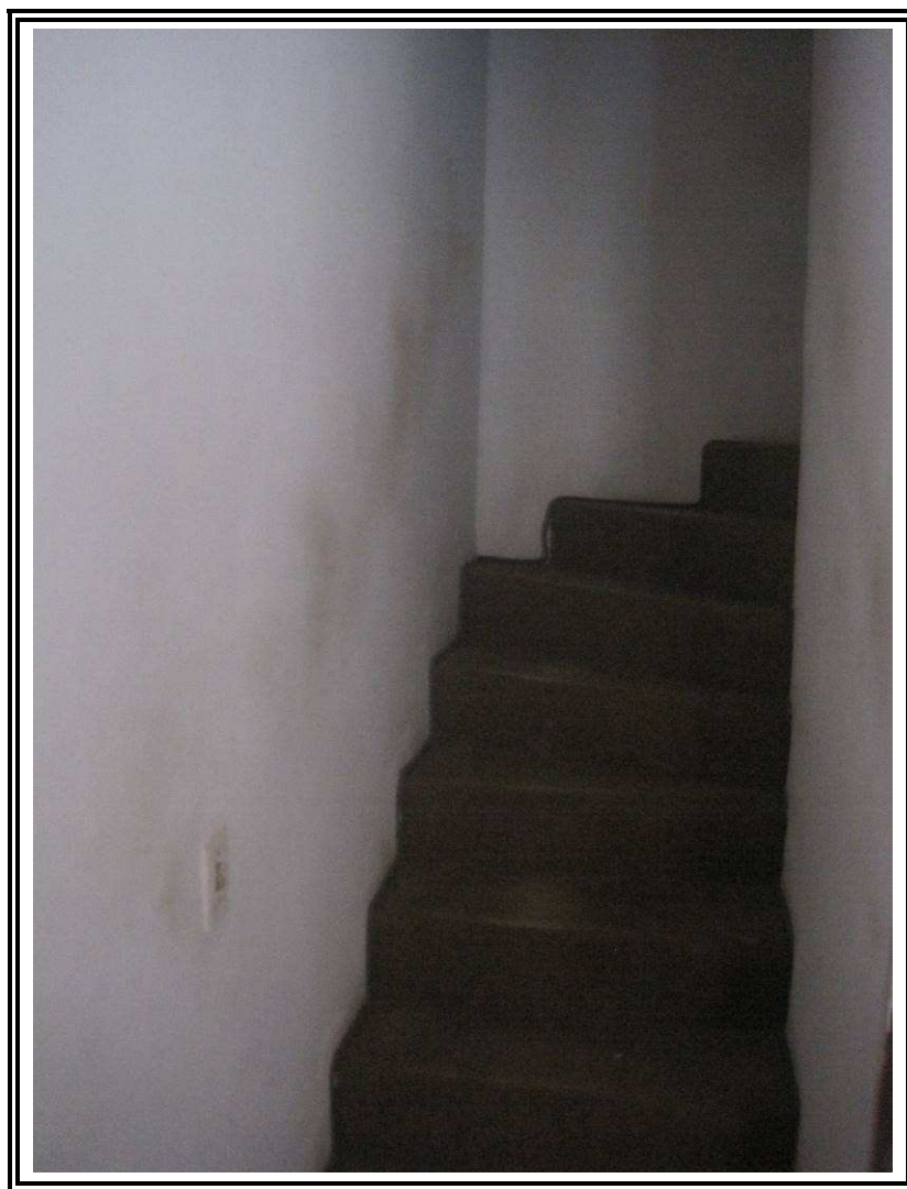
Foto nº 17: Vista da escada (interna) de acesso ao pavimento superior
