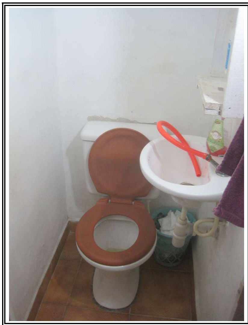
Foto nº 13: Vista do lavabo
