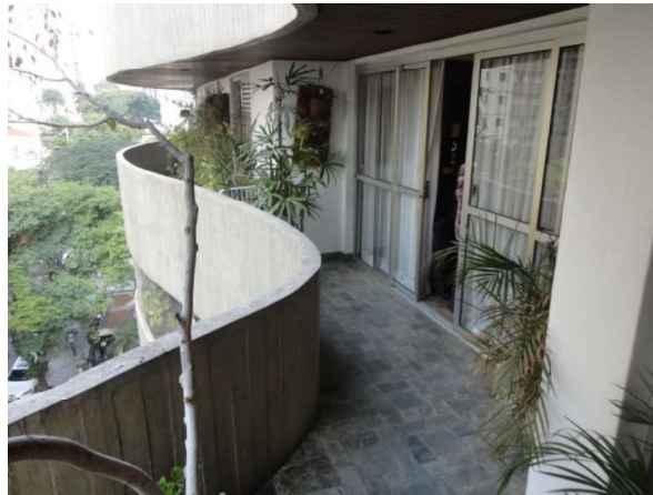
FOTO Nº 05 Vista parcial sacada
