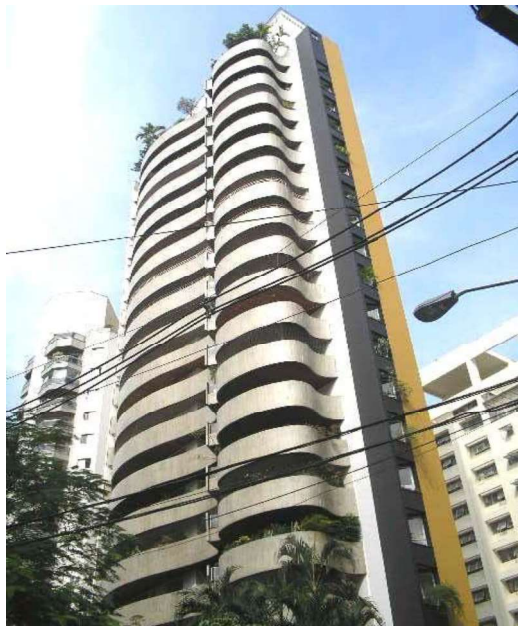
FOTO Nº 01 Vista parcial da fachada do Edifício Arte I
