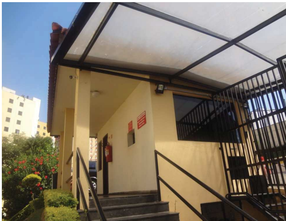
Foto 3 – Vista da Portaria
