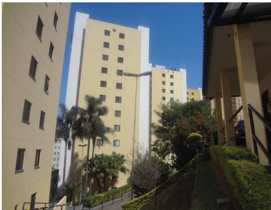
Foto 2 – Vista dos blocos do Condomínio e da Portaria
