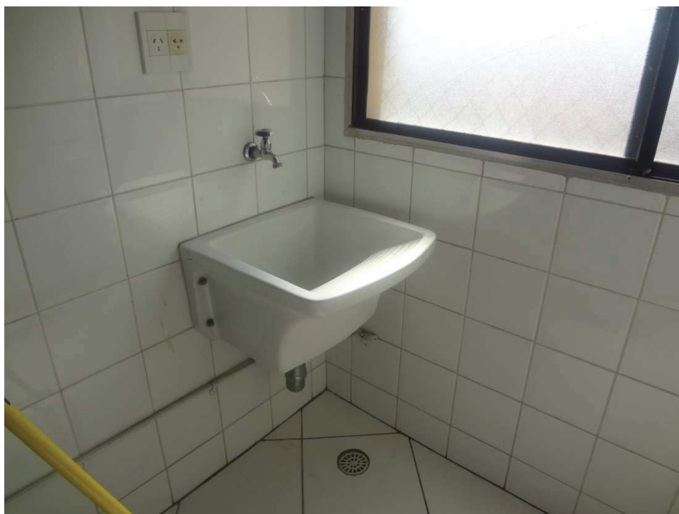
Foto 16 – Área de serviço
