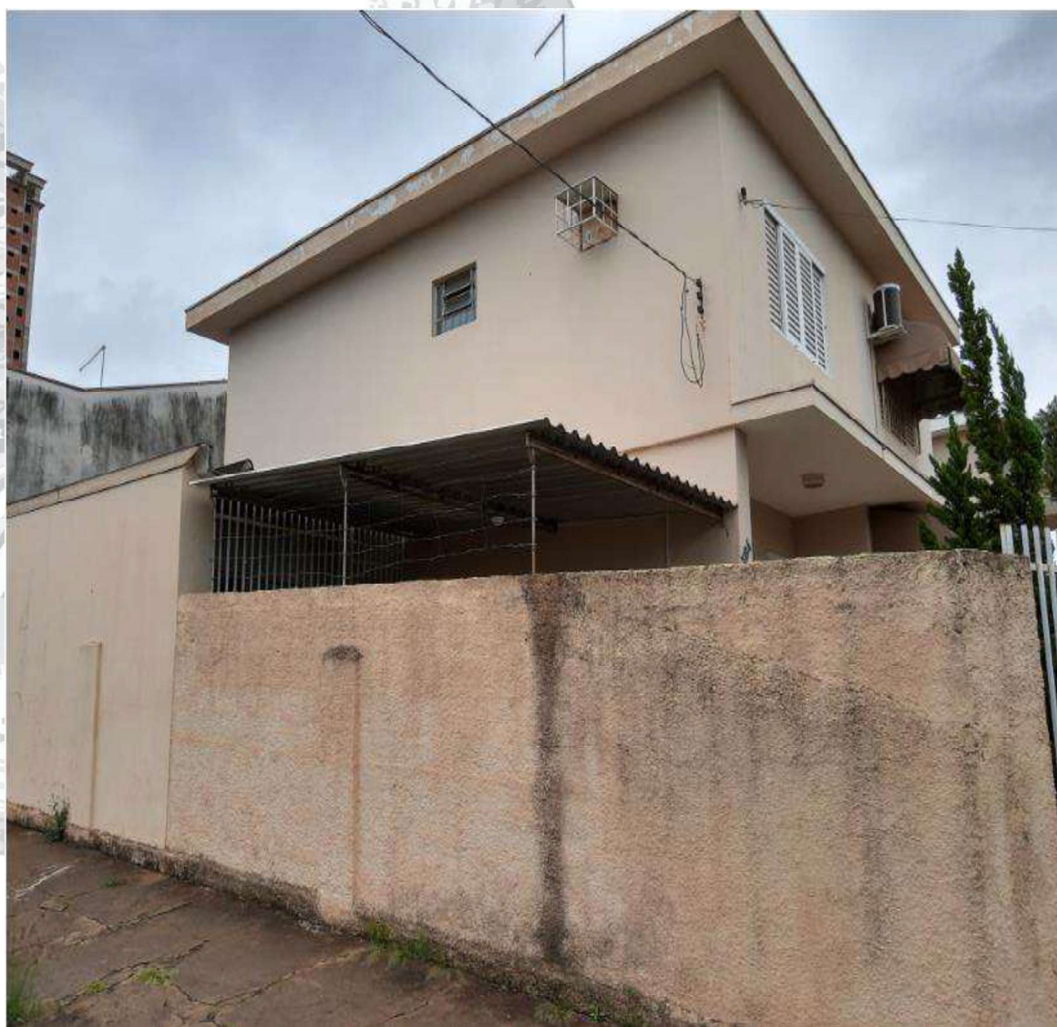
FOTO LATERAL DA CASA
