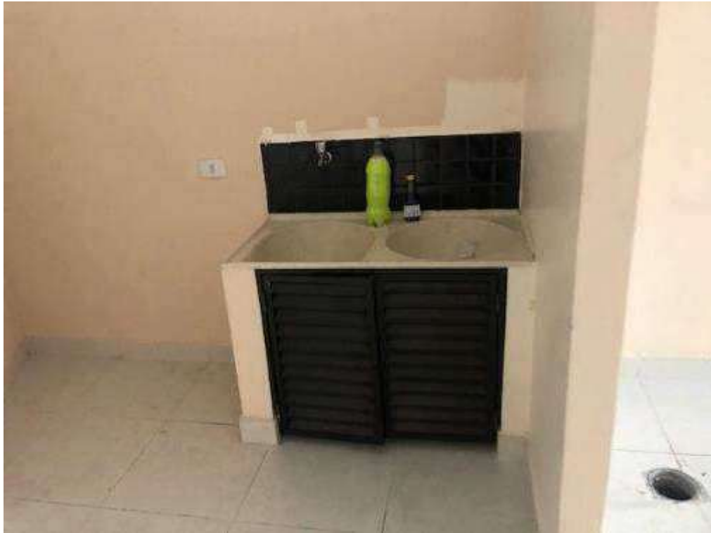
Foto 18: Vista do tanque no salão - Segundo pavimento.
