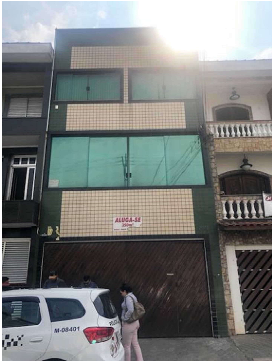
Foto 1: Vista da fachada.
