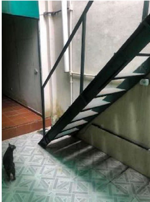
Foto 14: Escada externa de acesso ao segundo pavimento.
