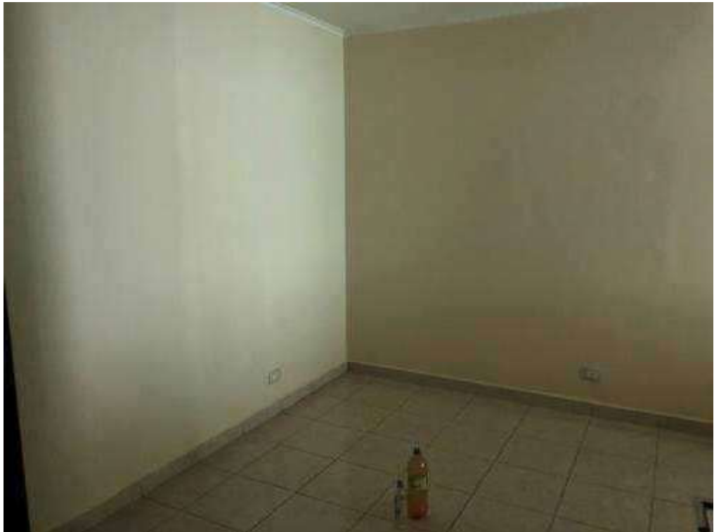
Foto 25: Vista da sala - Segundo pavimento.
