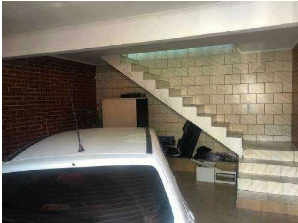
Foto 4: Vista do pavimento térreo: garagem e escada de acesso ao primeiro pavimento.
