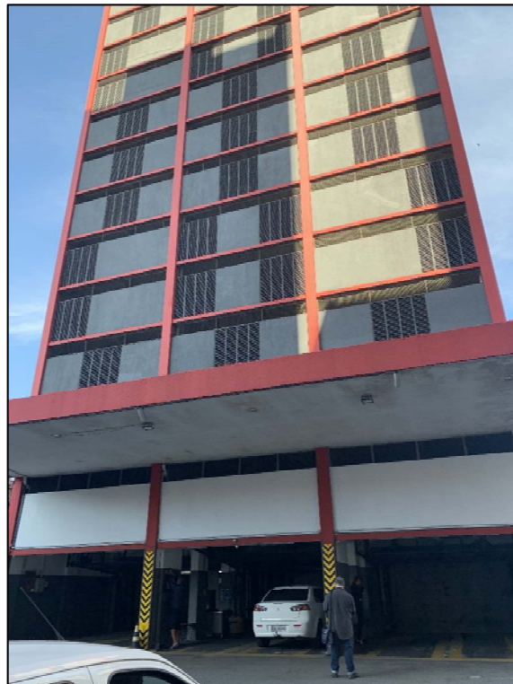
Fotos 01 e 02. Fachada do prédio do imóvel avaliando.
