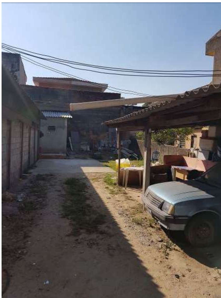
FOTO 38: VISTA EM SENTIDO CONTRÁRIO DAS EDIFICAÇÕES IRREGULARES EXISTENTES SOBRE O LOTE 26.
