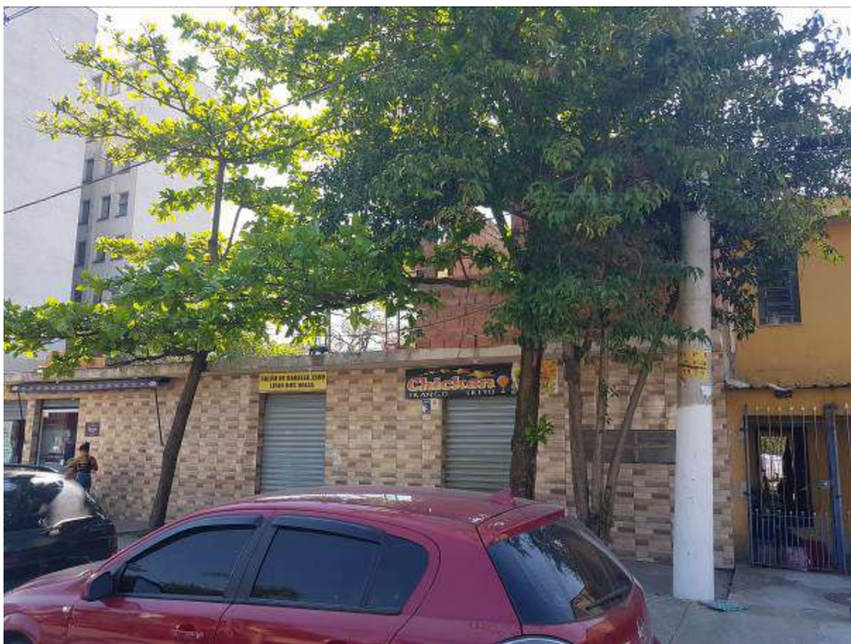
FOTO 34: VISTA DA FRENTE DO LOTE 26.
