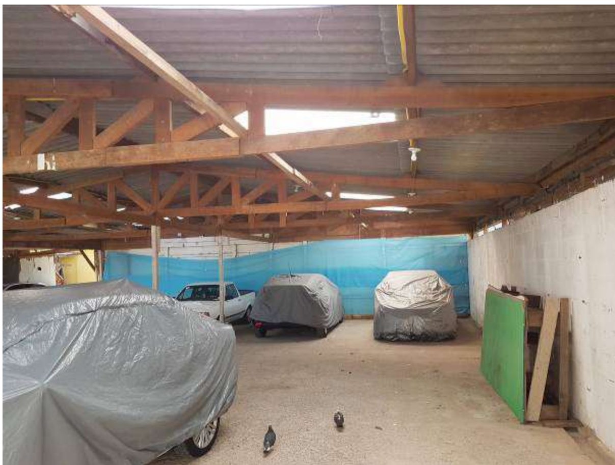
FOTO 45: VISTA EM SENTIDO CONTRÁRIO DAS EDIFICAÇÕES IRREGULARES EXISTENTES SOBRE O LOTE 27.
