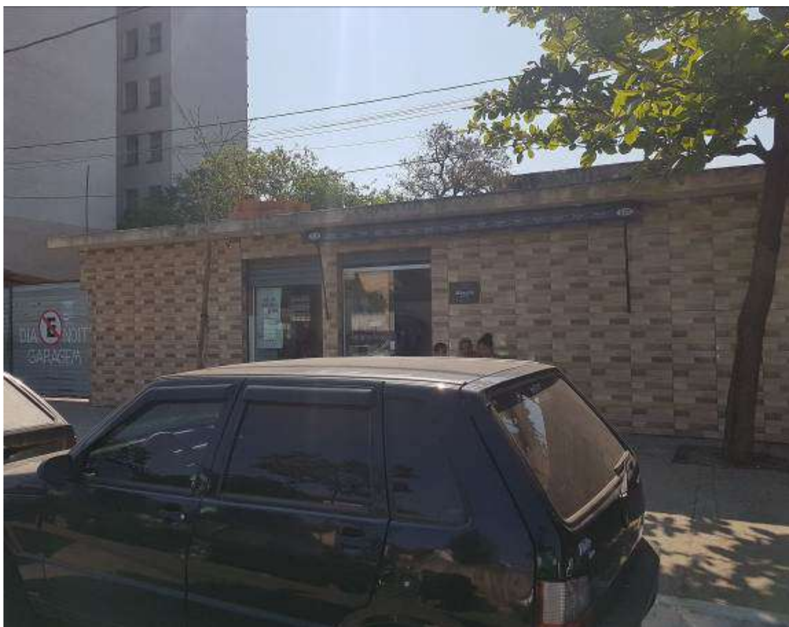
FOTO 41: VISTA DA FRENTE DO LOTE 27.
