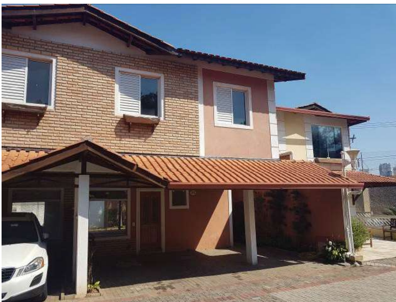
FOTO 13: OUTRA VISTA DA CASA 22 AVALIANDA EM QUESTÃO.
