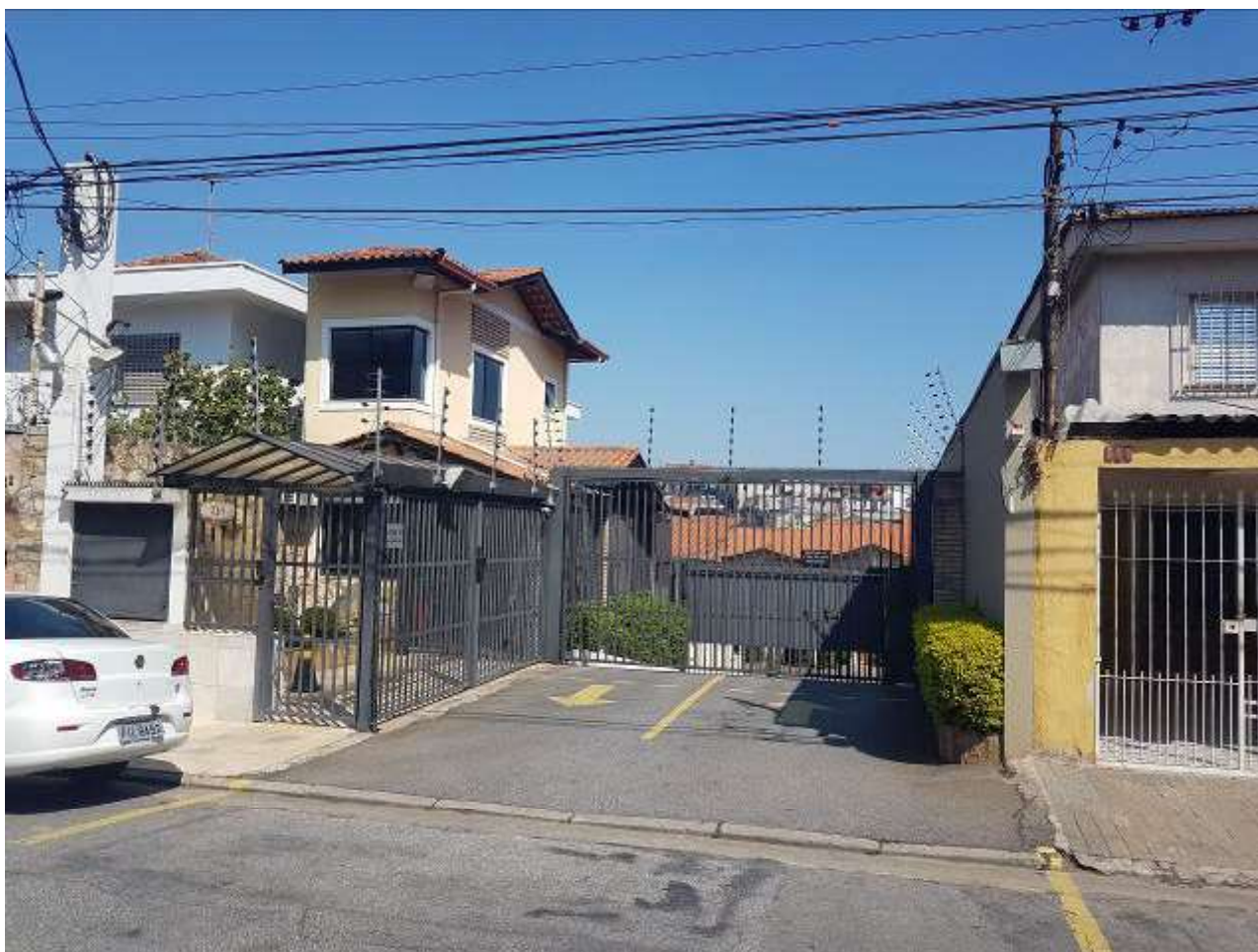
FOTO 5: ENTRADA DO CONDOMÍNIO VILLA DE SÃO PAULO ONDE ESTÁ INSERIDA A CASA 22 AVALIANDA EM QUESTÃO.
