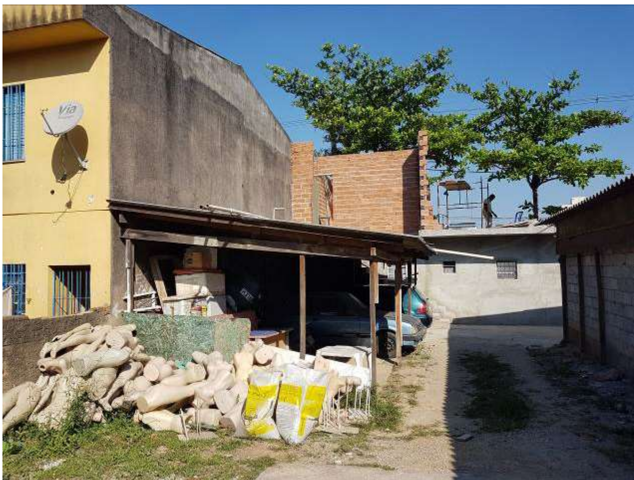
FOTO 37: OUTRA VISTA DAS EDIFICAÇÕES IRREGULARES INSERIDAS SOBRE O LOTE 26.
