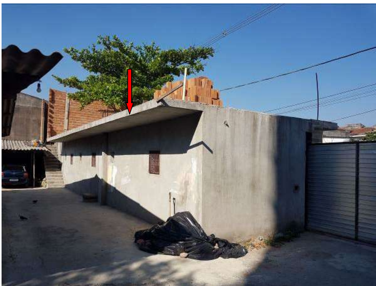
FOTO 43: VISTA DAS EDIFICAÇÕES IRREGULARES INSERIDAS SOBRE O LOTE 27.
