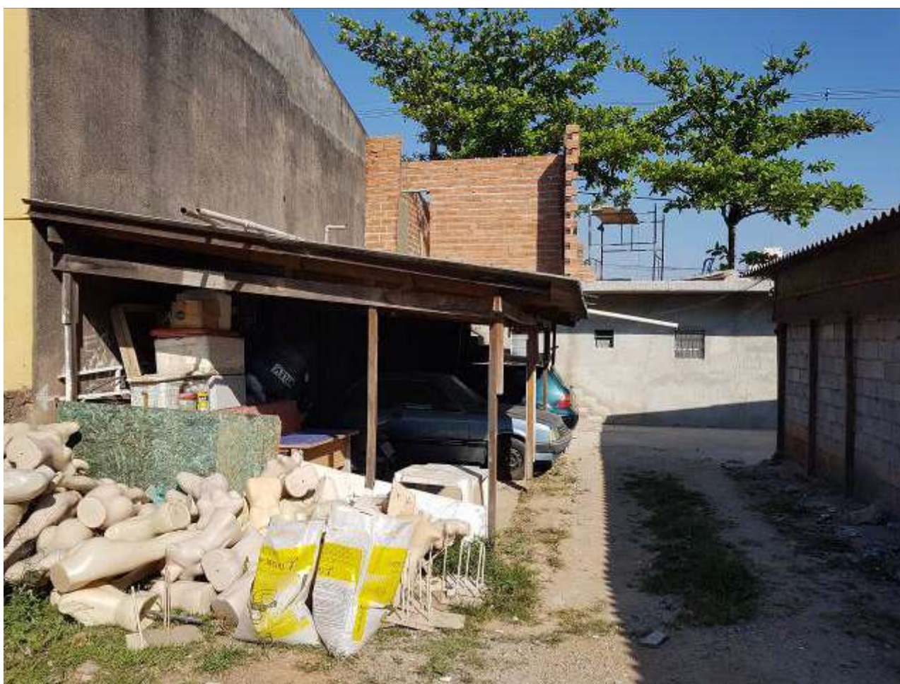
FOTO 36: VISTA DAS EDIFICAÇÕES IRREGULARES INSERIDAS SOBRE O LOTE 26.
