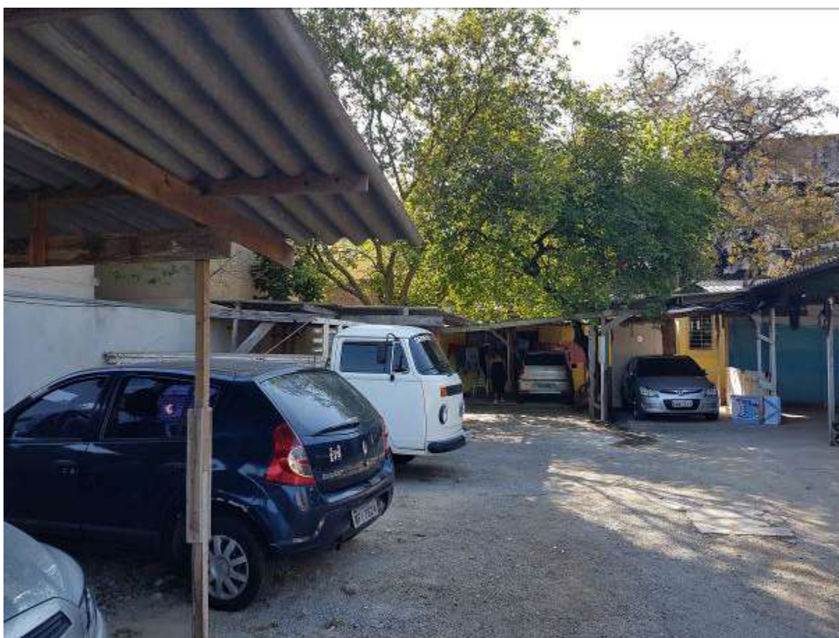
FOTO 50: VISTA DAS EDIFICAÇÕES IRREGULARES INSERIDAS SOBRE O LOTE 28.
