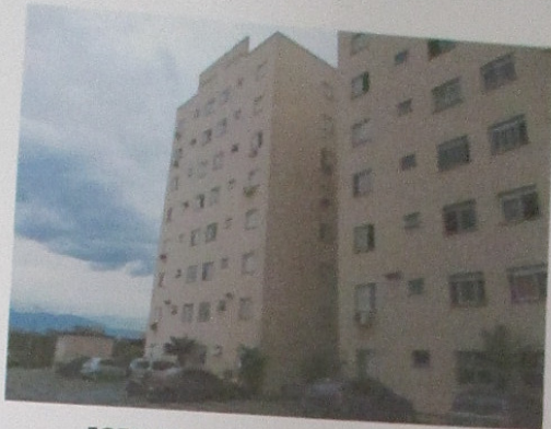
FOTO 04 - Vista Geral do Edifício.
