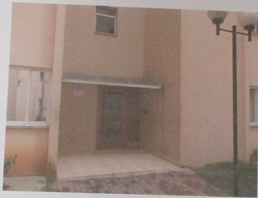
FOTO 05 :- Identificação. Entrada do Bloco D.
