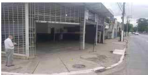
Imóvel nro 1.048 - vista externa da oficina
