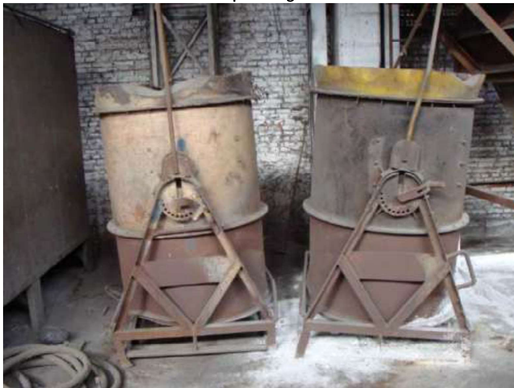
Silo de cal
