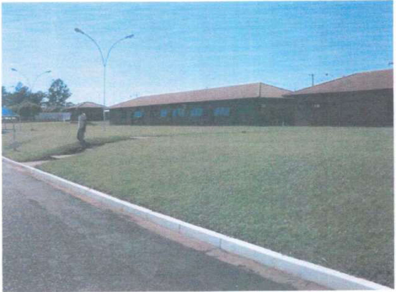
Foto 20 – Vista Parcial de Guias, Sarjetas e Pavimento Asfáltica Interno, .pertencente a Área 01 e Área 02.
