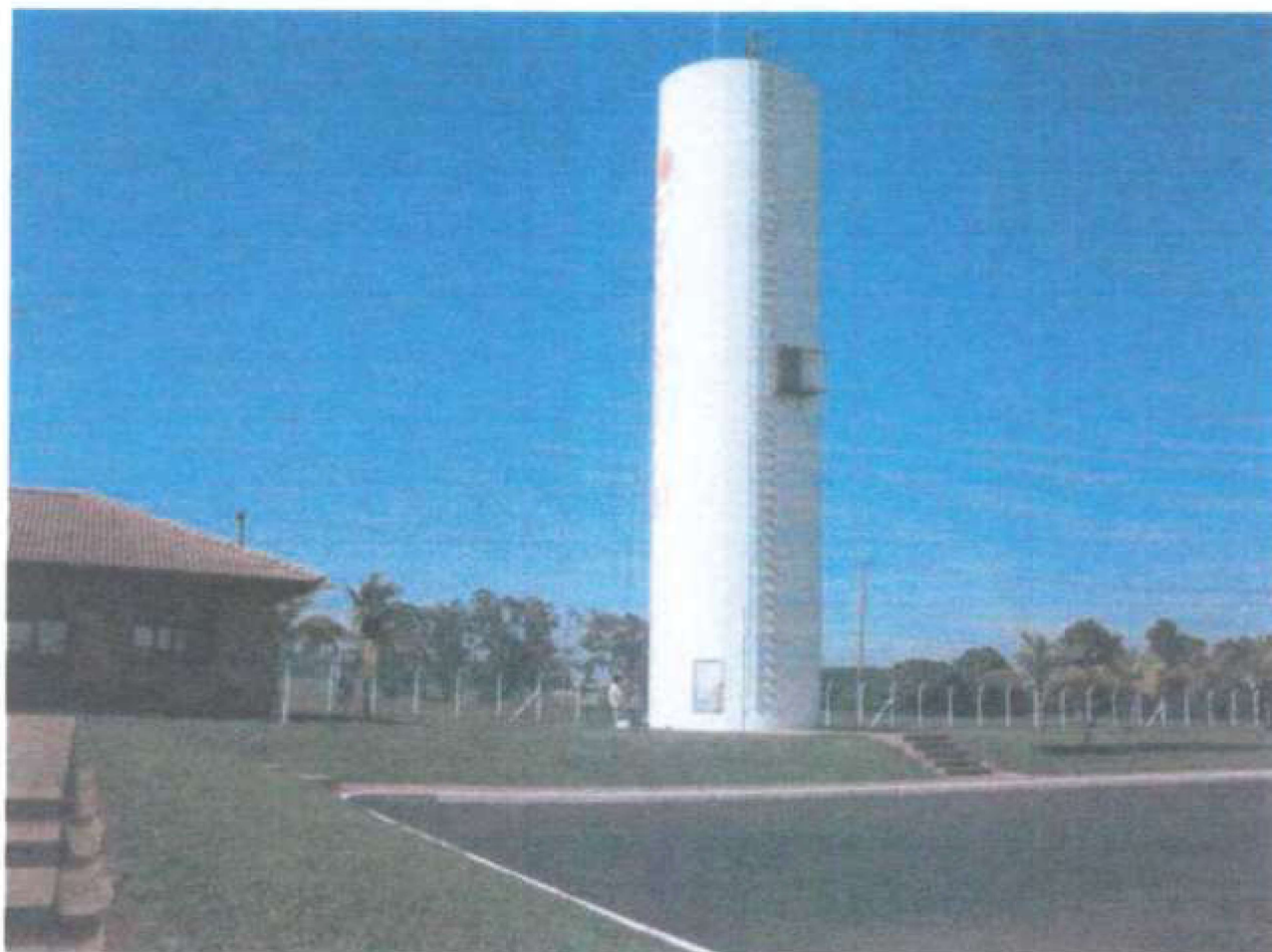
Foto 10 – Vista Parcial da Caixa d'agua com capacidade de 80m 3 .
