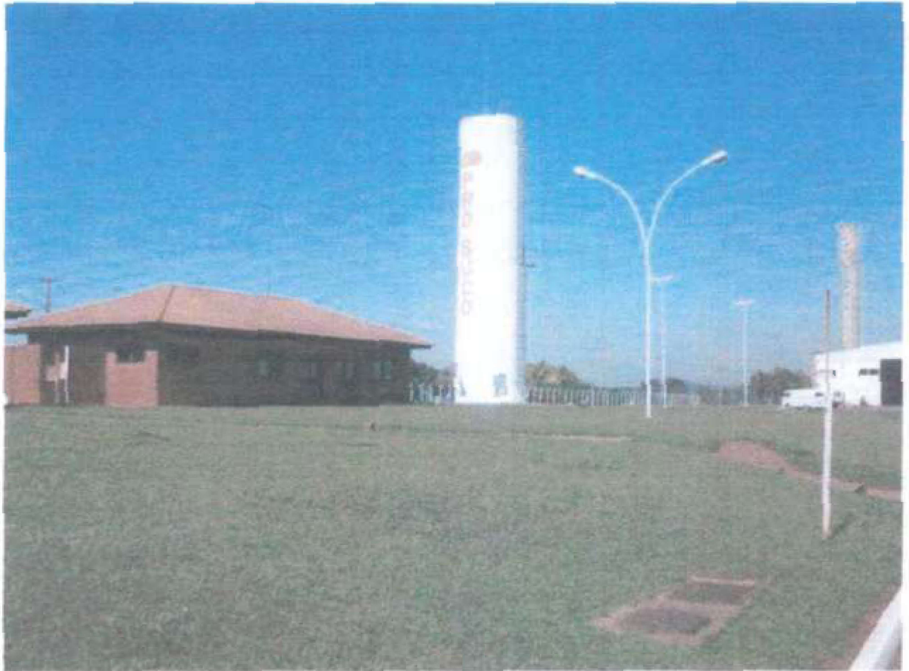
Foto 11 – Vista Parcial Refeitório, Caixa d'agua 80m 3 , Paisagismo e Iluminação de Pátio.
