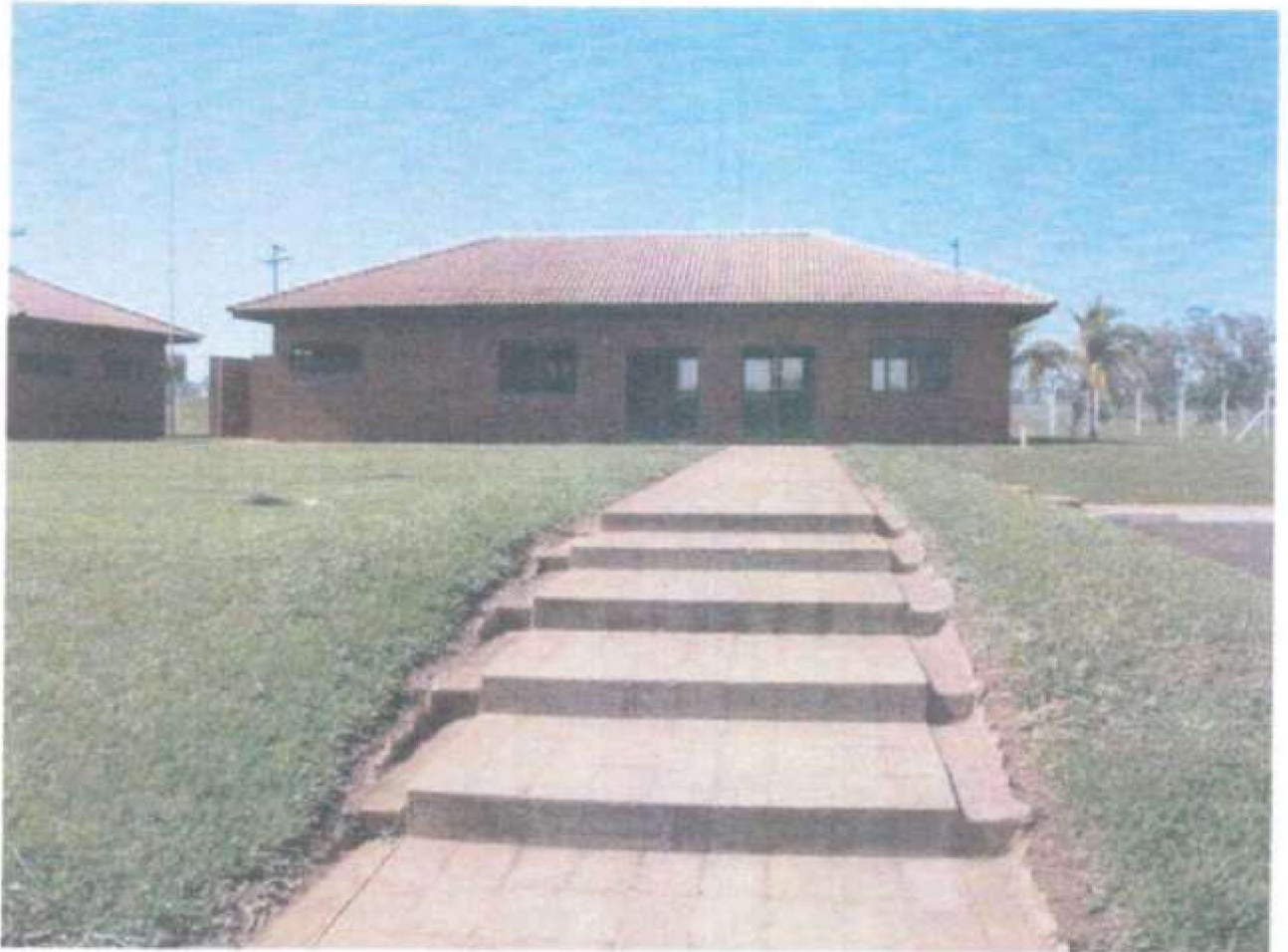
Foto 08 – Vista Parcial Frontal do Refeitório.
