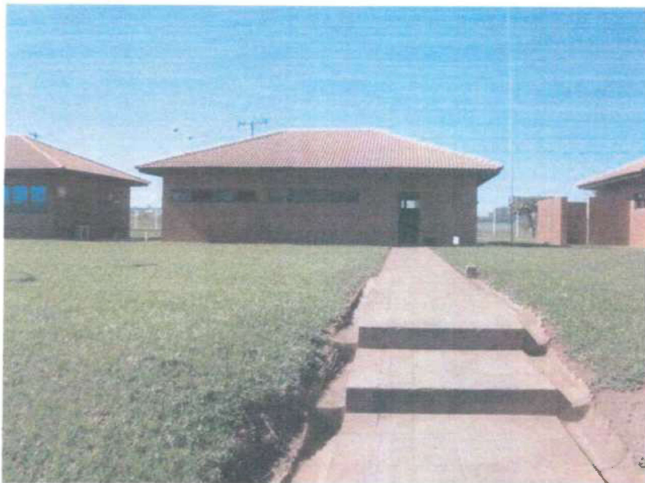
Foto 06 – Vista Parcial Frontal dos Vestiários.
