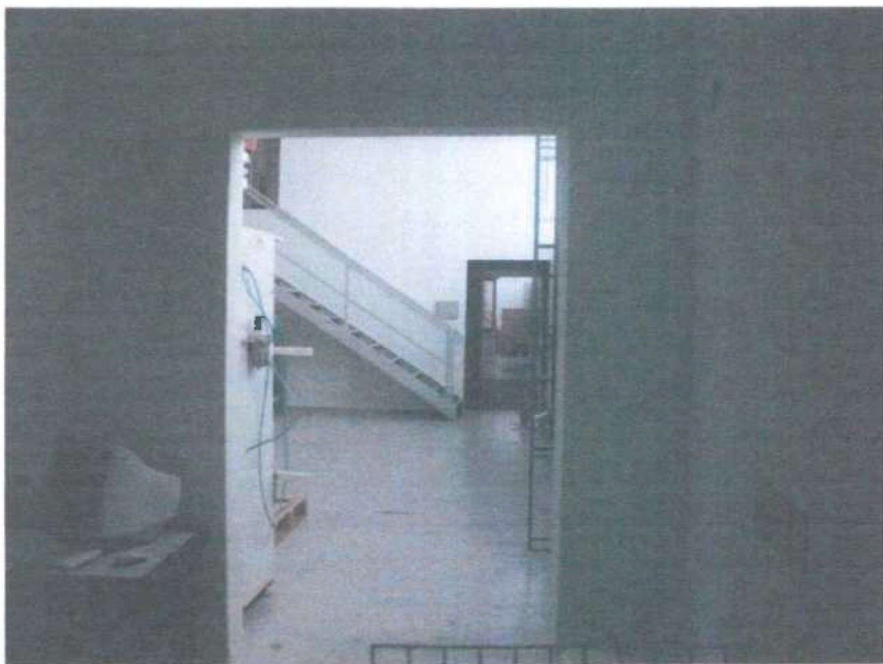
Foto 18 – Vista Parcial Interna do Setor de Produção, pertencente a Área 01.
