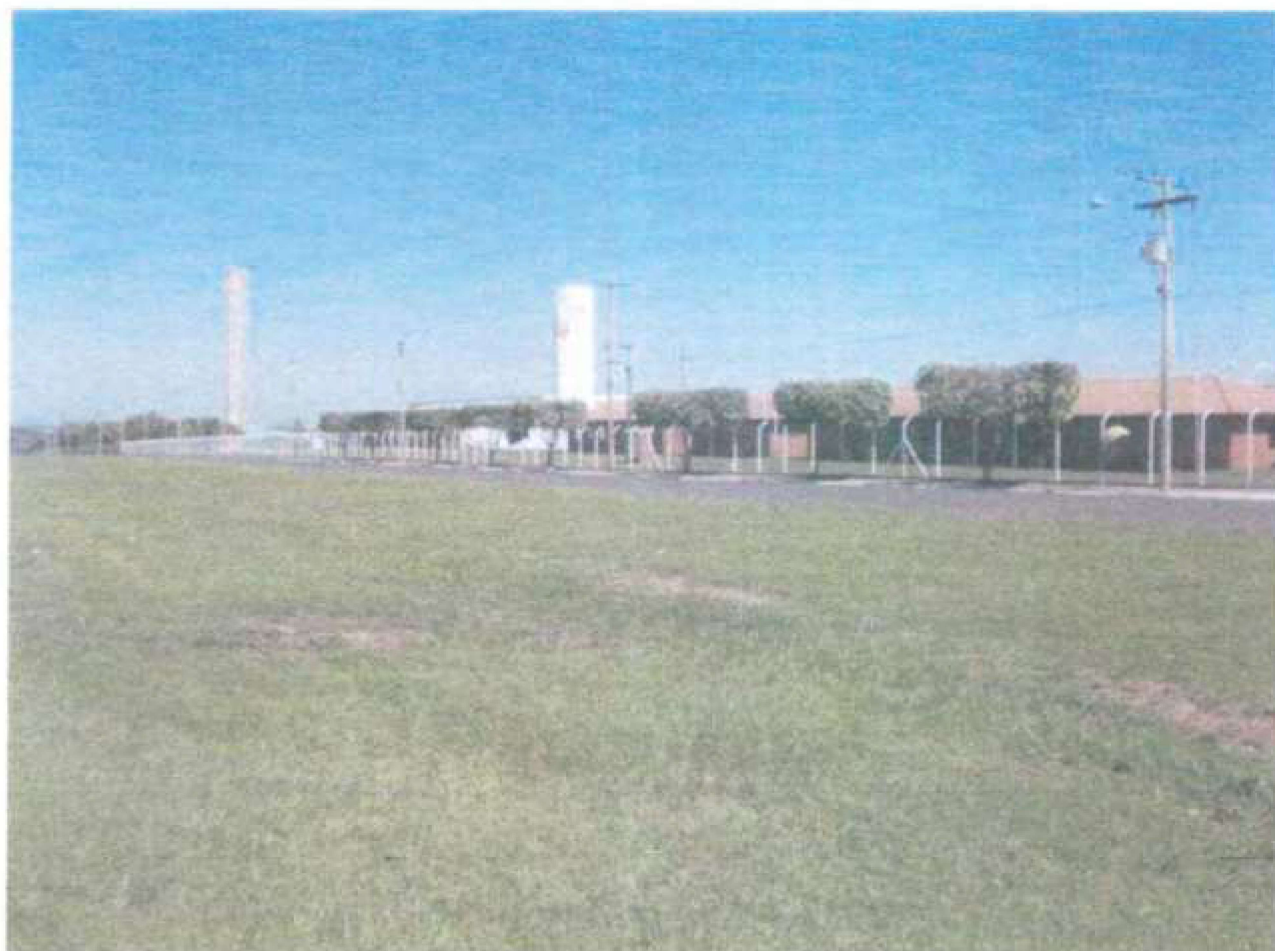
Foto 03 – Vista Parcial do Perimetro externo do imóvel, Alambrado e Paisagismo, pela avenida Marginal, incluído Área 01, e Área 02.
