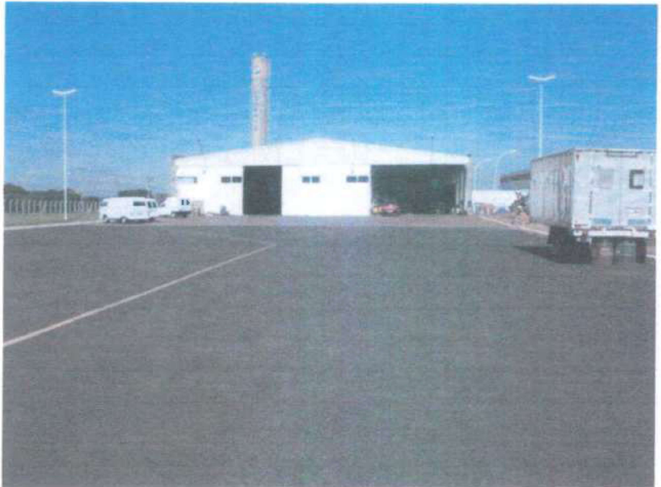
Foto 13 – Vista Parcial Frontal do Deposito de Produto Acabado e Oficina, Pavimentação Asfáltica e Iluminação de Pátio, pertencente a Área 02.
