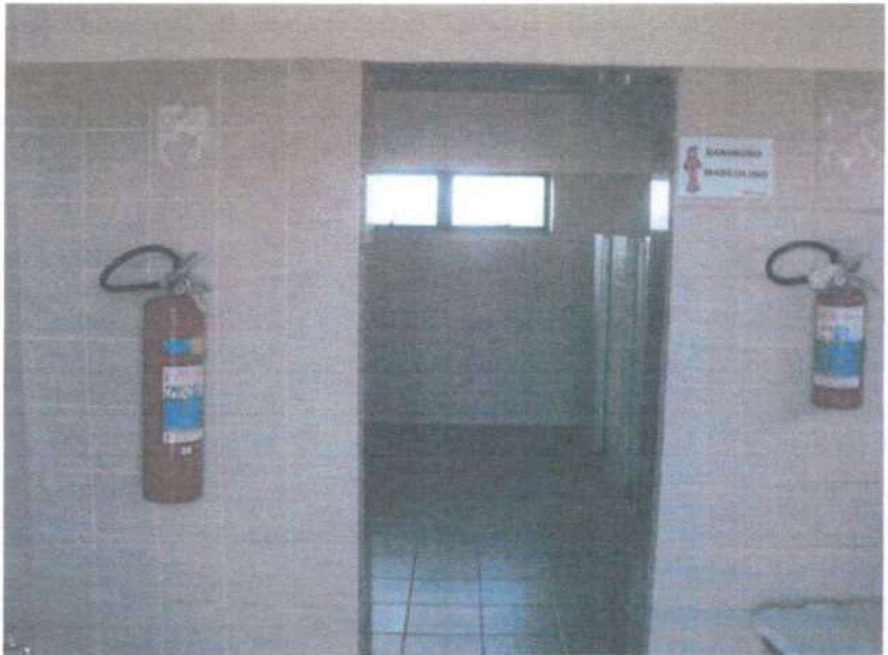
Foto 07 – Vista Parcial Interna dos Vestiários.
