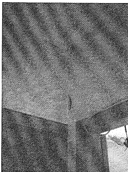
Vistas de trinca na parede do corredor de acesso aos cômodos.
