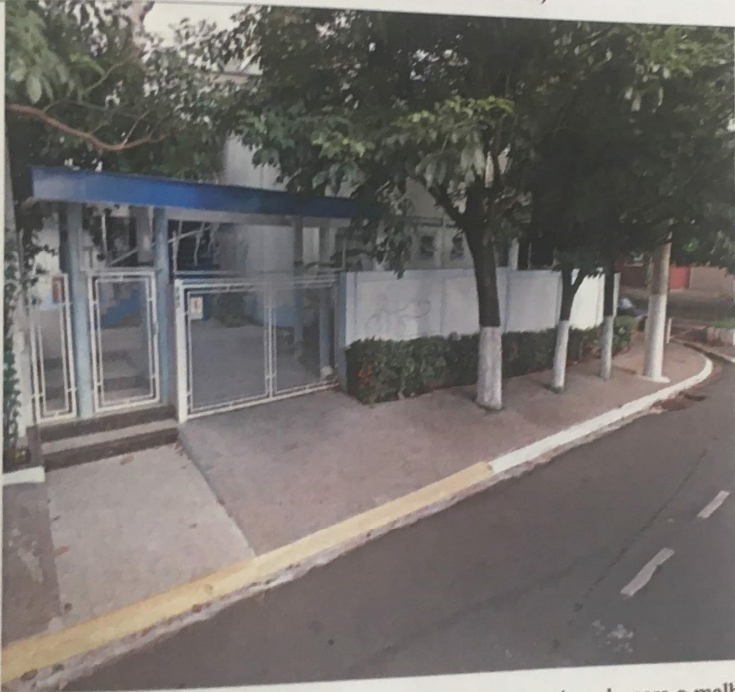
(Foto 20 – Fachada do Bloco 3 – nomenclatura convencionada para o melhor entendimento do Laudo Pericial)
