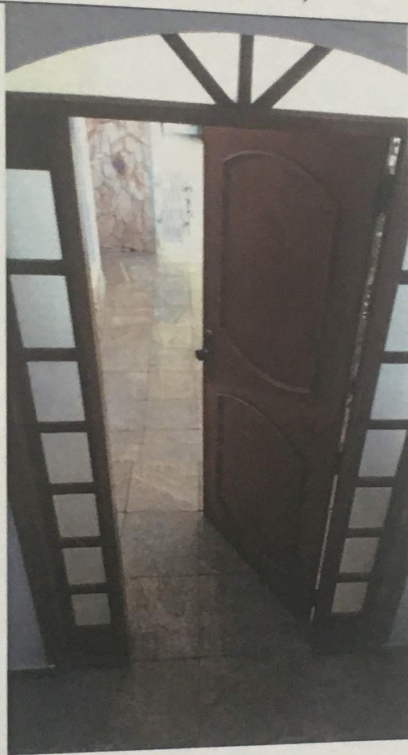
(Foto 13 – Porta de acesso no térreo ao lado esquerdo do 2º piso)
