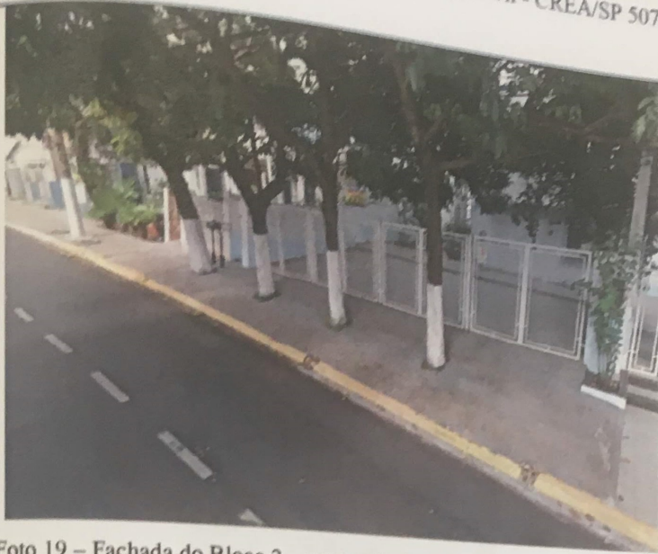
(Foto 19 – Fachada do Bloco 2 – nomenclatura convencionada para o melhor entendimento do Laudo Pericial)
