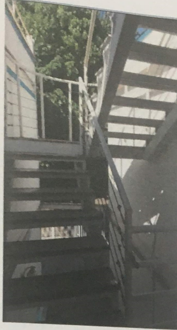
(Foto 32 – Escada de acesso à cobertura)
