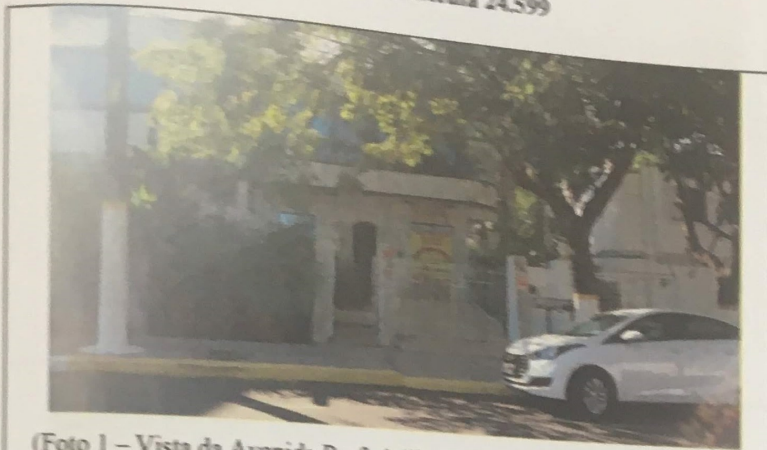
(Foto 1 - Vista da Avenida Prof. Atilio Martini, 404 em frente ao imóvel denominado Bloco 1 para a melhor compreensão deste laudo)
