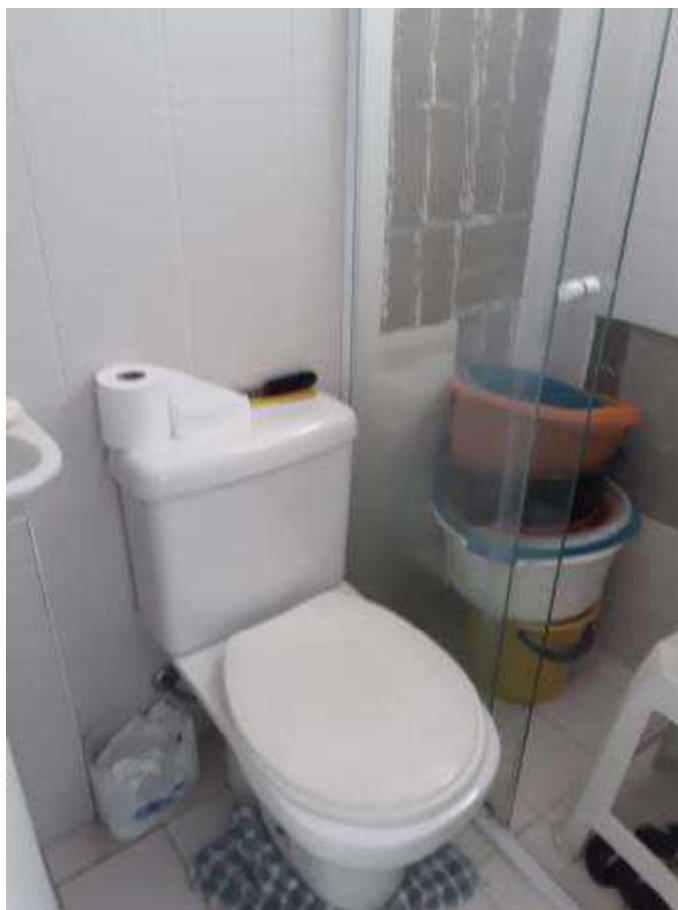
Vista parcial do banheiro de empregada.
