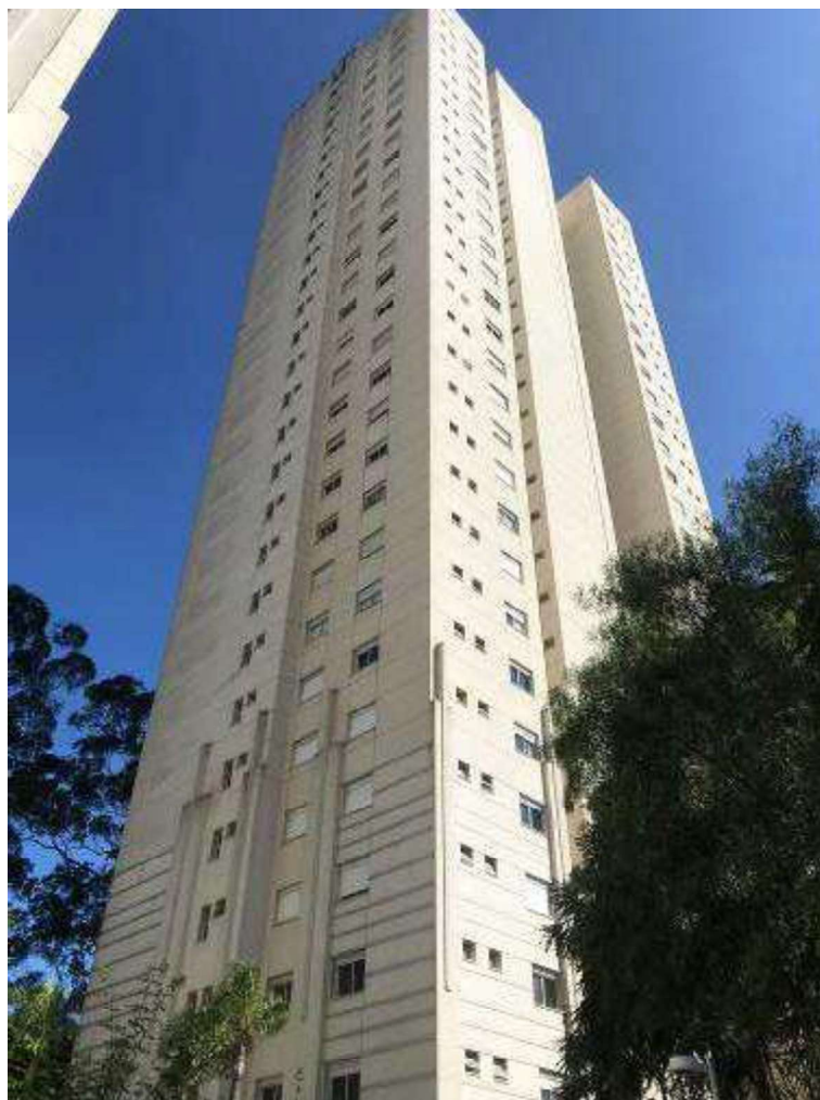
Aspectos parciais das fachadas lateral e posterior da Torre 6.
