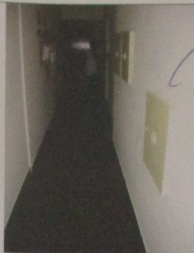
Foto 18 – Hall dos elevadores no andar.
