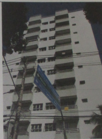
Foto 04 - Fachada principal do bloco I.
