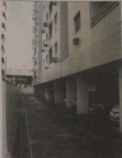
Foto 10 – Garagem no térreo.
