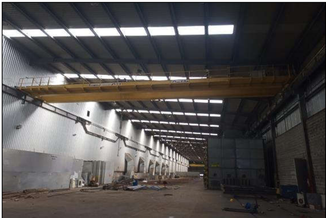
ITEM 1,059 - VISTA DA PONTE ROLANTE 10T INTERTECH GH
