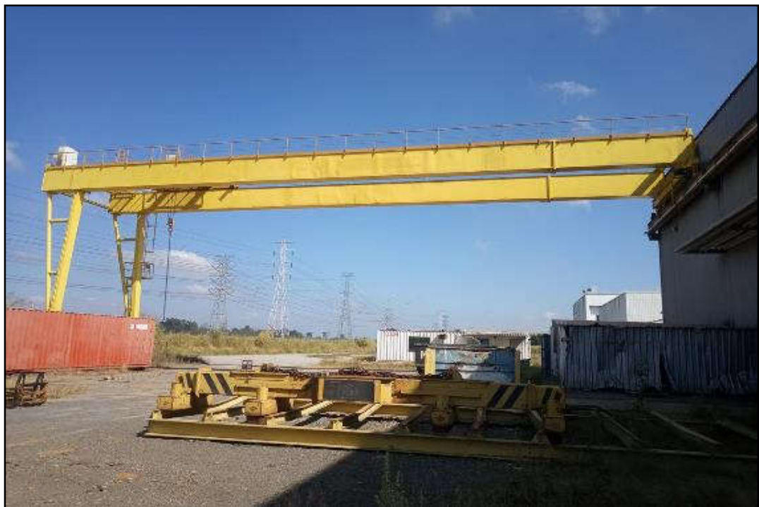
ITEM 1,083 - VISTA DA PONTE ROLANTE 16T
