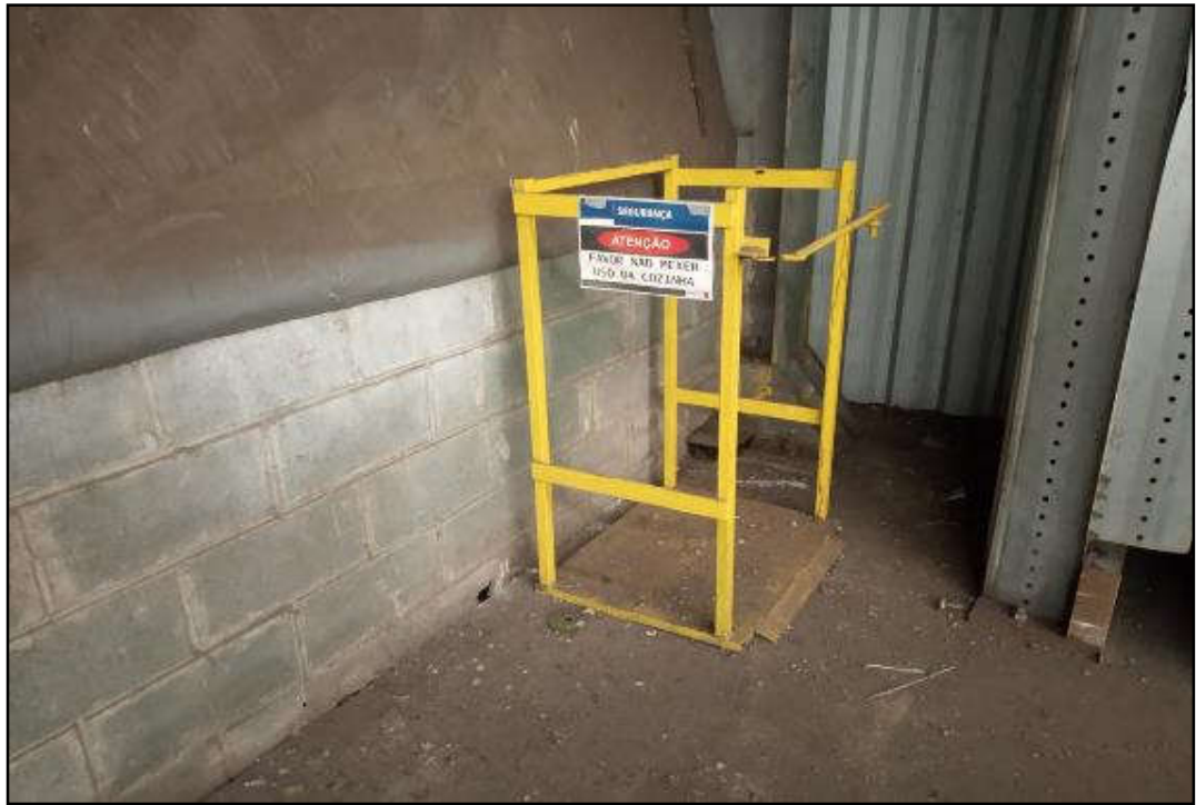
ITEM 5,113 - VISTA DA PORTA CILINDRO
