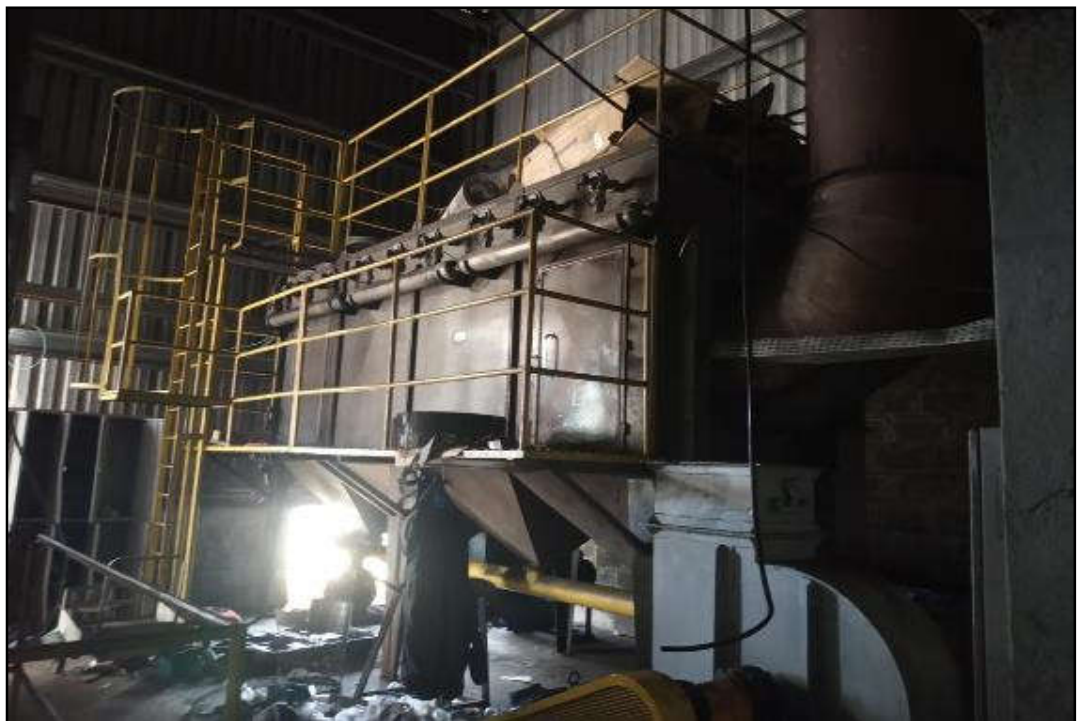
ITEM 1,039 - VISTA DA CABINE DE PINTURA
