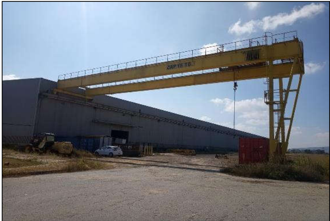
ITEM 1,083 - VISTA DA PONTE ROLANTE 16T
