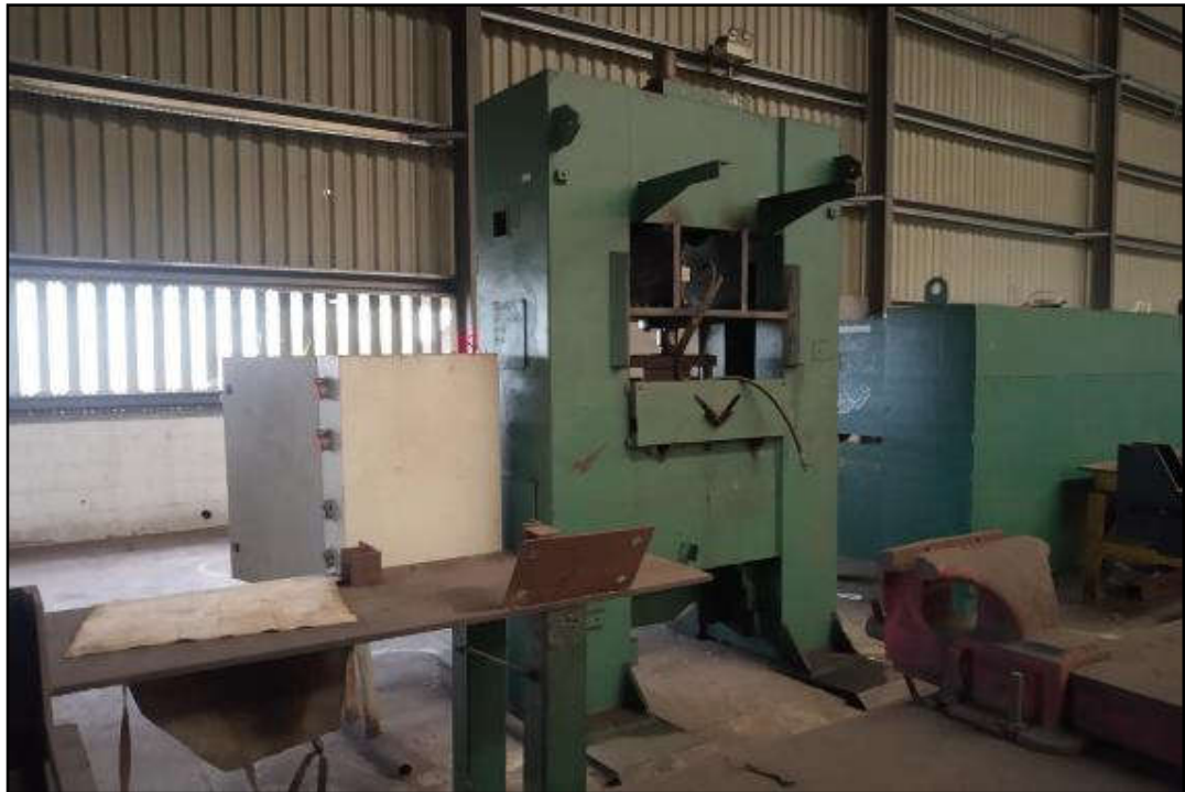
ITEM 1,001 - VISTA DA PRENSA HIDRÁULICA 150T PILARES
