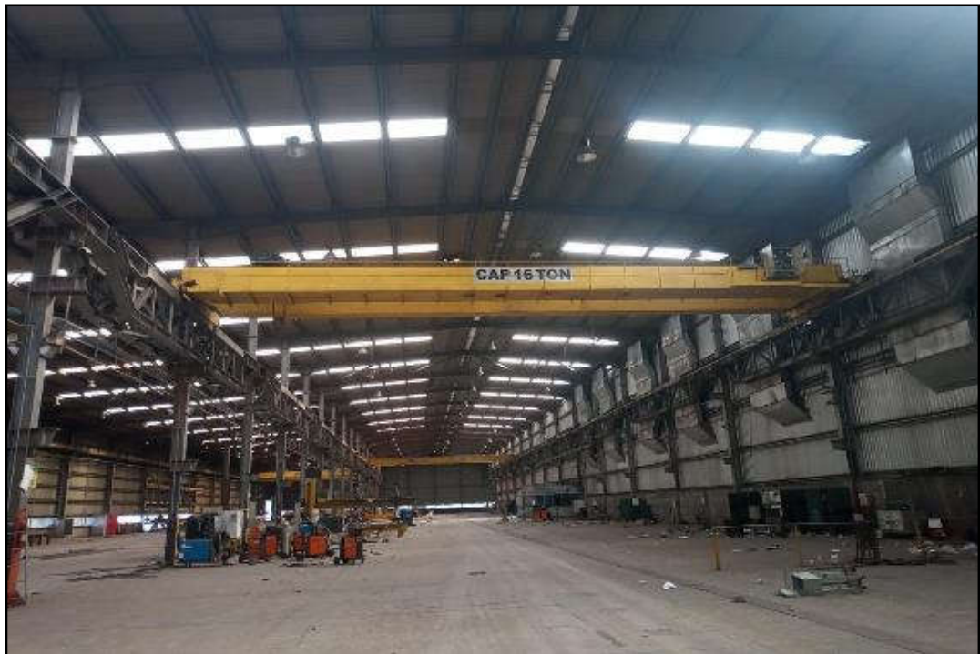
ITEM 1,055 - VISTA DA PONTE ROLANTE 16T
