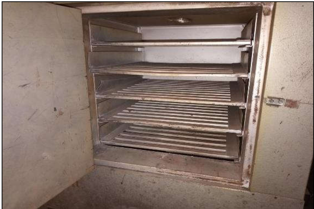
ITEM 1,062 - VISTA DA ESTUFA CBL ESTUFAS E FORNOS
