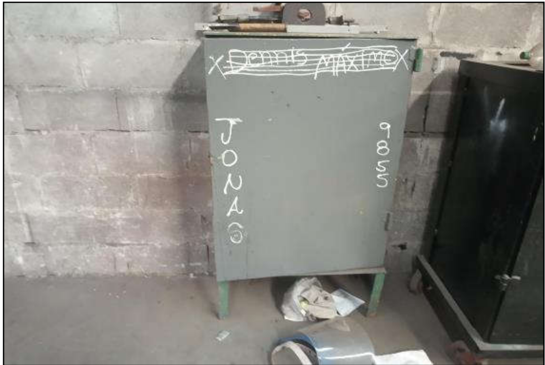
ITEM 5,024 - VISTA DO ARMÁRIO DE FERRO
