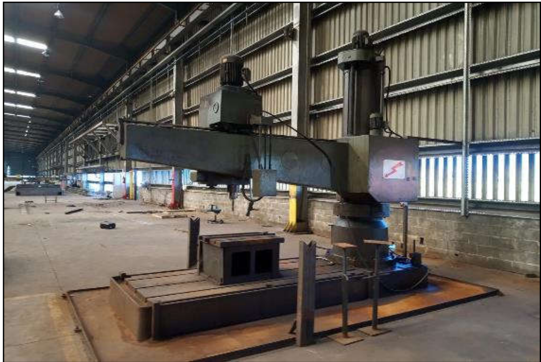
ITEM 1,006 - VISTA DA FURADEIRA RADIAL SORALUCE TR3-2500
