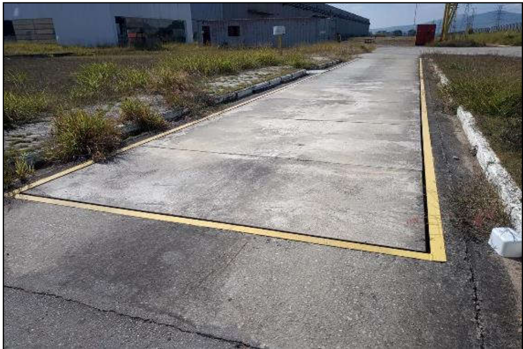
ITEM 1,084 - VISTA DA BALANÇA RODOVIÁRIA
