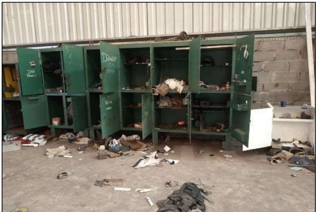
ITEM 5,067 - VISTA DO ARMÁRIO DE FERRO
