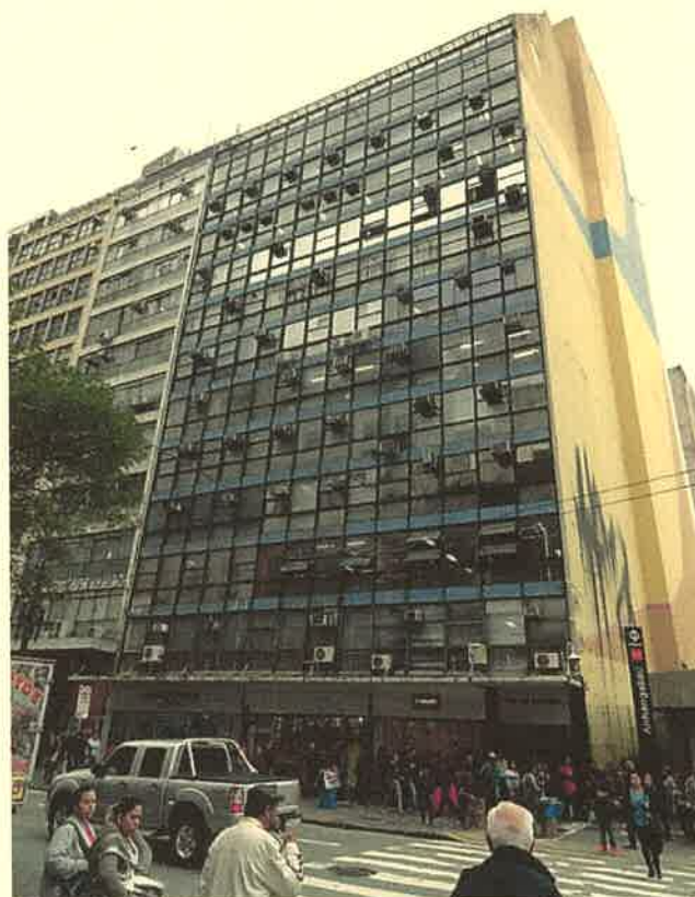
VISTA DA FACHADA DO EDIFÍCIO ONDE SE LOCALIZA A UNIDADE AVALIANDA.
