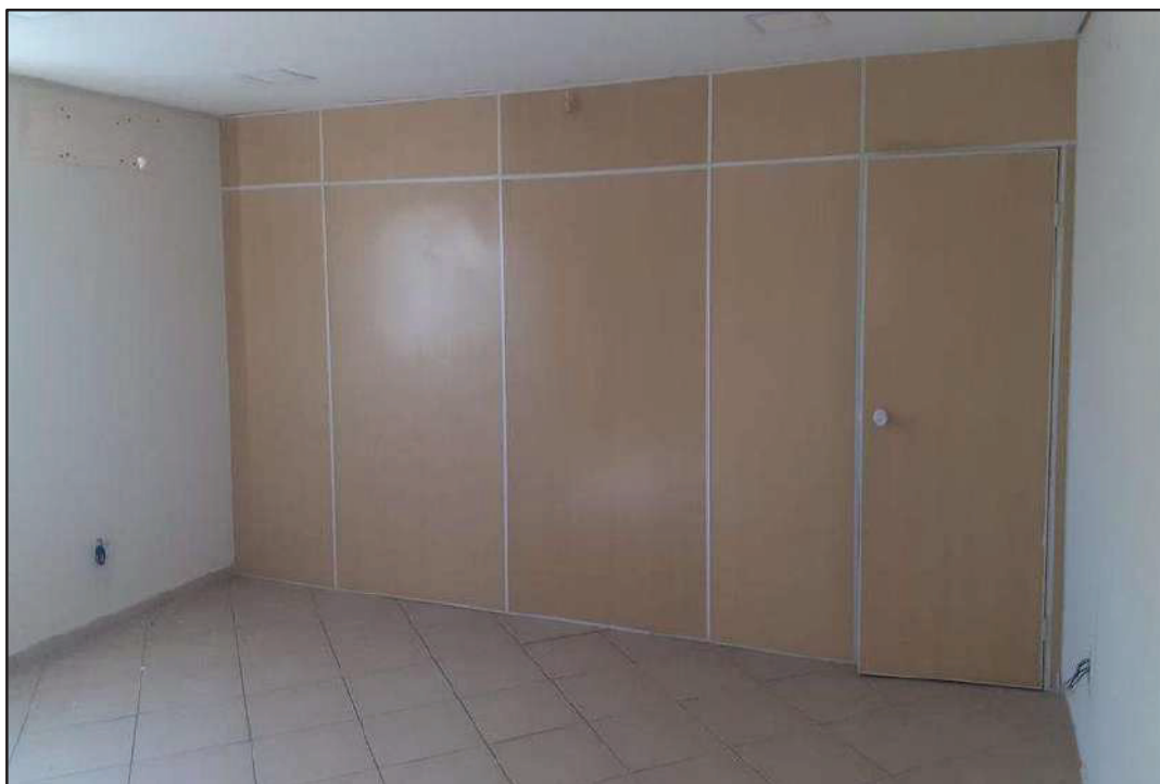
ITEM 1,038 - VISTA DAS PAREDES DIVISÓRIAS SALA 2
