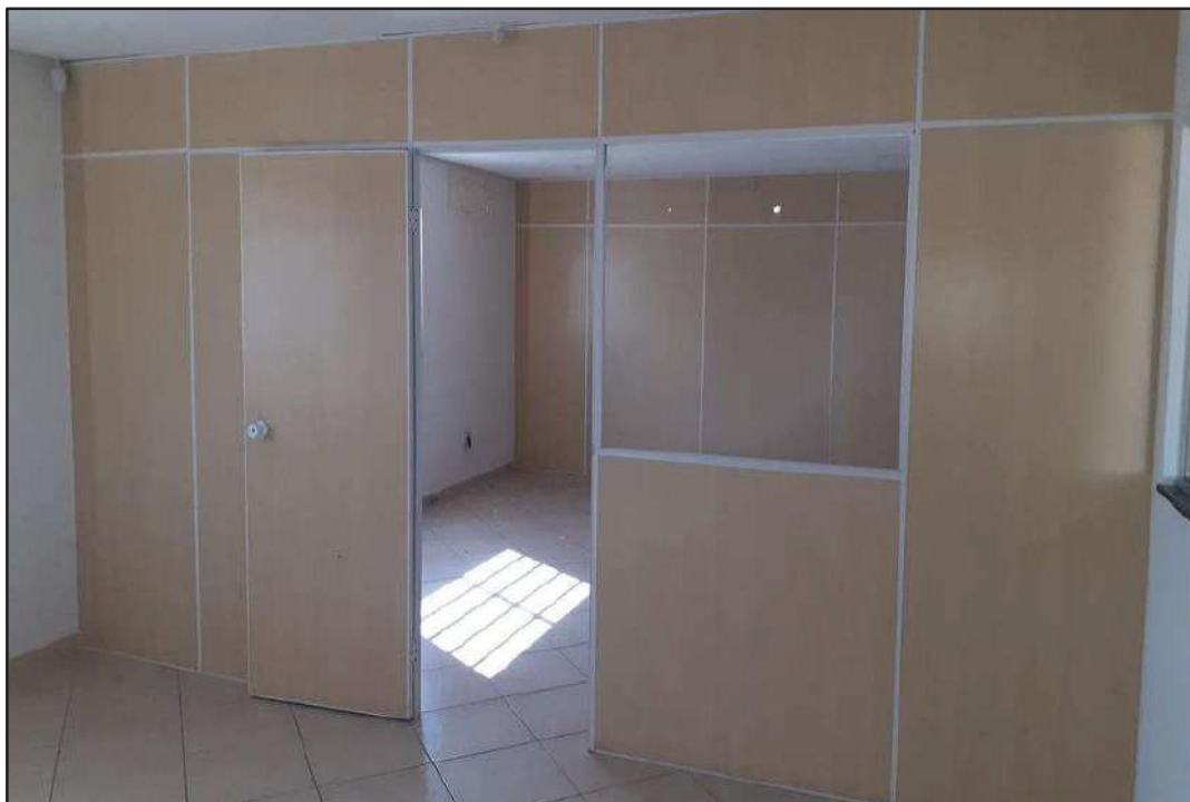
ITEM 1,037 - VISTA DAS PAREDES DIVISÓRIAS SALA 1
