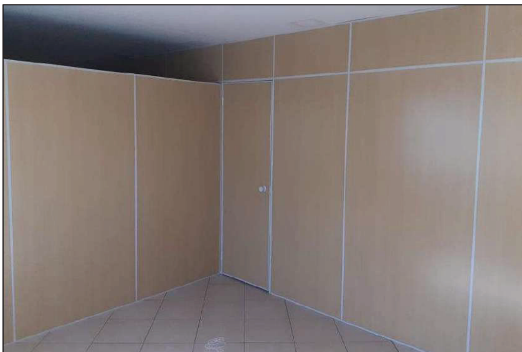
ITEM 1,039 - VISTA DAS PAREDES DIVISÓRIAS SALA 3
