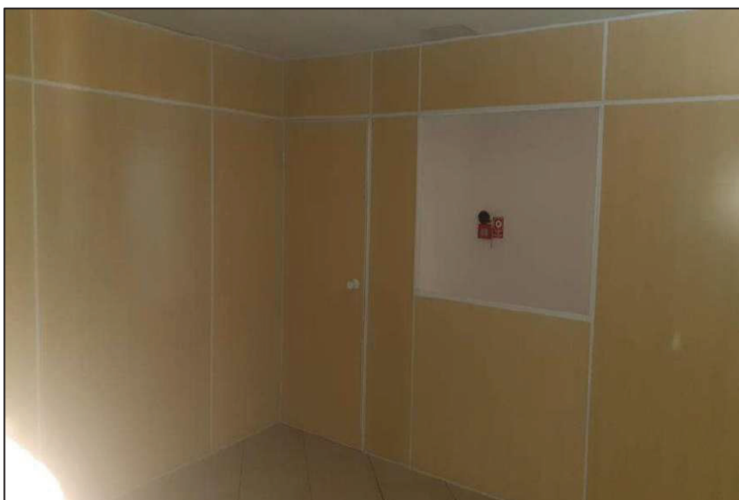
ITEM 1,040 - VISTA DAS PAREDES DIVISÓRIAS SALA 4
