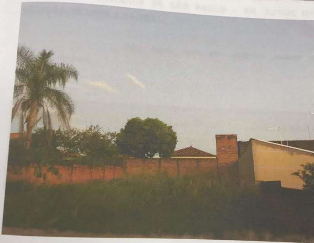
VISTA DO IMÓVEL AVALIANDO.
