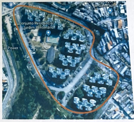
Vista aérea do conjunto
