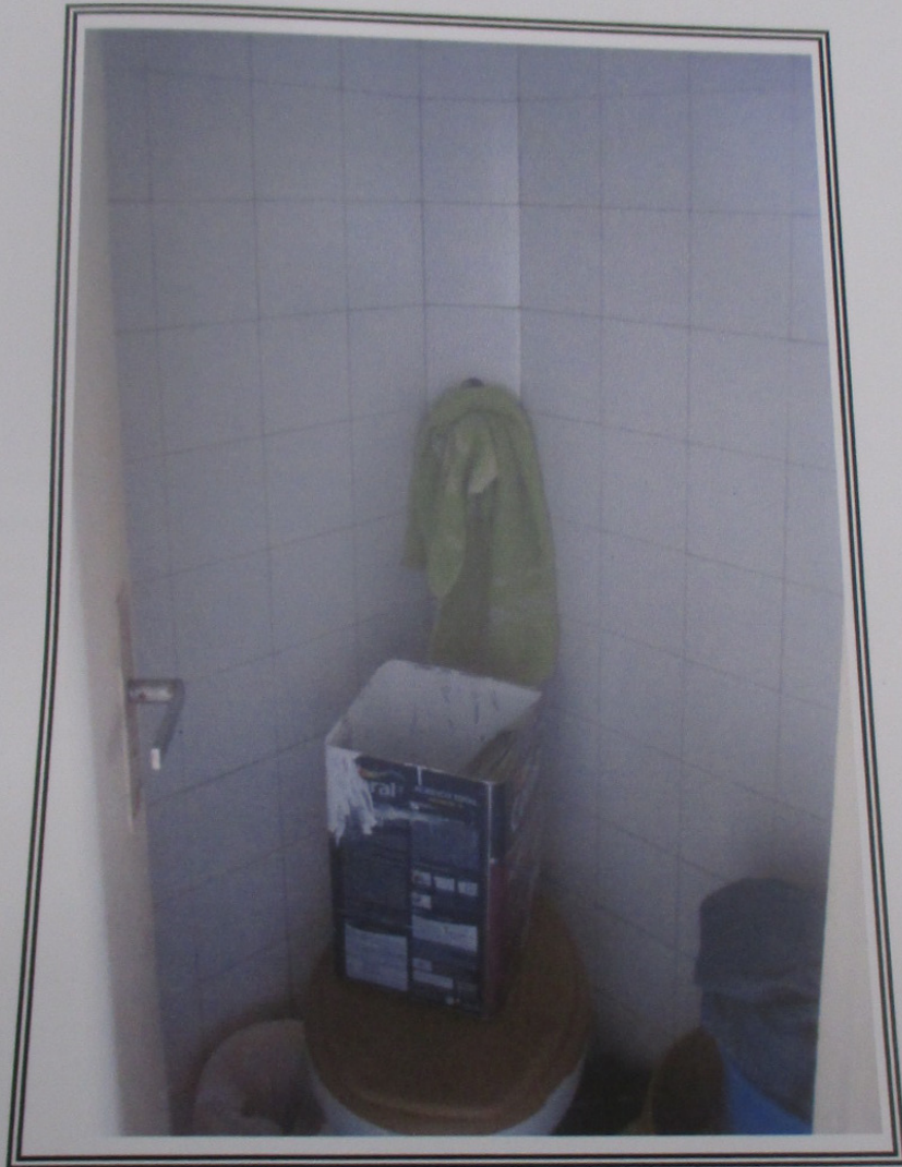
Foto nº 18: Vista do Banheiro de Empregada
