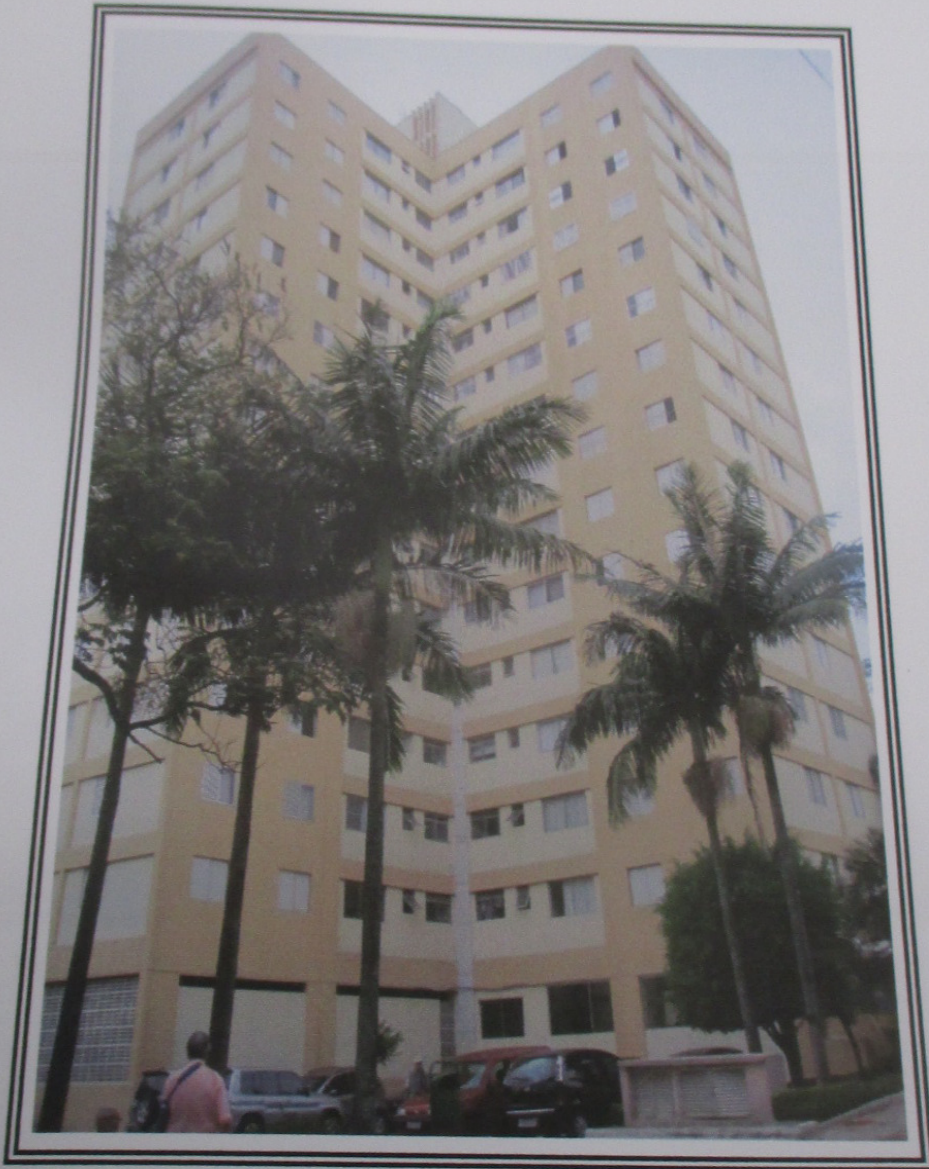
Foto nº 06: Vista do Edifício Fênix (Bloco A-1) onde se encontra o Imóvel Avaliando
