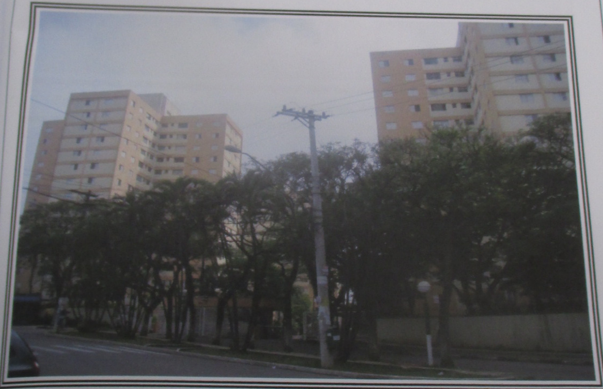
Foto nº 01: Vista geral do Conjunto Residencial Parque dos Pássaros
