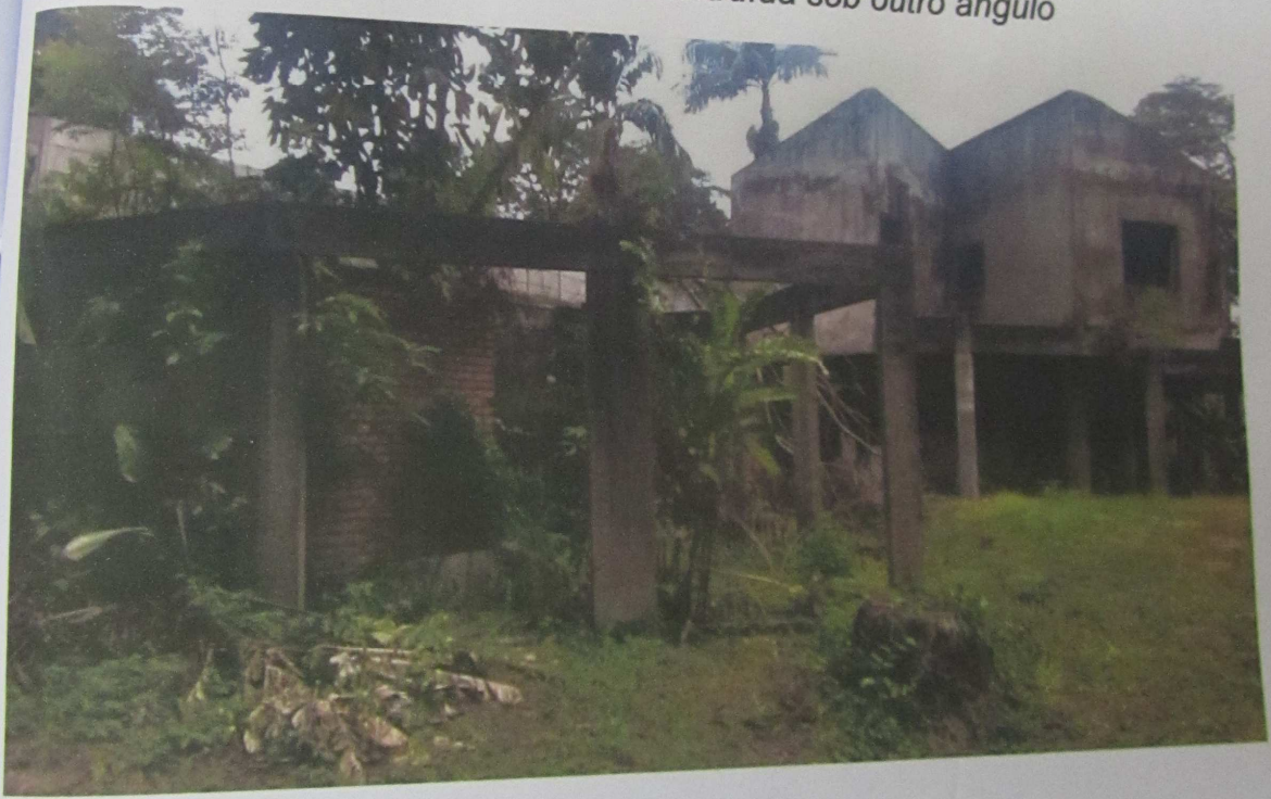
Foto 11: Vista da casa inacabada ("edícula")
