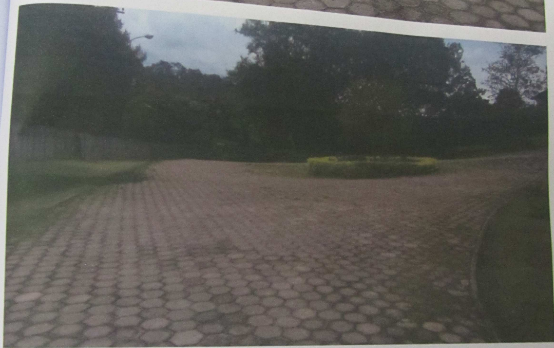
Fotos 18 e 19: Pavimento da rua interna do condomínio, defronte o imóvel avaliando
