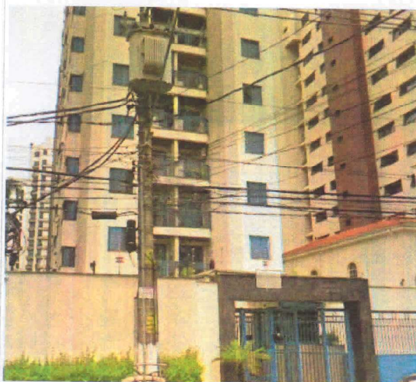
Vista de frente do Edifício
