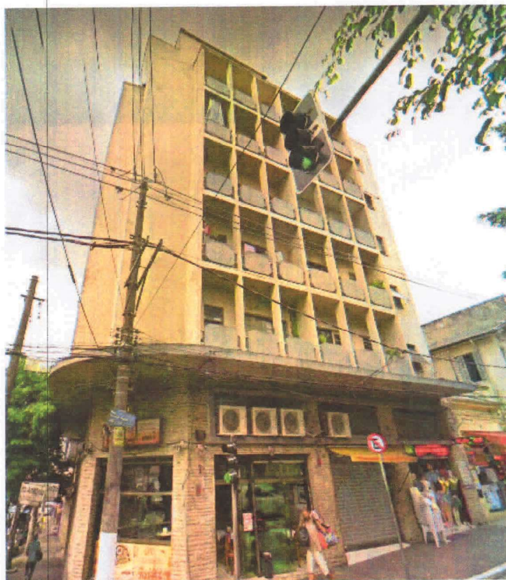
Vista de frente do edifício
