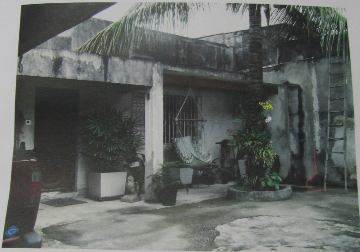
FOTO 3: FACHADA DO IMÓVEL.
