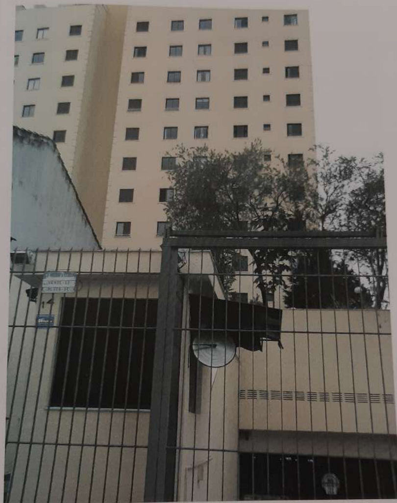
FOTO 3: FACHADA DO IMÓVEL.
