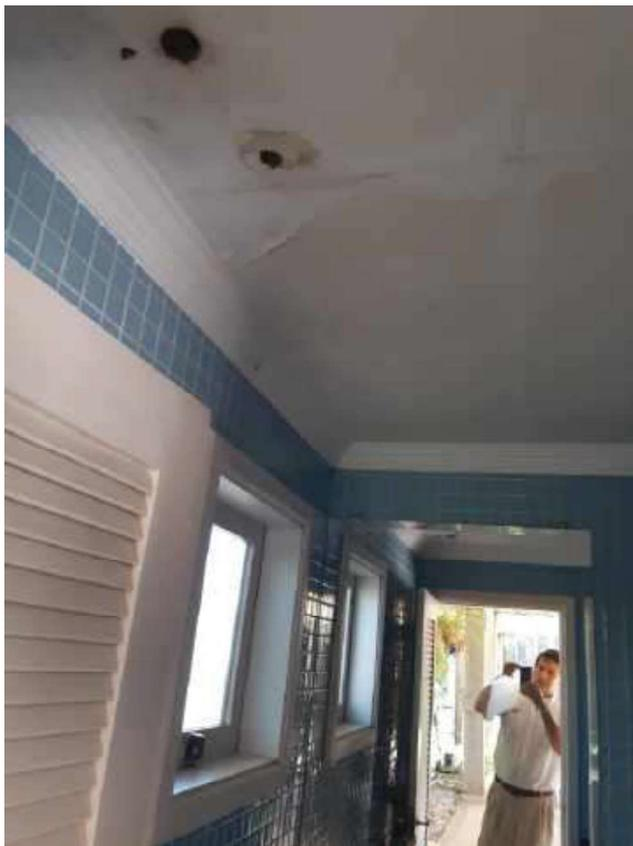
**FOTO 40** – Sinais de infiltração no teto do banheiro da edícula.
