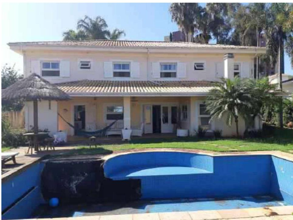
**FOTO 46** – Vista dos fundos da casa. Piscina com revestimento e manta impermeabilizante soltos.
