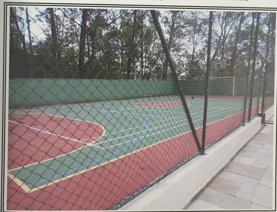
Foto nº 33: Vista da quadra poliesportiva do Condomínio
