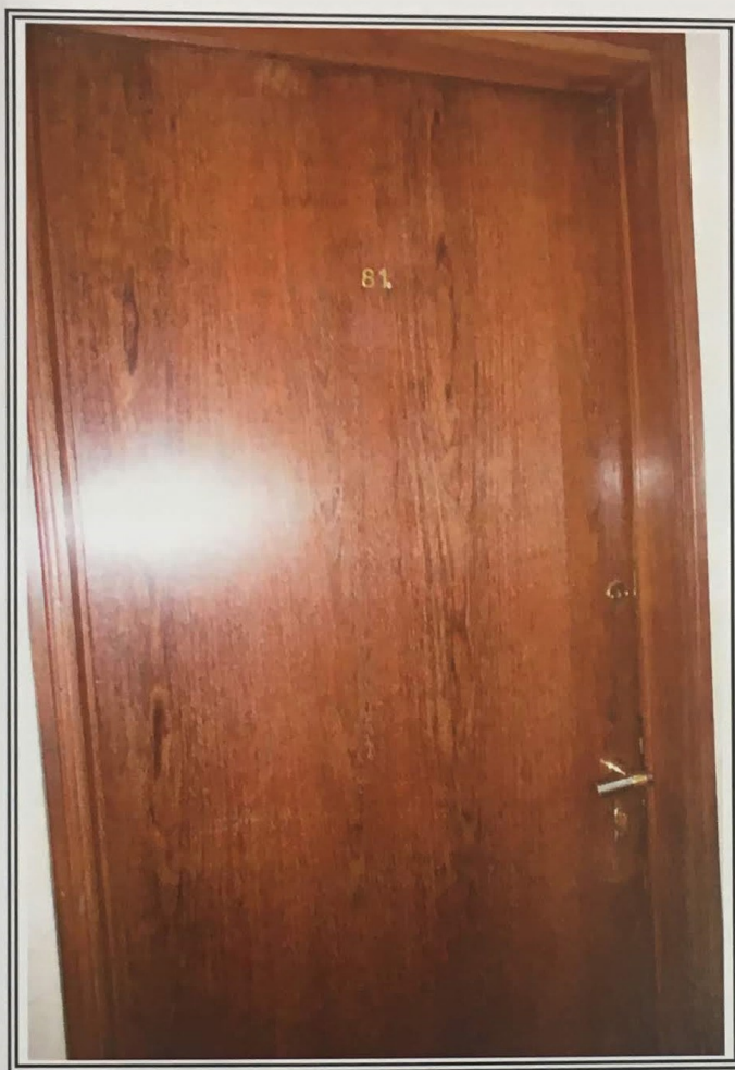
Foto nº 08: Vista do hall de entrada do imóvel avaliando (apto. nº 81)
