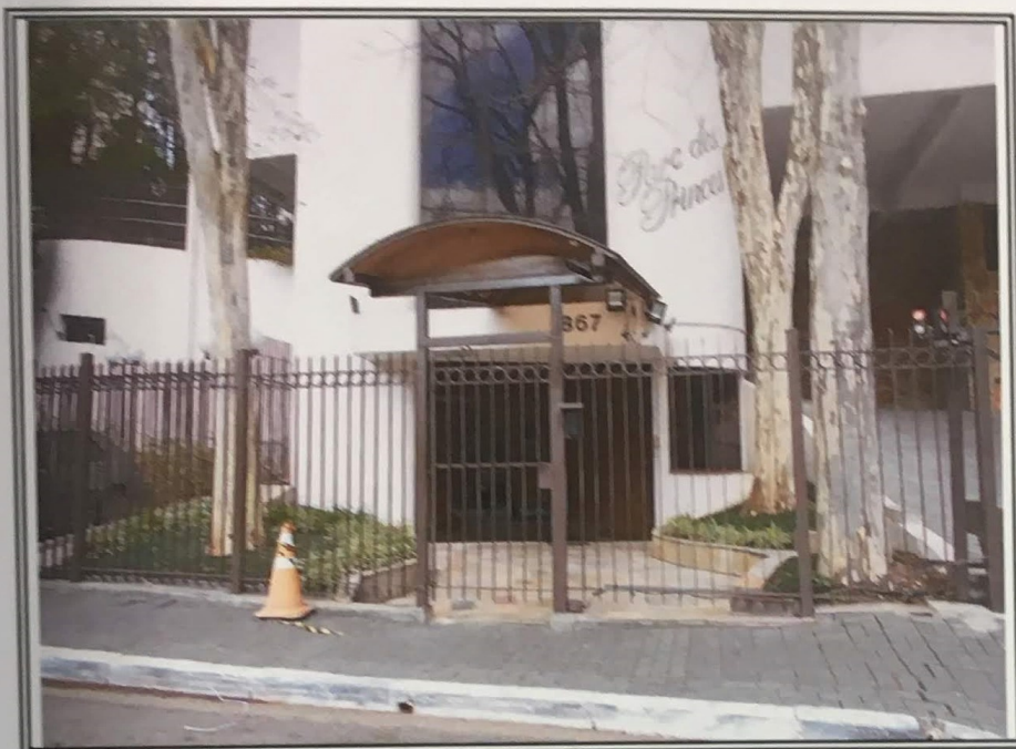
Foto nº 04: Vista da portaria do Condomínio Edifício Parc Des Princes
