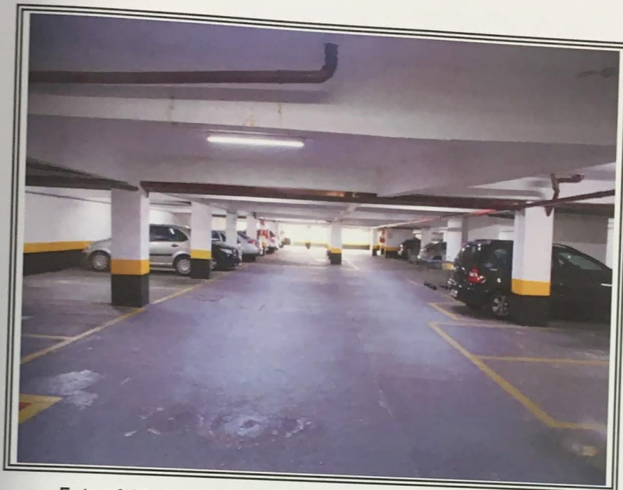
Foto nº 30: Vista geral do estacionamento do Condomínio
