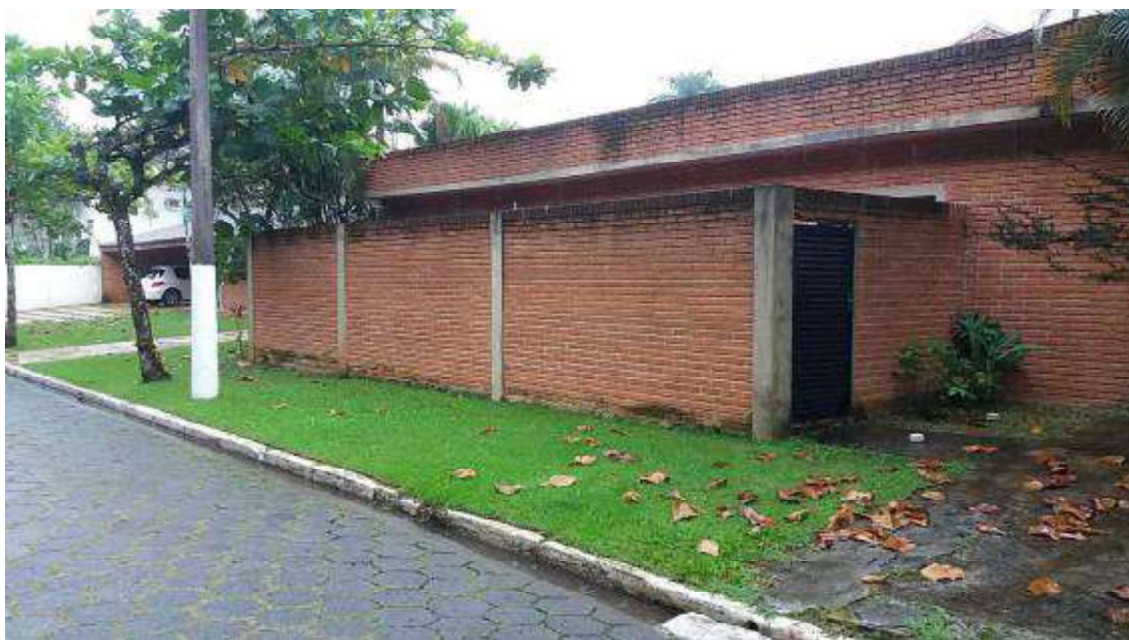
Foto 1B – Vista 02 Fronte/Lateral da Casa
