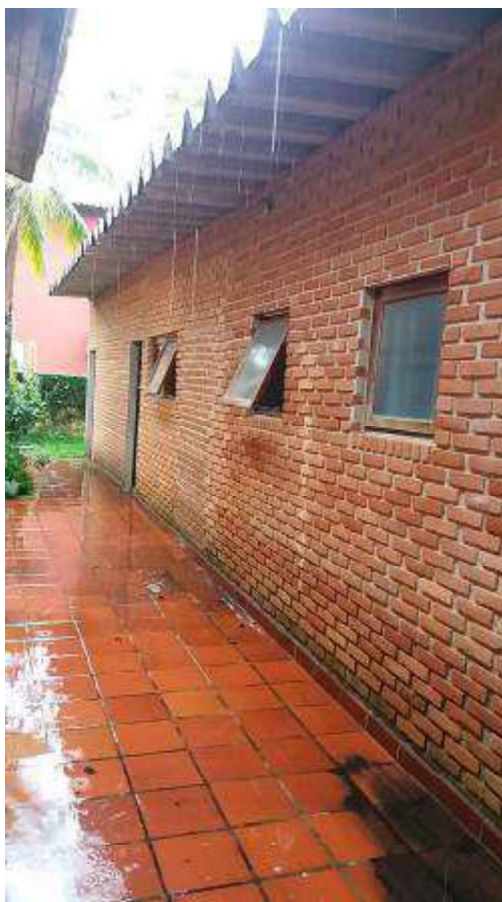
Foto 28 – Vista lateral Casa do Caseiro
