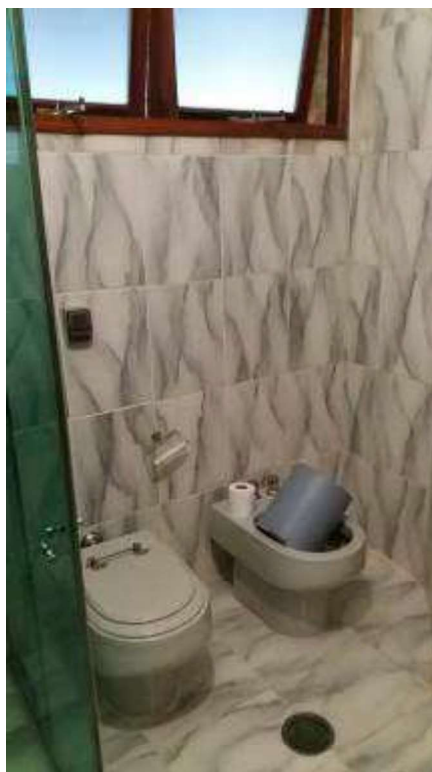
Foto 23C – Vista 02 WC suíte 04 (área externa da casa)
