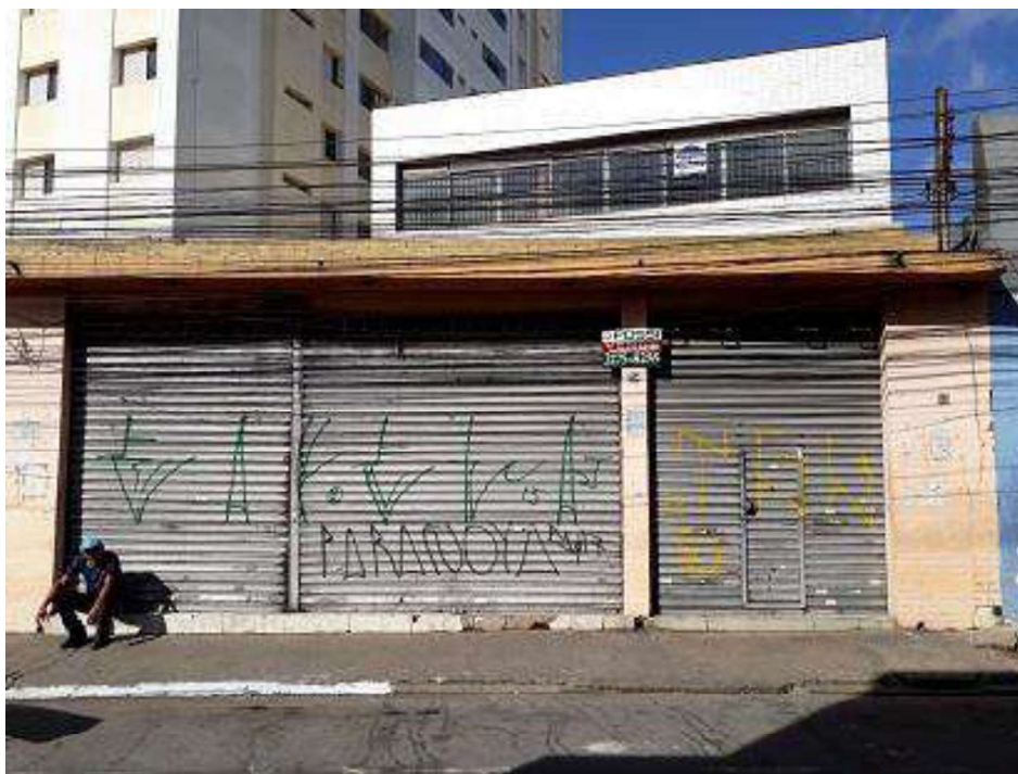
Fachada do imóvel vista da Rua Prom. Gabriel Nettuzzi Perez.
