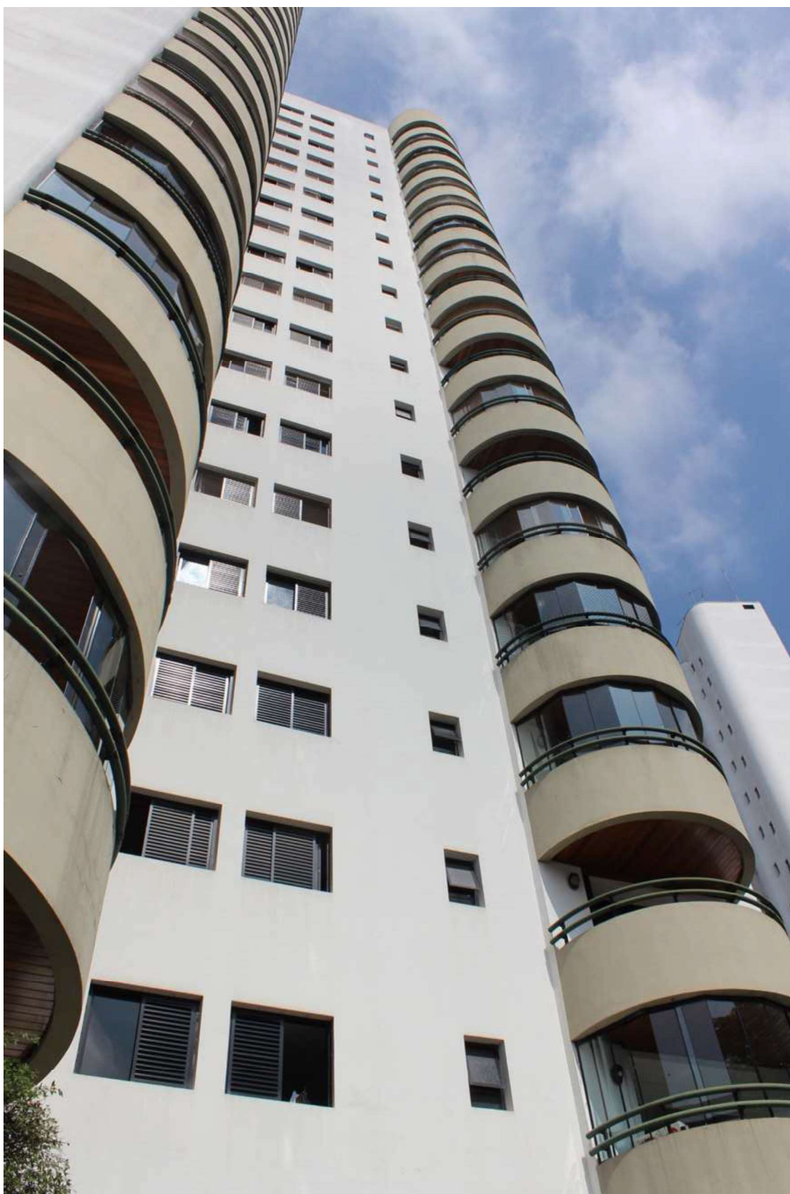
Rua Atibaia, 588 - Ap. 101(Condomínio Edifício Piazza di Treviso) – Fachada Lateral
