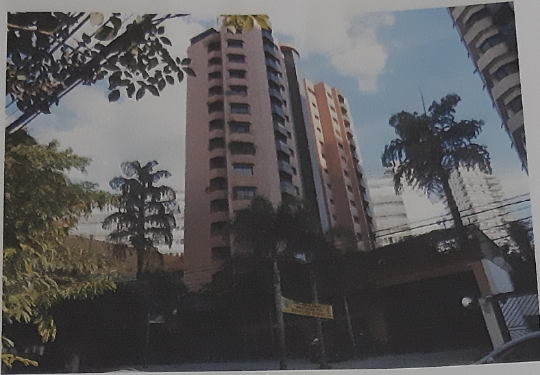
Foto 1 – Frente do imóvel
