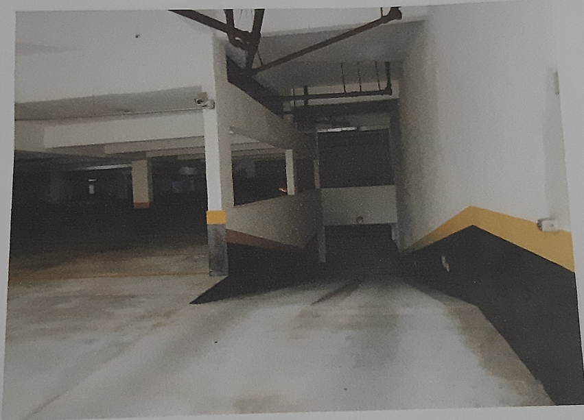
Foto 4 – Garagens no subsolo
