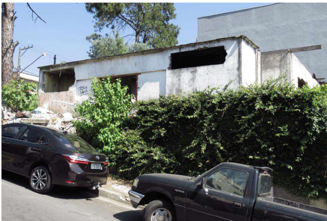
Construção inserida no imóvel avaliando sem valor.
