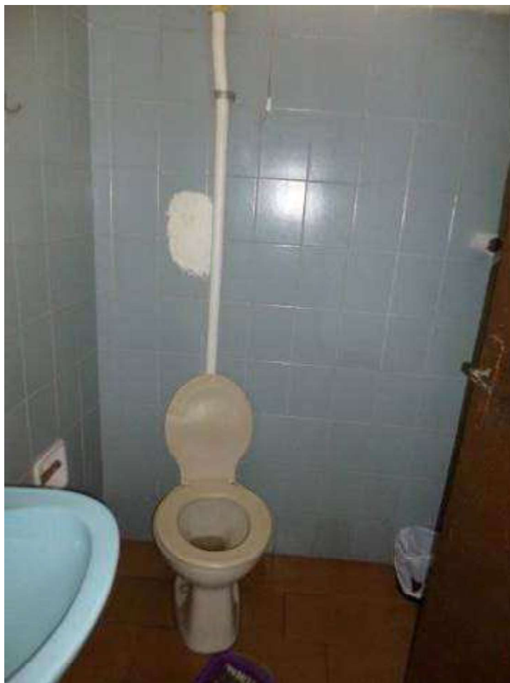
Vista parcial do banheiro.
