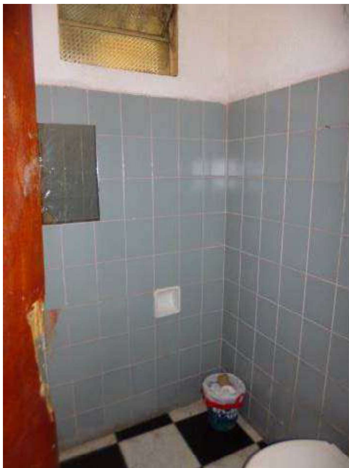
Vista parcial de um banheiros.
