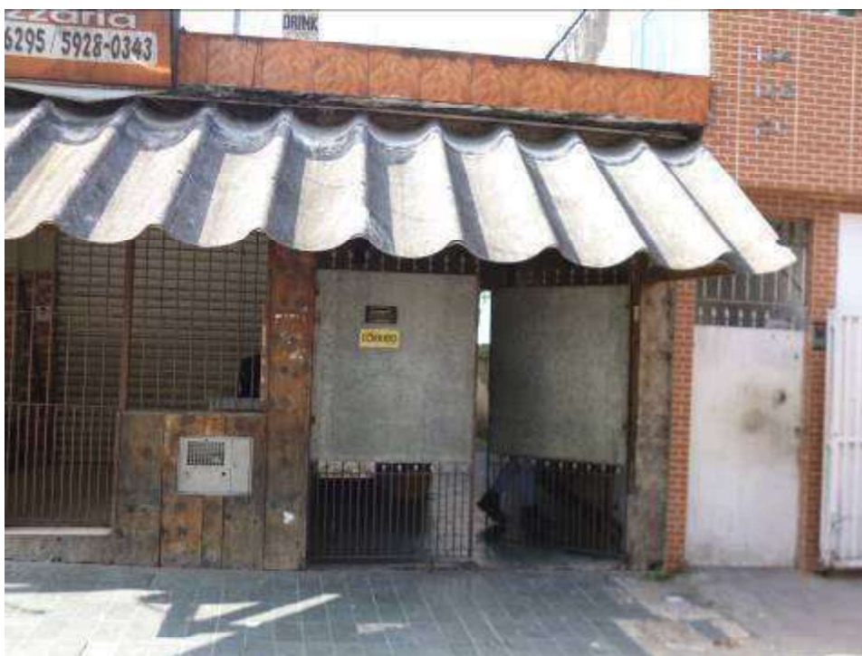
Fachada do prédio nº. 13-C (Garagem e acesso à casa da Sra. Vânia).
