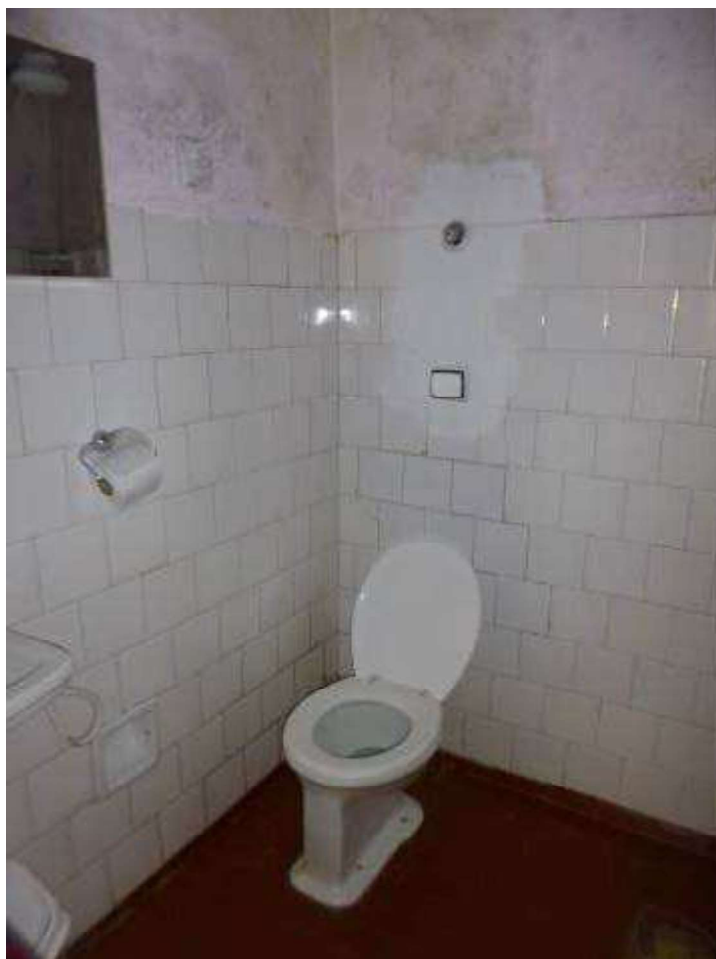
Vista parcial do banheiro.
