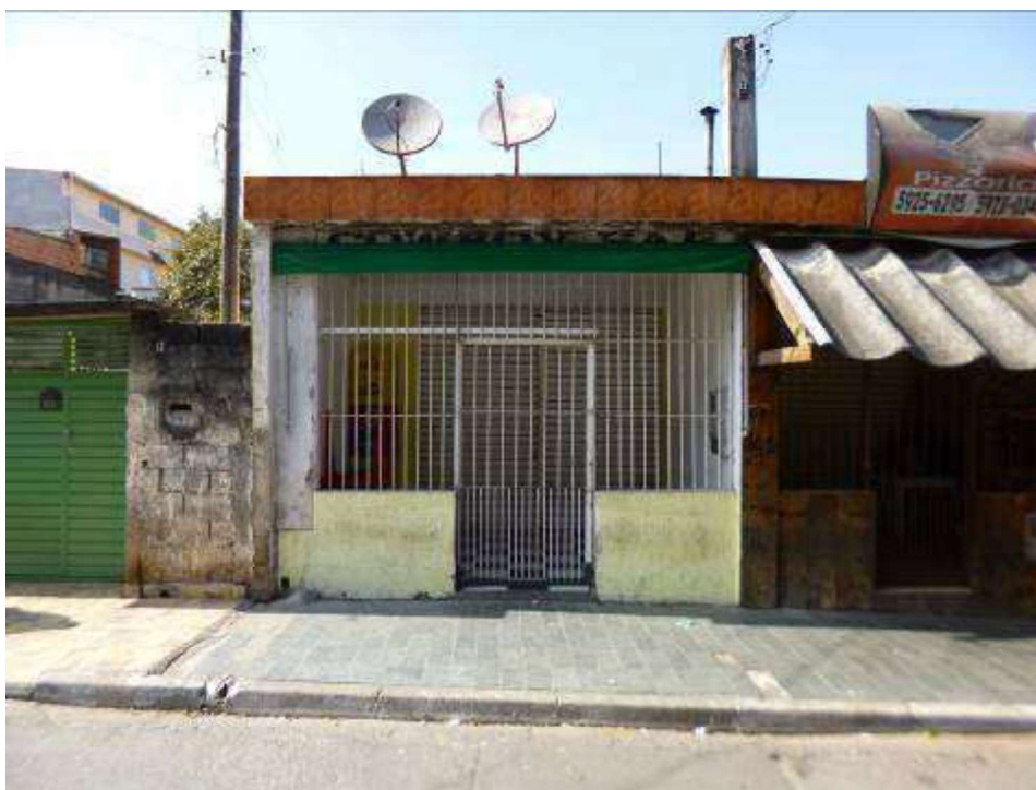
Fachada do prédio nº. 13-A (Bar).
