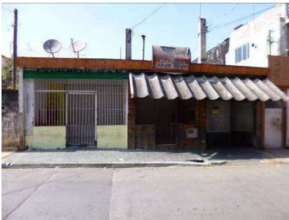
Fachada do imóvel situado na Rua São Bento Cottolengo, nº. 13.
