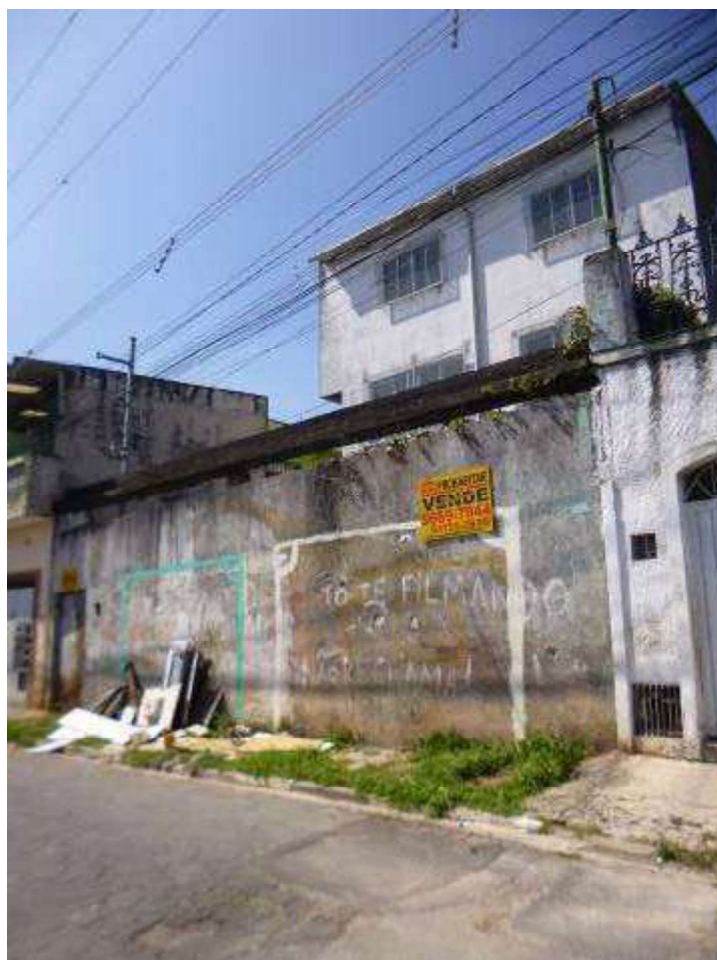
Rua Manoel Lopes, ao lado do nº. 174
