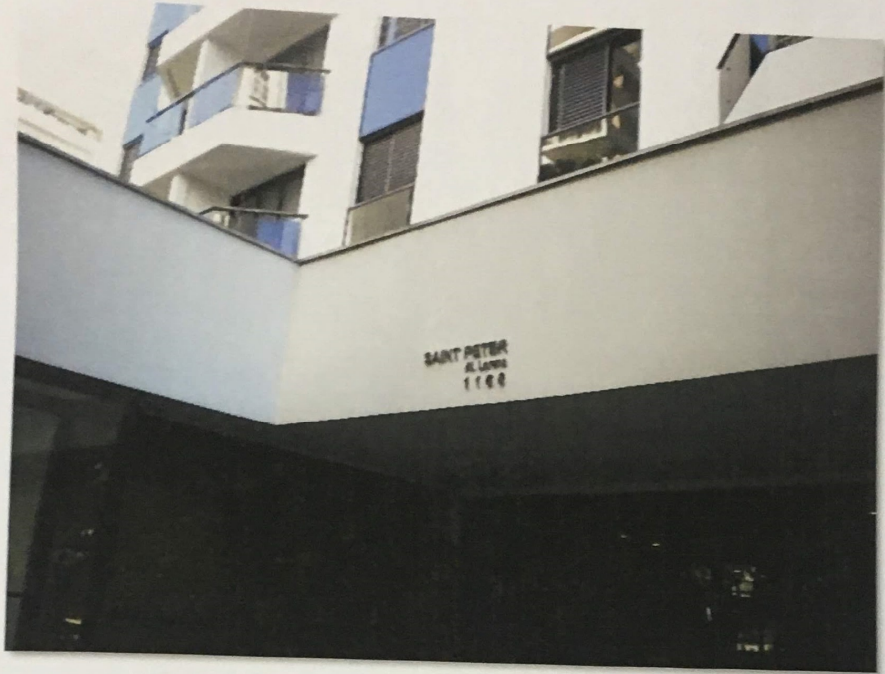
Foto nº 5 – Entrada e identificação do imóvel.
