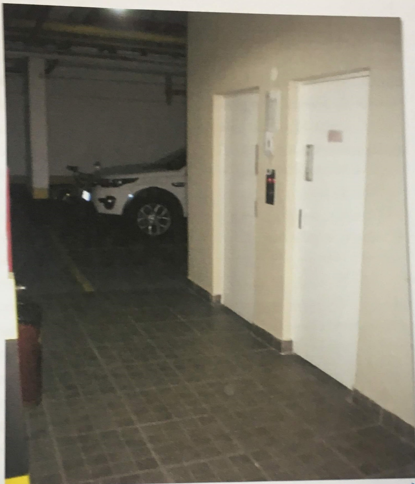
Foto nº 11 – Hall dos elevadores do subsolo.
