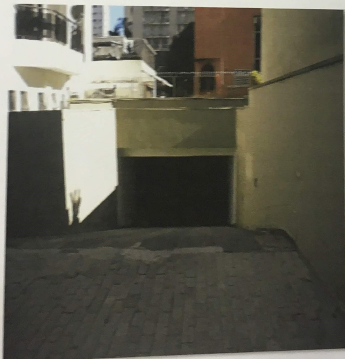
Foto nº 7 – Rampa de acesso aos subsolos.
