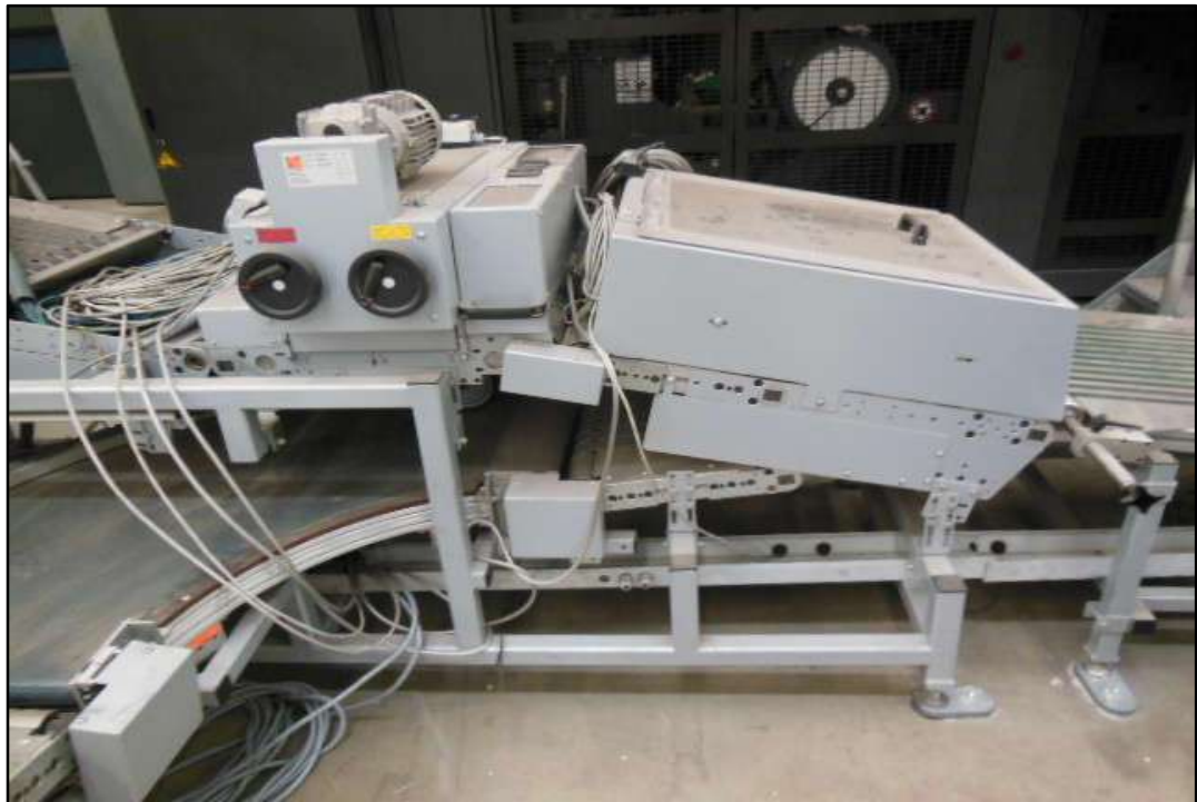
ITEM 1,033 - VISTA DA ESTEIRA (SAÍDA NA LATERAL DA GOSS) MARCA: TRANSNORM
