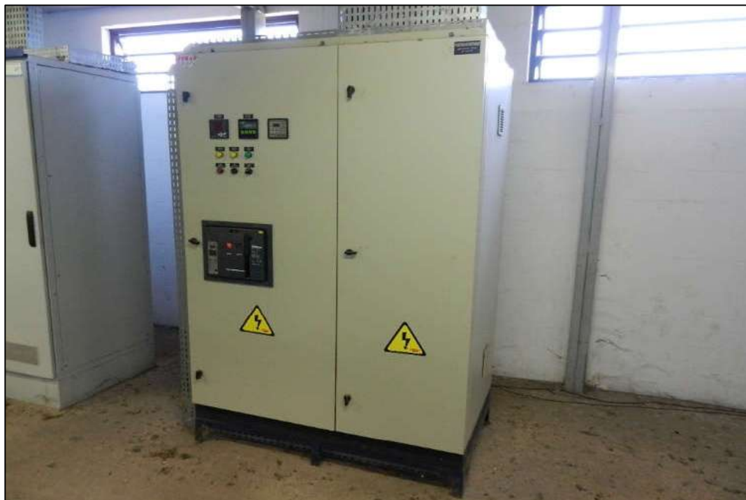
ITEM 1,125 - VISTA DO QUADRO DE COMANDO MARCA: MAK DIM: 2000 X 1400 X 850 MM TIPO: PGBT-03 - ROTATIVA 01 COM 1 DISJUNTOR GERAL MARCA: SCHNEIDER NW32H1 65 KA, MULTIMEDIDOR DE GRANDEZAS ELETRICAS, CONTROLADOR DE FATOR POTENCIA E DEMAIS COMPONENTES
