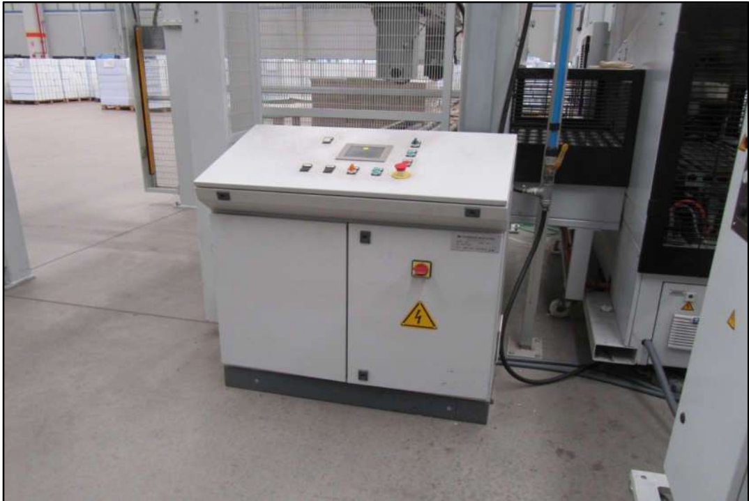
ITEM 1,028 - VISTA DA PALETIZADORA/CINTADEIRA MARCA: RIMA-SYSTEM MODELO: PL-86 N° 01838-2250-02
