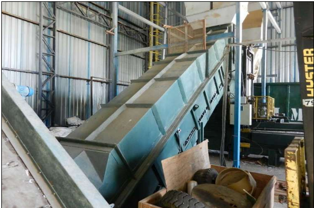
ITEM 1,146 - VISTA DA LINHA DE Prensagem de Aparas de Papel compreendendo os itens (esteira inclinada para alimentação da prensa)
