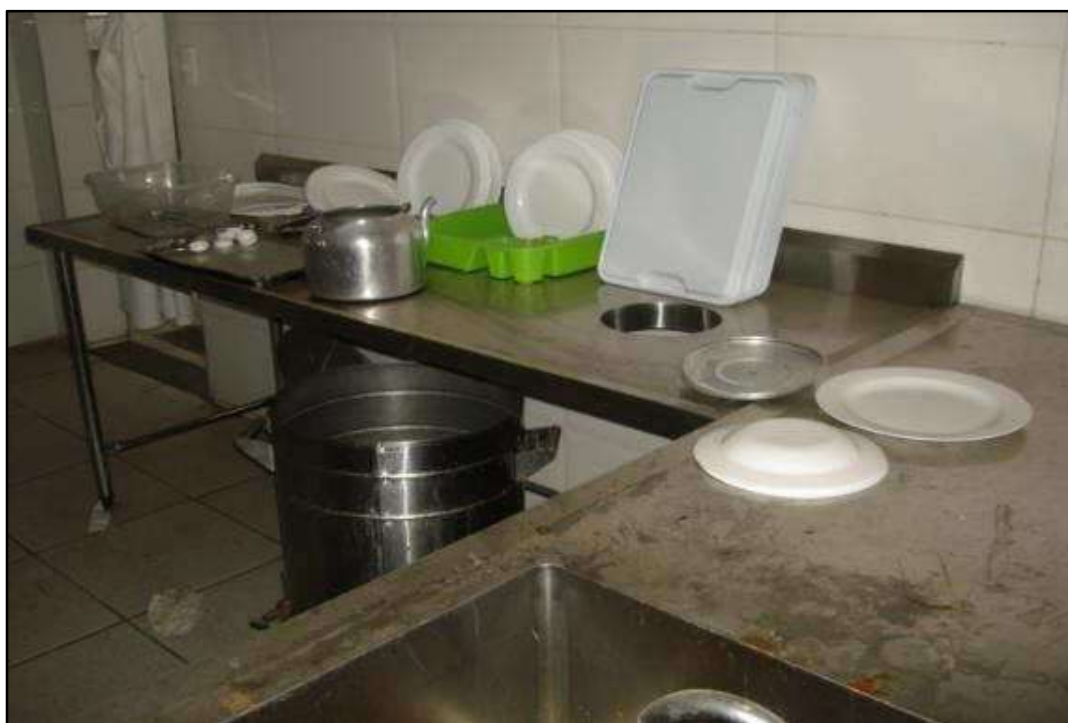
ITEM 0217 - VISTA DA BANCADA LISA COM FURO PARA DETRITOS DIM: 220X60 CM
