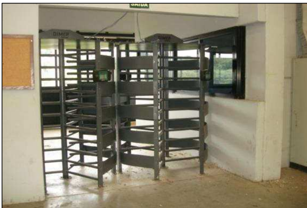
ITEM 0227 - VISTA DA CATRACA TORNIQUETE MARCA: DIMEP
