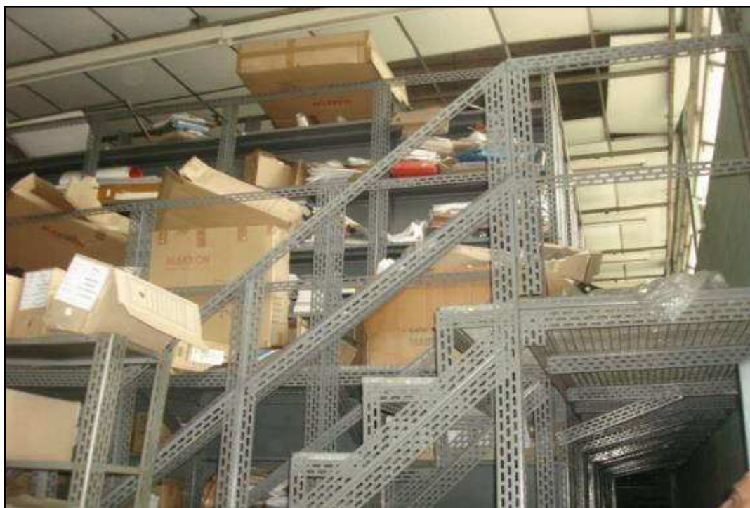
ITEM 1,632 - VISTA DO MEZANINO DE FERRO COM ESCADA DE 19 DEGRAUS COM 2,5M DE ALTURA E PISO SUPERIOR COM 16X5M
