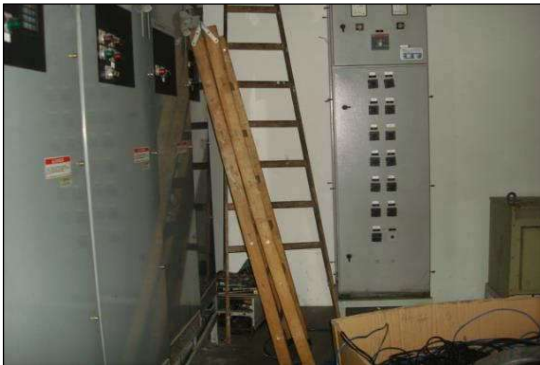
ITEM 2980 - VISTA DA ESCADA DE MADEIRA
