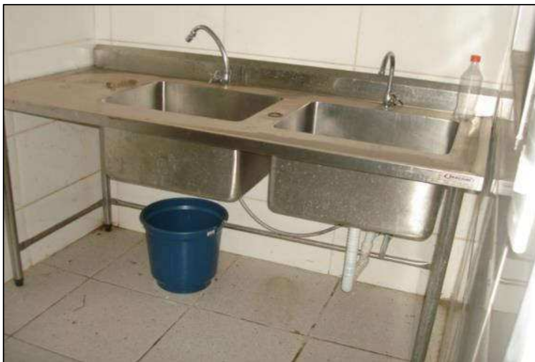
ITEM 0206 - VISTA DA PIA DE INOX COM 2 CUBAS E 2 TORNEIRAS DIM: 60X150 CM
