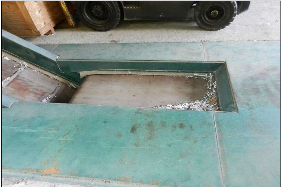
ITEM 1,146 - VISTA DA LINHA DE PRENSAGEM DE APARAS DE PAPEL COMPREENDENDO OS ITENS (ESTEIRA DE ALIMENTAÇÃO HORIZONTAL)
