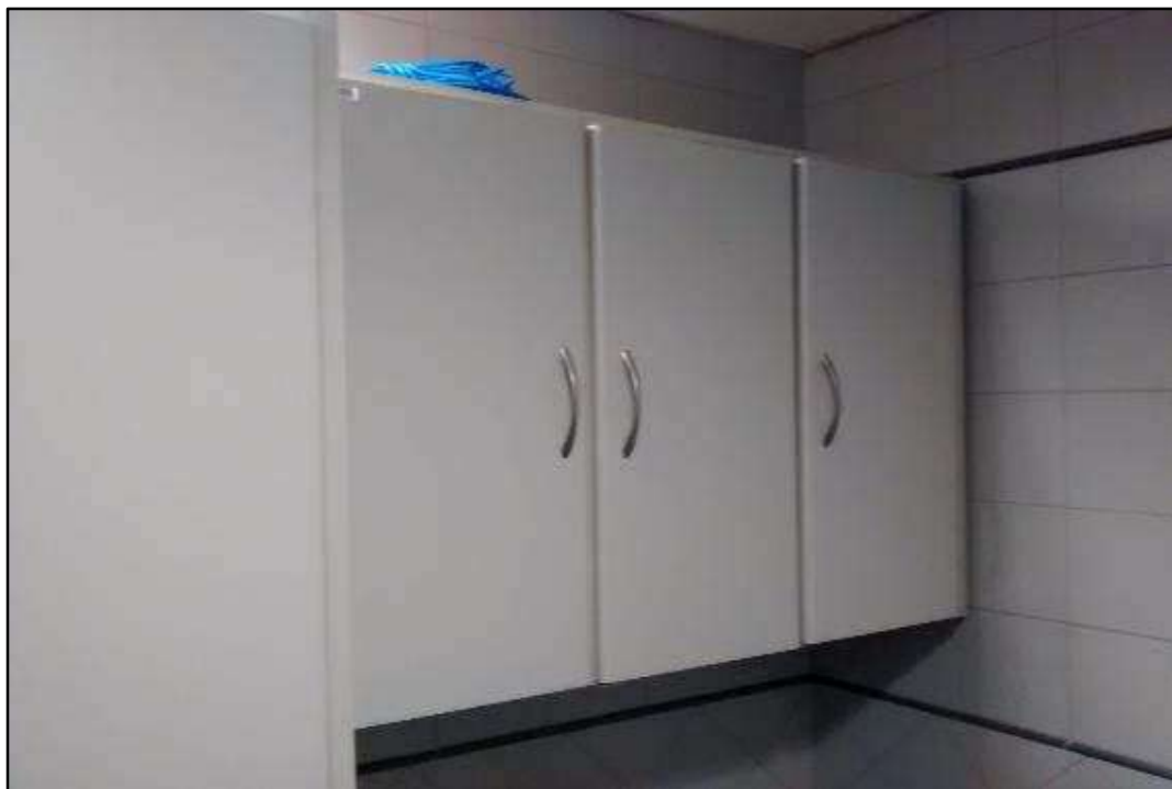
ITEM 1,287 - VISTA DO ARMÁRIO 3 PORTAS
