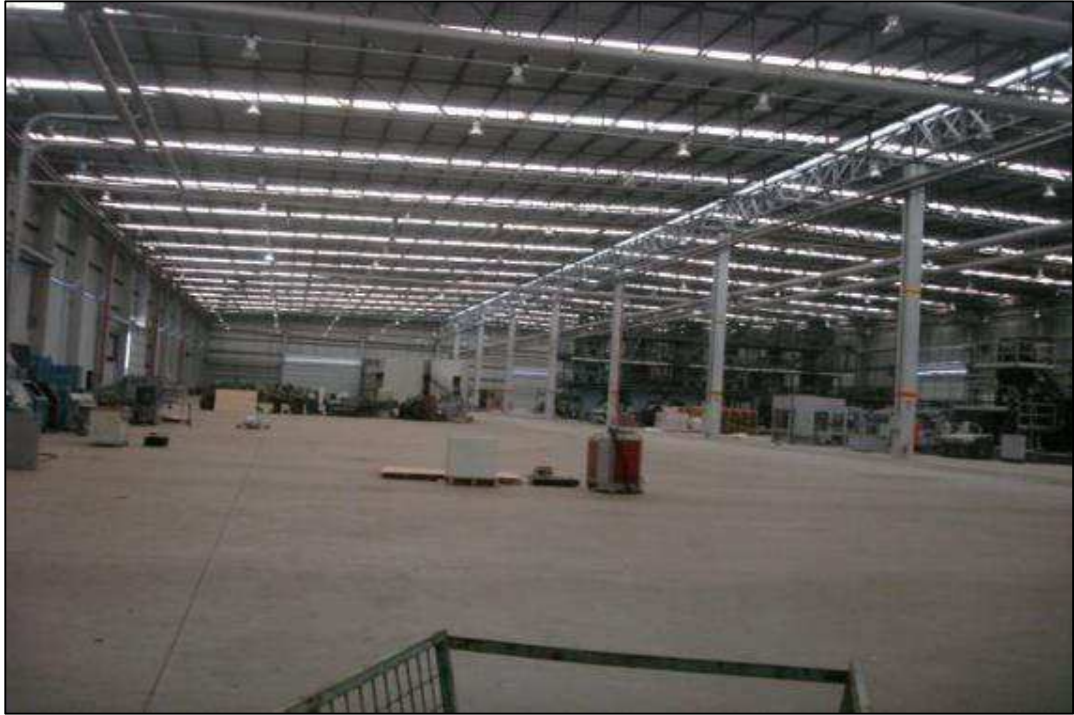
VISTA DOS DUTOS
