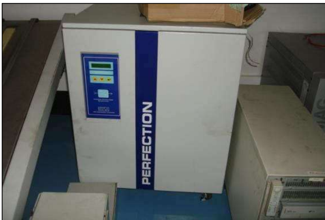
ITEM 0161 - VISTA DO ESTABILIZADOR ELETRÔNICO DIGITAL MICROPROCESSADO MARCA: CM COMANDOS LINEARES MOD: PERFECTION
