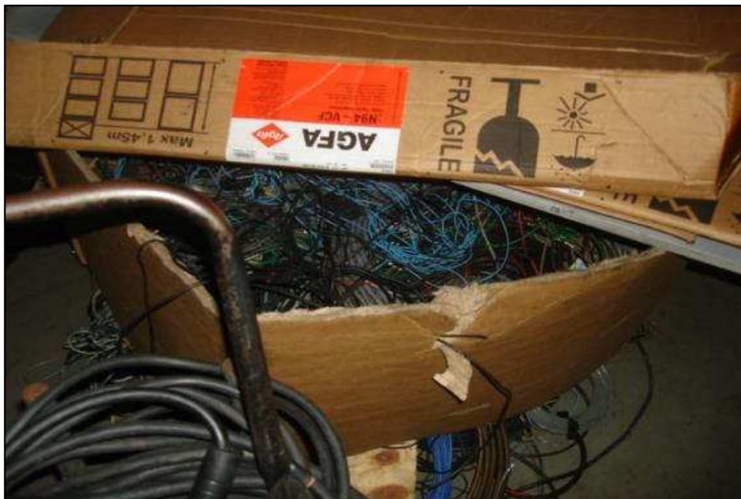
ITEM 2955 - VISTA DA CAIXA COM CABOS (DIVERSOS)
