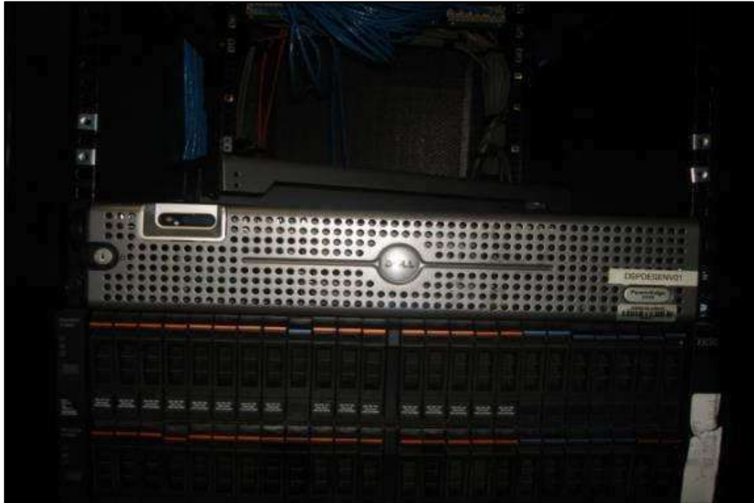
ITEM 1,355 - VISTA DO SERVIDOR DELL POWER EDGE 2950
