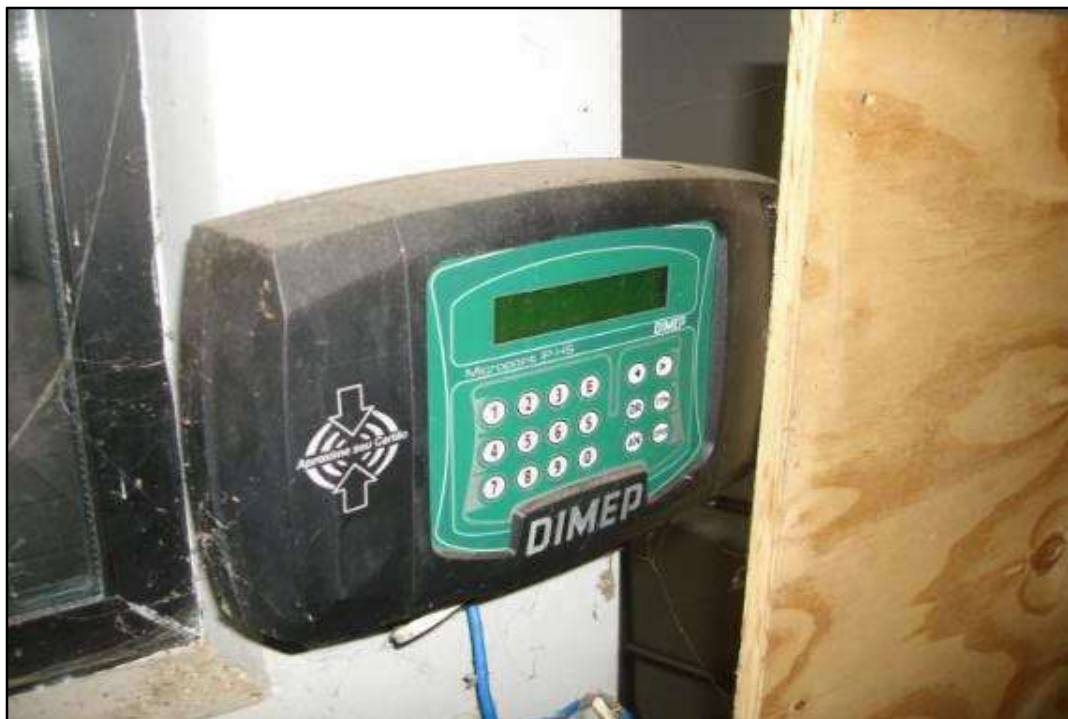
ITEM 0205 - VISTA DO CONTROLE DE ACESSO MARCA: DIMEP MOD: MICROPOINT IP HS
