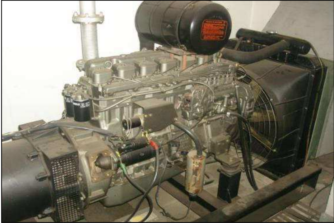
ITEM 1,876 - VISTA DO MOTOR - MWM DIESEL, ANO 2000, CILINDRADA - 6.450 132 KWA 1789 RPM
