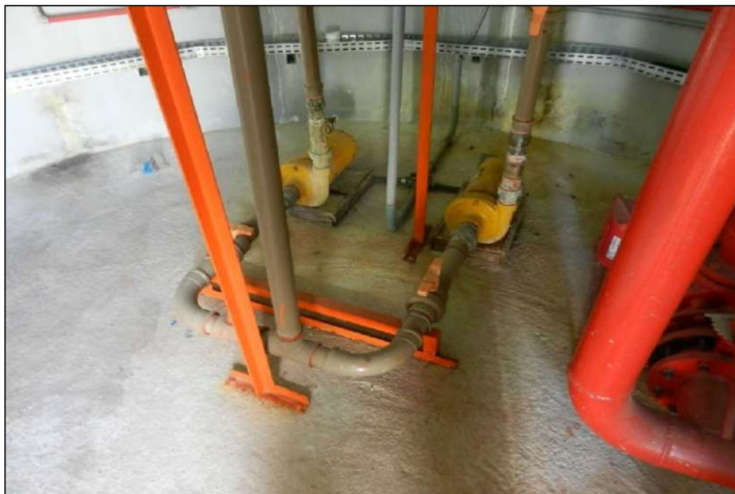
ITEM 1,131 - VISTA DAS 2 (DUAS) BOMBAS CENTRIFUGAS MARCA: JACUZZI MODELO: 3DM 1.1/2 COM MOTOR ELETRICO DE 3 CV
