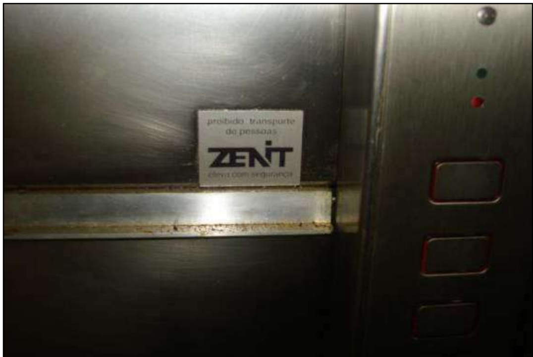
ITEM 1,047 - VISTA DO ELEVADOR MONTA CARGA ZENITAL MENTO
