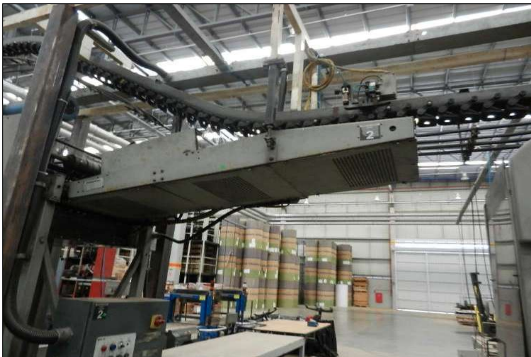
ITEM 1,094 - VISTA DA IMPRESSORA DE JORNAL MARCA: HEIDELBERG PLYMPIAN (DROP 2)
