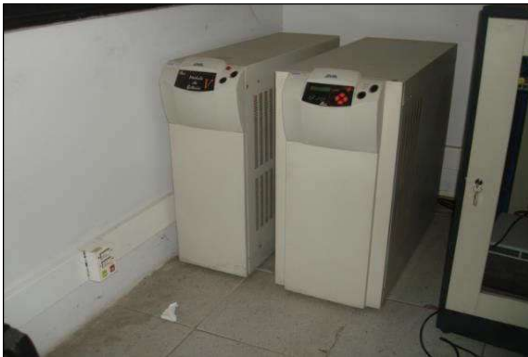
ITEM 0135 E ITEM 0136 - VISTA DO NO-BREAK 20KVA 60HZ MARCA: S.M.S. MOD: SINUS DOUBLE E DO MODULO DE BATERIA DO NO-BREAK MARCA: S.M.S. MOD: SINUS DOUBLE
