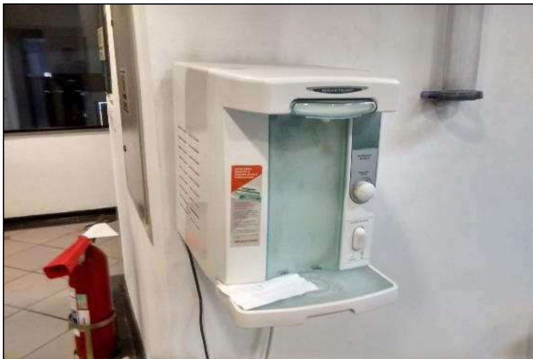
ITEM 1,200 - VISTA DO FILTRO DE ÁGUA (BRASTEMP)
