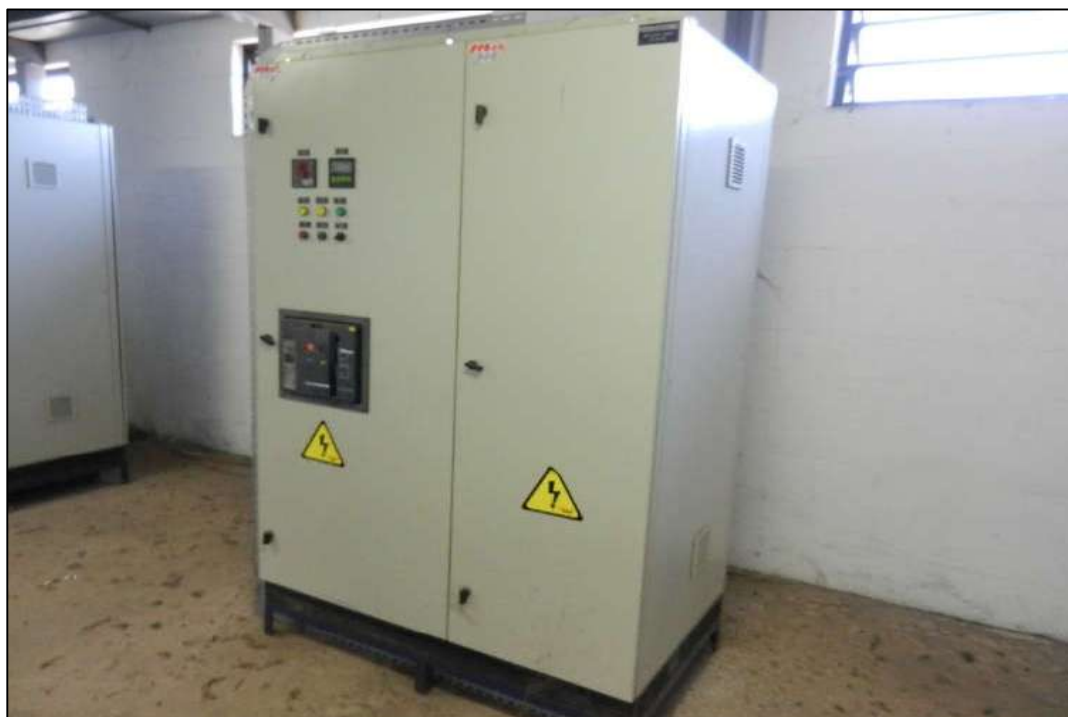
ITEM 1,124 - VISTA DO QUADRO DE COMANDO MARCA: MAK DIM: 2000 X 1400 X 850 MM TIPO: PGBT-04 - ROTATIVA 02 COM 1 DISJUNTOR GERAL MARCA: SCHNEIDER NW32H1 65 KA, MULTIMEDIDOR DE GRANDEZAS ELETRICAS, CONTROLADOR DE FATOR POTENCIA E DEMAIS COMPONENTES
