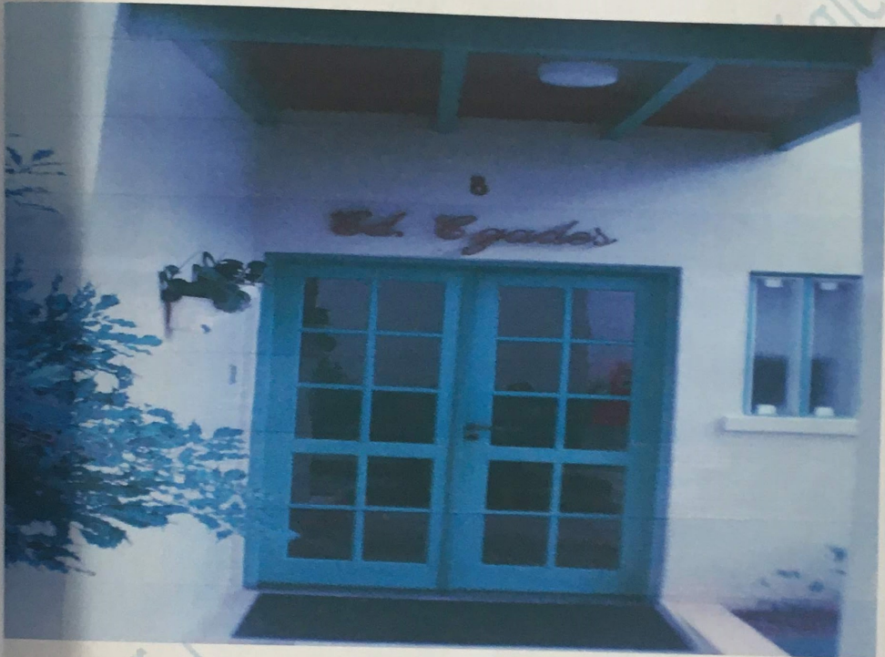
Porta de entrada do Bloco 8
