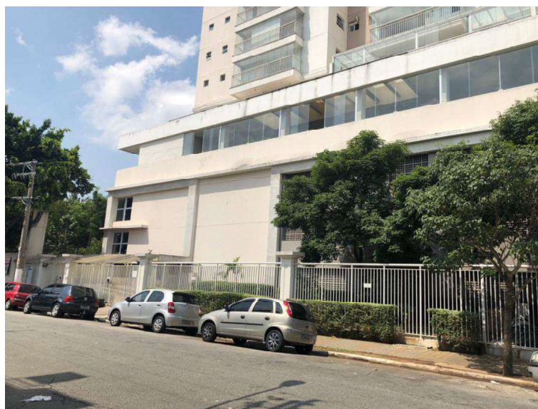
FOTO 02 Vista da portaria.
