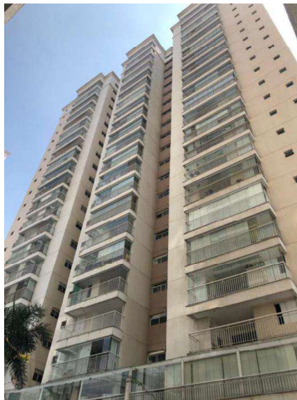
FOTO 01 Vista da fachada.
