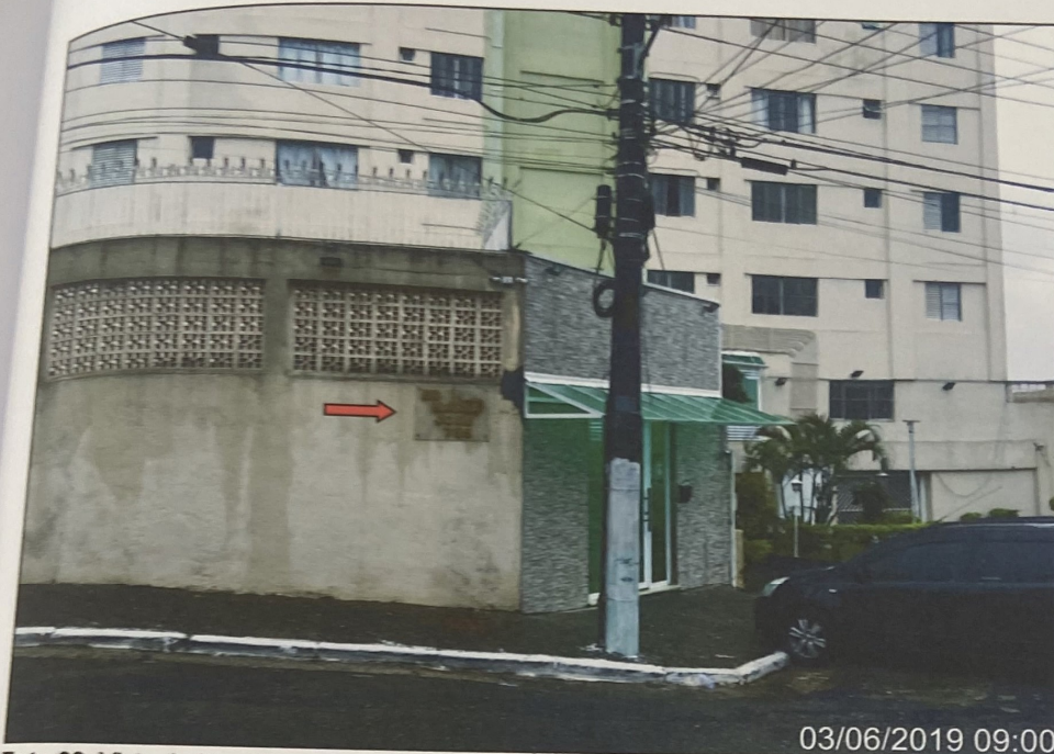
Foto 03: Vista da identificação na portaria do Edifício Maria José na Rua Isabel Velho nº795.
