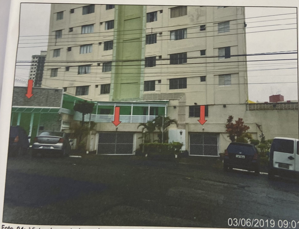
Foto 04: Vista da portaria e dos acessos às garagens do subsolo do Edifício Maria José localizado na Rua Isabel Velho nº795.
