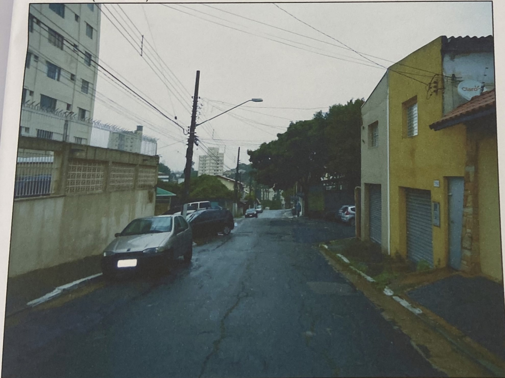
Foto 06: Vista do acesso e entorno do Edifício Maria José localizado na Rua Isabel Velho nº795.
