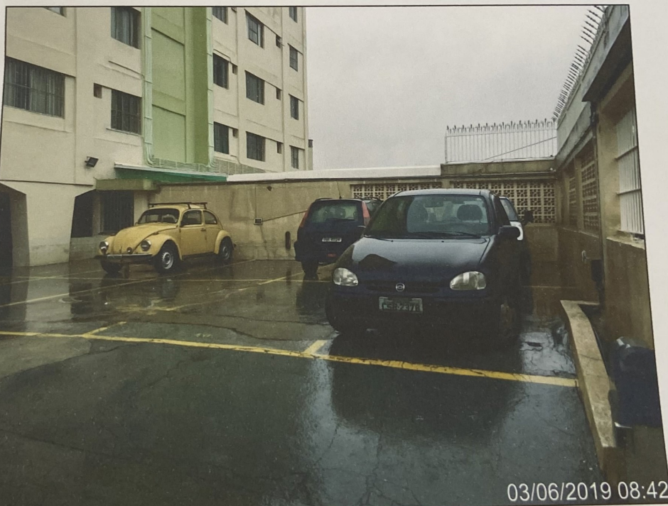
Foto 24: Vista da garagem descoberta no térreo do Edifício.
