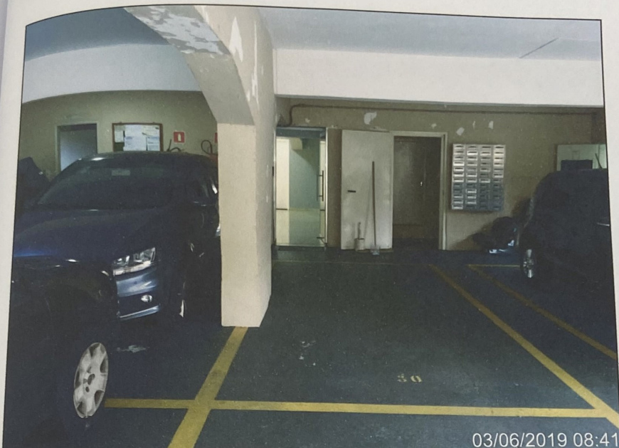
Foto 23: Vista da garagem coberta no térreo do Edifício.
