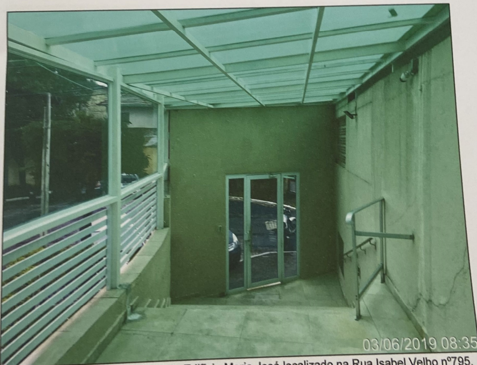
Foto 08: Vista interna da portaria do Edifício Maria José localizado na Rua Isabel Velho nº795.
