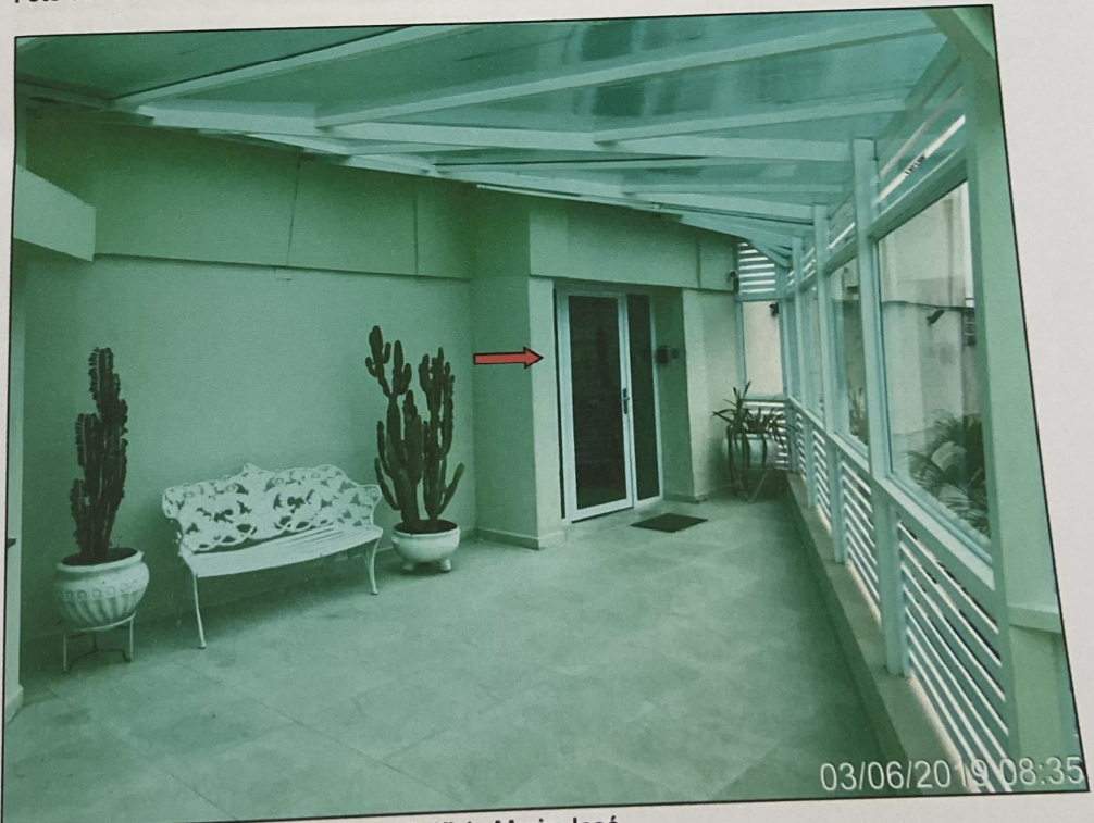
Foto 10: Vista da entrada social do Edifício Maria José.
