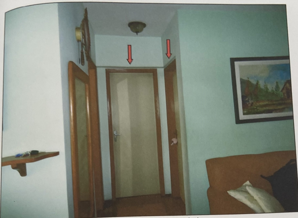
Foto 35: Vista das portas dos dormitórios (1) e (2) (destacados).
