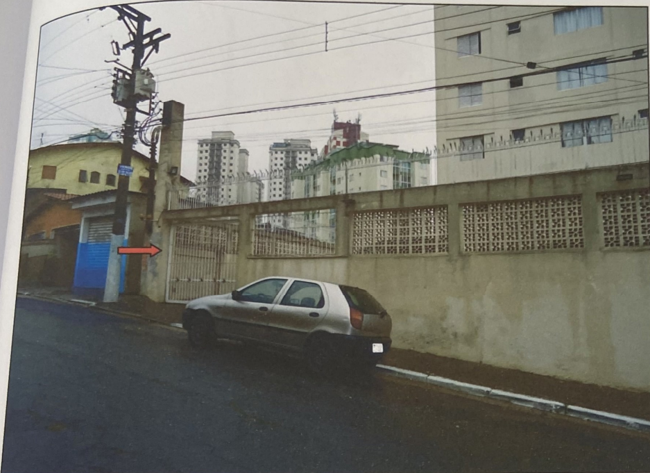
Foto 05: Vista do acesso à garagem no térreo do Edifício Maria José localizado na Rua Isabel Velho nº795 (destacado).
