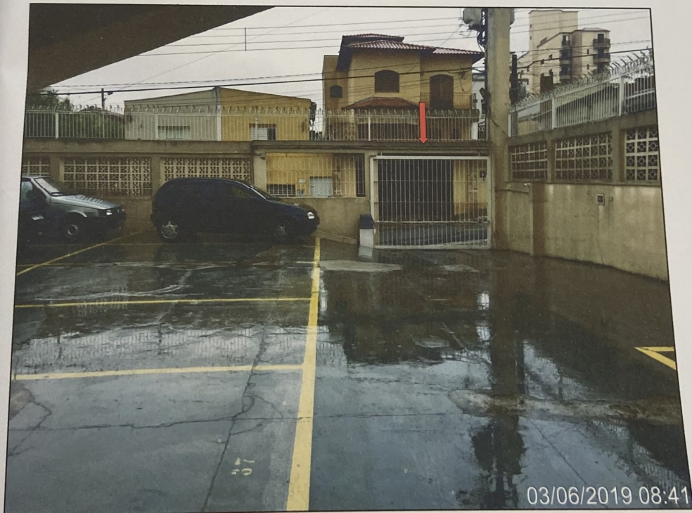
Foto 26: Vista do portão de acesso da garagem (coberta e descoberta) no térreo do Edifício.
