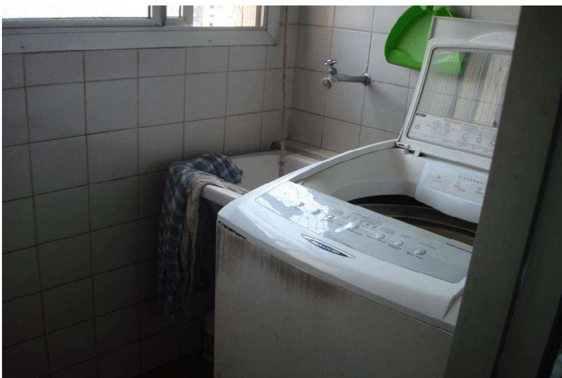
FOTO Nº 10 – Vista da área de serviço no apartamento avaliando.
